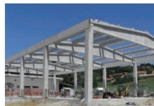
Slika 4 Betonska krovna konstrukcija
