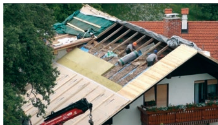
Toplinska izolacija postojećeg krova
