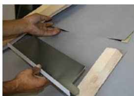
Ugradnja okapnice
