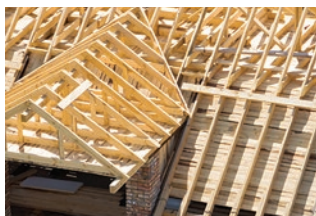
Slika 2 Drvena krovna konstrukcija
