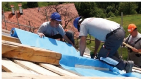
Postavljanje parne brane s gornje strane rogova
