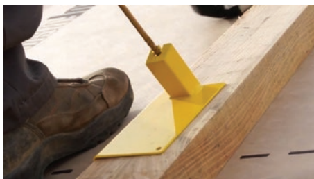
Pričvršćivanje kontraletvi na tvrde ploče mineralne vune
