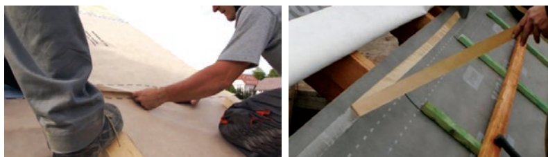
Slika 36 Postavljanje paropropusne-vodonepropusne folije
