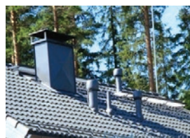
Primjeri prodora kroz krovnu konstrukciju
