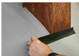
Lijepljenje folije na donji dio
