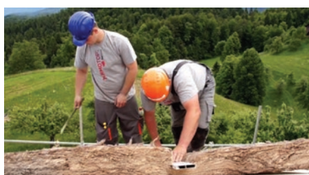
Rezanje mekane mineralne vune
