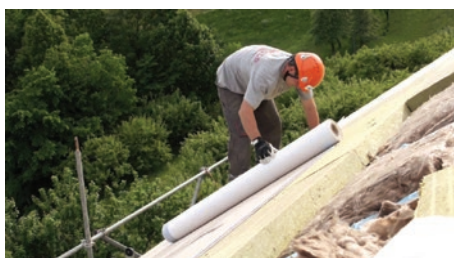
Izvedba paropropusne-vodonepropusne barijere
