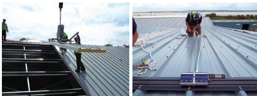
Slika 58 Prikaz pričvršćenja krovnih toplinsko-izolacijskih panela
