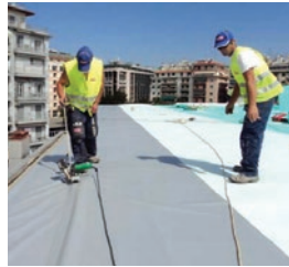
Slika 85 Izvedba hidroizolacije na ravan krov: samoljepljiva bitumenska traka, sintetičke krovne membrane
