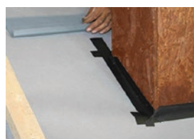
Ugradnja okapnice sa nagibom iznad dimnjaka
