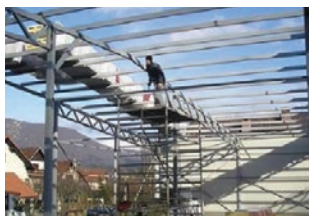
Slika 3 Čelična krovna konstrukcija
