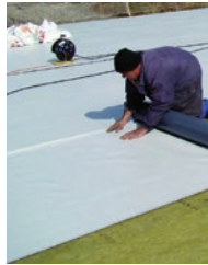
Slika 85 Izvedba hidroizolacije na ravan krov: samoljepljiva bitumenska traka, sintetičke krovne membrane
