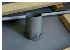
Ugradnja prodora - gornja strana
