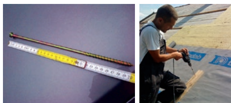
Slika 38 Pričvršćivanje kontraletvi ubušavanjem sistemskih vijaka
