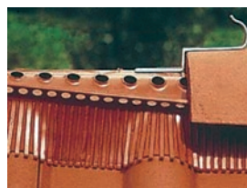
Elementi ventilacije na sljemenu i grebenu
