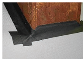
Zalijepiti bočni dio folije za dimnjak
