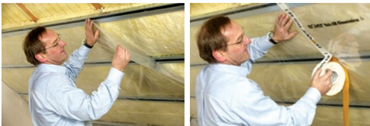
Slika 32 Postavljanje parne brane (paro i zrakonepropusne folije) s unutarnje strane krova
