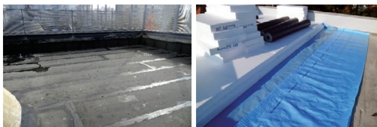
Slika 82 Parna brana od bitumenske trake s uloškom od Al folije i od PE folije (desno)
