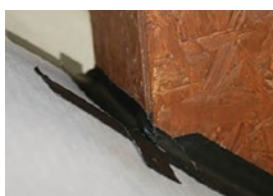
Lijepljenje gornjeg dijela dimnjaka
