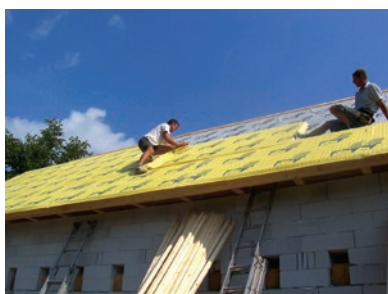
Slika 29 Postavljanje toplinske izolacije od tvrdih ploča toplinske izolacije od PUR-a ili PIR-a iznad rogova
