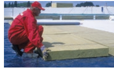
Slika 84 Postavljanje toplinske na ravan krov
