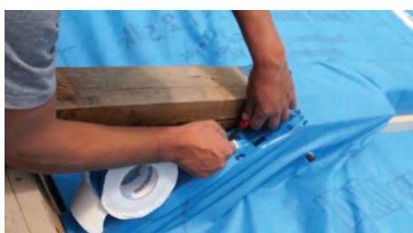
Brtvljenje detalja proboja parne brane posebnim trakama za lijepljenje
