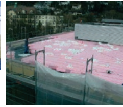
Slika 84 Postavljanje toplinske na ravan krov
