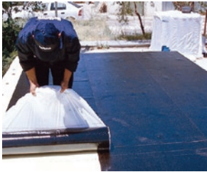
Slika 85 Izvedba hidroizolacije na ravan krov: samoljepljiva bitumenska traka, sintetičke krovne membrane
