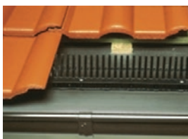
Ventilacijski elementi na strehi – ventilacijski češalj i mreža
