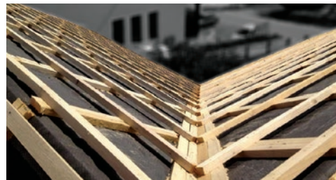
Slika 92 Izvedba krovne uvale
