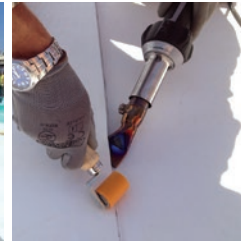
Slika 85 Izvedba hidroizolacije na ravan krov: samoljepljiva bitumenska traka, sintetičke krovne membrane
