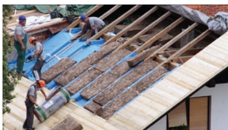
Postavljanje mekane mineralne vune između rogova
