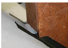
Dijagonalno izrezati ljepljivu traku
