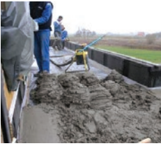
Slika 83 Izvedba betona za nagib
