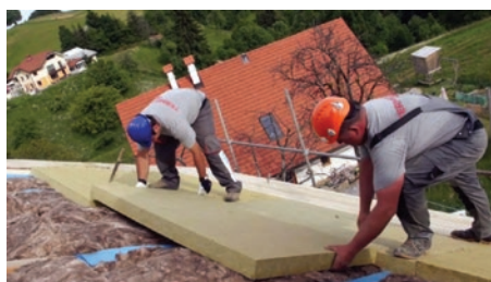
Postavljanje ploča tvrdoprešane mineralne vune iznad rogova
