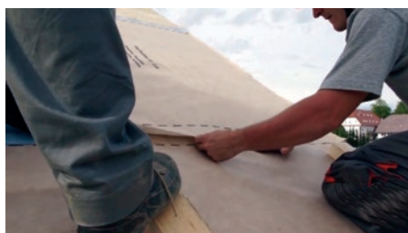
Postavljanje paropropusne-vodonepropusne folije s preklomom
