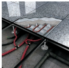
Slika 120 Izvedba podnog grijanja kod uzdignutog poda
