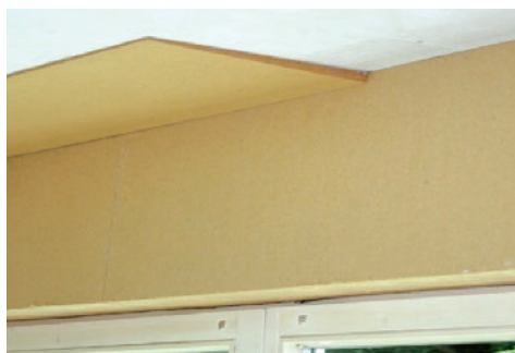
Slika 86 Prikaz klina toplinske izolacije susjednih građevnih dijelova
