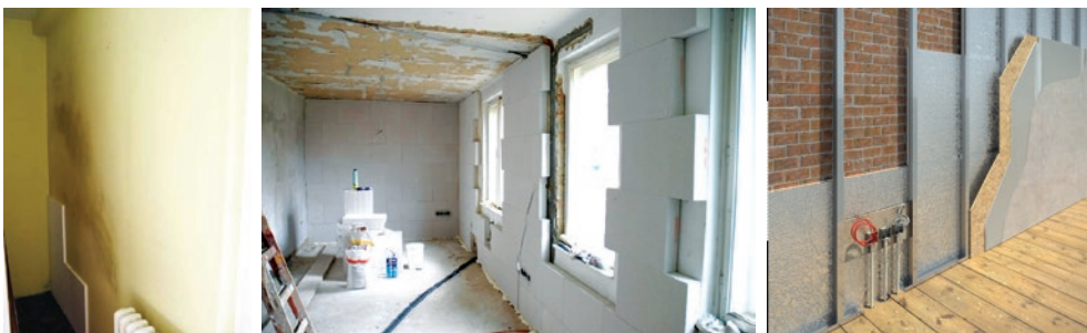
Slika 73 Primjeri izolacije s unutarnje strane
