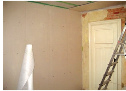
Postavljanje gipskartonskih ploča s fiksiranjem na mjestima drvenih nosača
