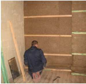
Postavljanje izolacije od industrijske konoplje između nosača potkonstrukcije
