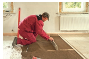
Primjer izvedbe estriha sa suhim nasipom
