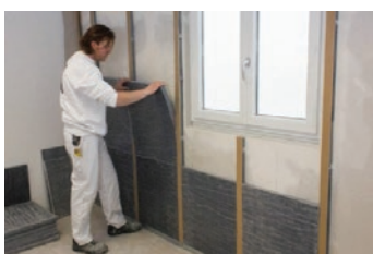
Ugradnja toplinske izolacije
