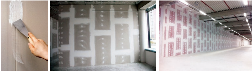
Slika 124 Primjena bandažne trake i ispunjivača spojeva
