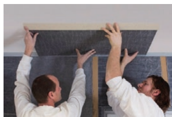
Učvršćenje toplinske izolacije na susjedne stropove i zidove
