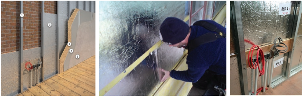
Slika 78 Prikaz unutarnje izolacije korištenjem vakuum izolacijskih ploča
