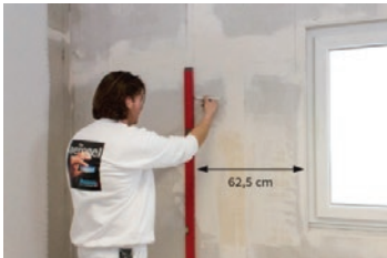
Postavljanje potkonstrukcije, drvene ili metalne
