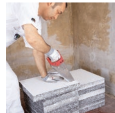
Ploče toplinske izolacije kroje se pilama ili nožem pri čemu ih je treba očistiti od prašine i prljavštine
