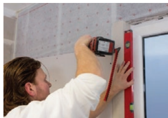
Ugradnja gipskartonskih ploča
