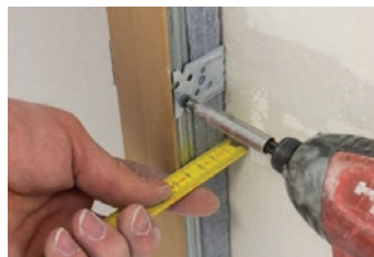
Ugradnja gipskartonskih ploča
