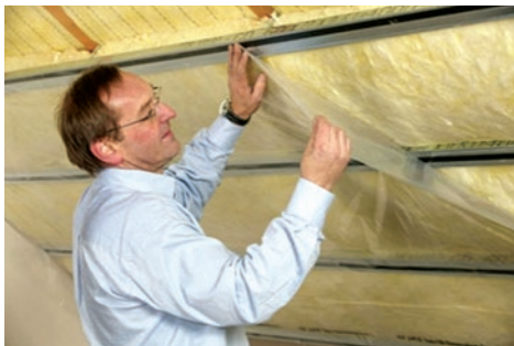
Slika 71 Postavljanje parne brane s pristupom iznutra
