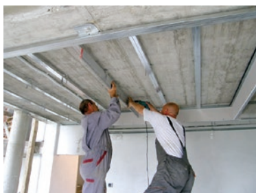
Slika 94 Spušteni strop s direktnim pričvršćenjem potkonstrukcije
