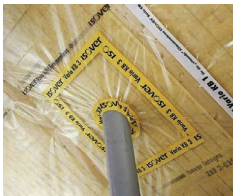
Slika 104 Lijepljenje parne brane i brtvljenje prodora
