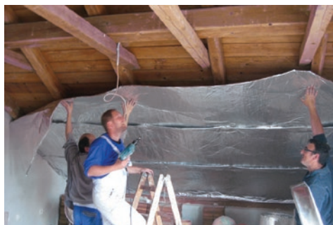
Slika 106 Primjer krovišta obloženo reflektirajućom folijom
