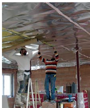
Slika 75 Prikaz postavljanja paronepropusnog sloja (parne brane) u slučaju unutarnje izolacije podgleda stropa
