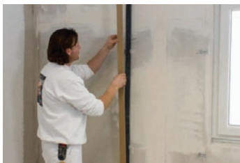
Ugradnja parne brane
