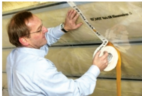
Slika 72 Lijepljenje parne brane s pristupom iznutra
