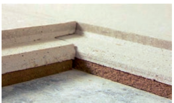
Postavljanje višeslojnih gipsvlaknastih ploča direktno na nosivu konstrukciju
