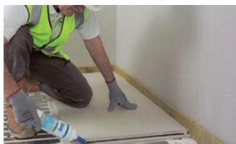
Postavljanje gipsanih ploča suhog estriha na izolacijski sloj
