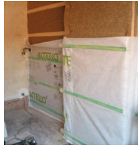
Postavljanje parne brane s fiksiranjem na drvene nosače, uz postavljanje parne brane na strop te okolne zidove
