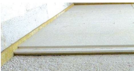
Slika 115 Primjer suhog estriha na nasipu od perlita
