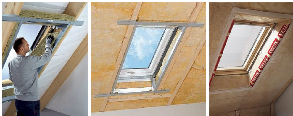
Slika 107 Postavljanje potkonstrukcije, toplinske izolacije i parne brane oko krovnog prozora
