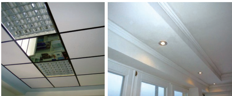
Slika 93 Spušteni stropovi prema vidljivosti potkonstrukcije
