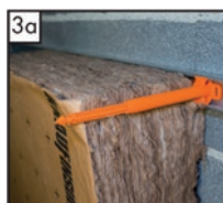
Ugradnja toplinske izolacije
