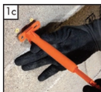
Ugradnja pričvrsnice direktno u zid
