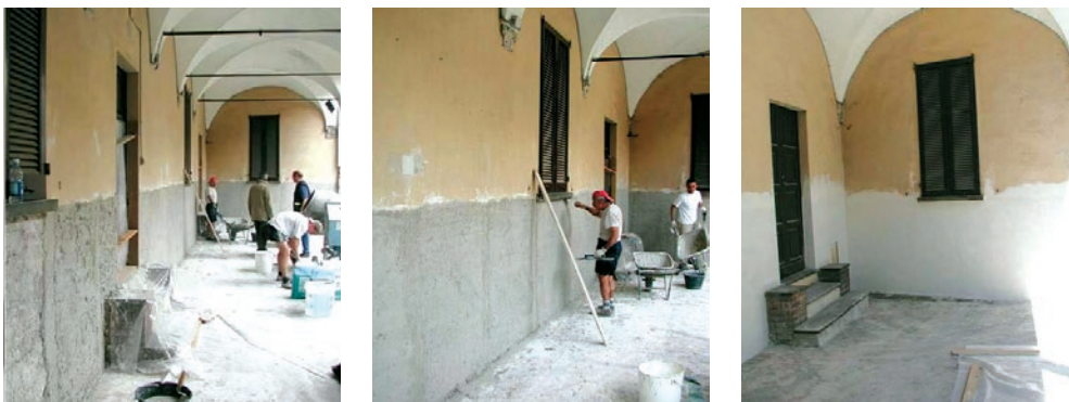
Slika 35 Primjer nanošenja temeljnog šprica, isušujuće te fine žbuke na postojeću zgradu
