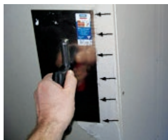
Nanošenje mase na spoj
