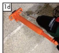
Ugradnja pričvrsnice direktno u zid
