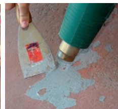
Slika 18 Električni fen za skidanje stare boje
