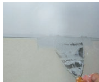
Obrada spojeva ploča sa zidom ili plafonom
