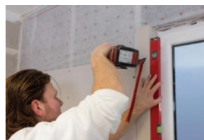
Ugradnja gipskartonskih ploča
