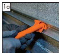
Ugradnja pričvrsnice u metalnu vodilicu
