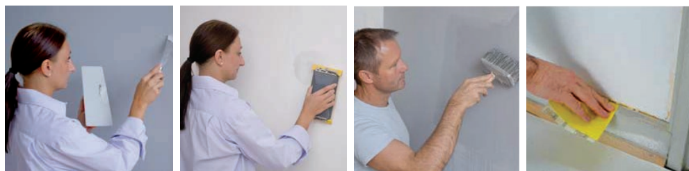
Slika 48 Priprema podloge
