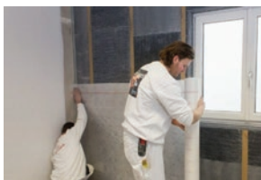
Ugradnja parne brane
