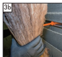
Ugradnja toplinske izolacije
