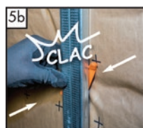
Izvlačenje teleskopske prič Ugradnja i pričvršćenje metalne potkonstrukcije za izvođenje obloge od gipskartonskih ploča vrsnice do potrebne debljine toplinske izolacije
