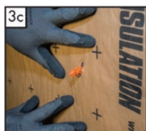
Izvlačenje teleskopske pričvrsnice do potrebne debljine toplinske izolacije
