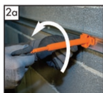
Izvlačenje teleskopske pričvrsnice do potrebne debljine toplinske izolacije
