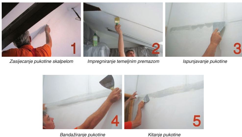
Slika 43 Ispravljanje pukotina već obrađenih gipskartonskih ploča
