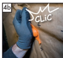
Pričvršćenje toplinske izolacije pomoću odgovarajuće spojnice (kapice)
