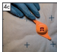
Ugradnja toplinske izolacije
