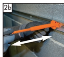
Izvlačenje teleskopske pričvrsnice do potrebne debljine toplinske izolacije
