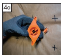
Pričvršćenje toplinske izolacije pomoću odgovarajuće spojnice (kapice)
