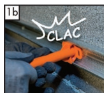
Ugradnja pričvrsnice u metalnu vodilicu
