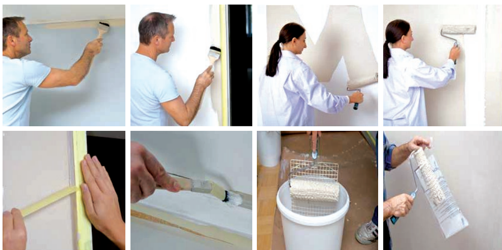
Slika 50 Postupak ličenja zida i čišćenje alata
