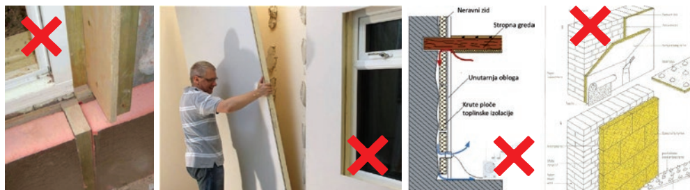
Slika 29 Prikaz loše ugradnje sustava unutarnje toplinske izolacije
