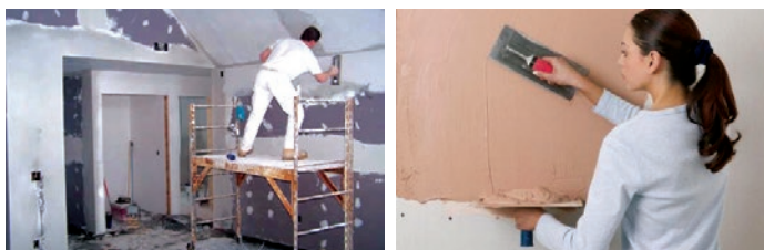
Slika 42 Gletanje gipskartonskih ploča
