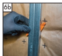
Izvlačenje teleskopske prič Ugradnja i pričvršćenje metalne potkonstrukcije za izvođenje obloge od gipskartonskih ploča vrsnice do potrebne debljine toplinske izolacije
