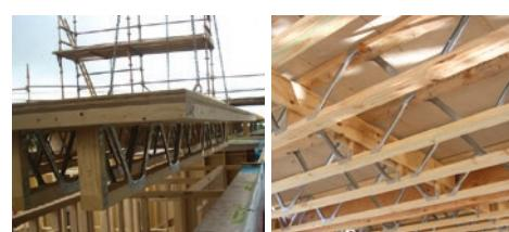
*Slika 14* Lagani nosači s drvenim pojascicama i čeličnim dijagonalama
