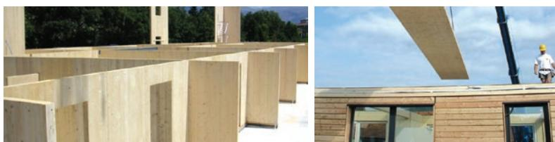
*Slika 32* Primjeri gradnje zgrada pomoći križno lameliranih ploča
