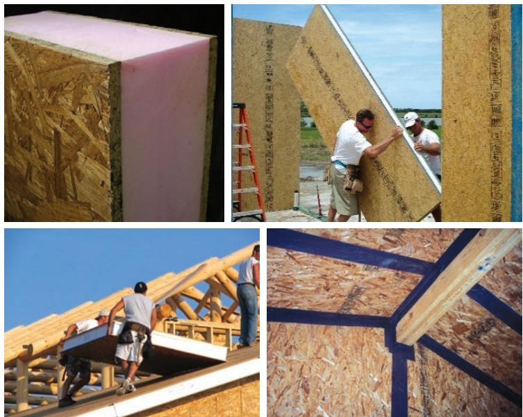
*Slika 15 Drveni SIP paneli, montaža i brtvljenje*
