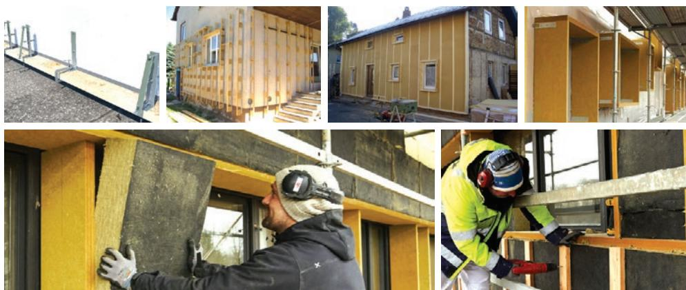
**Slika 87** Prikaz postavljanja drvene potkonstrukcije na postojeću zgradu, ugradnje okvira oko prozora radi lakše ugradnje novog prozora te ugradnje toplinske izolacije i osiguranje sloja ventiliрајућег zraka
