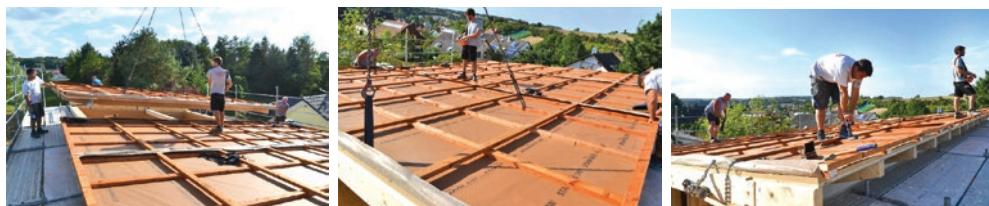
*Slika 76 Primjer izvedbe ventiliranog krova s pokrovom od trapeznog lima korištenjem predgotovljenih krovnih elemenata*
