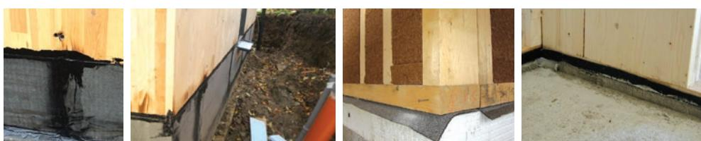
Slika 43 Primjer izvedbe i napuštanja hidroizolacije podnožja zgrade zbog izvođenja preklopa kod drvenih zgrada prije izvedbe ETICS fasadnog sustava
