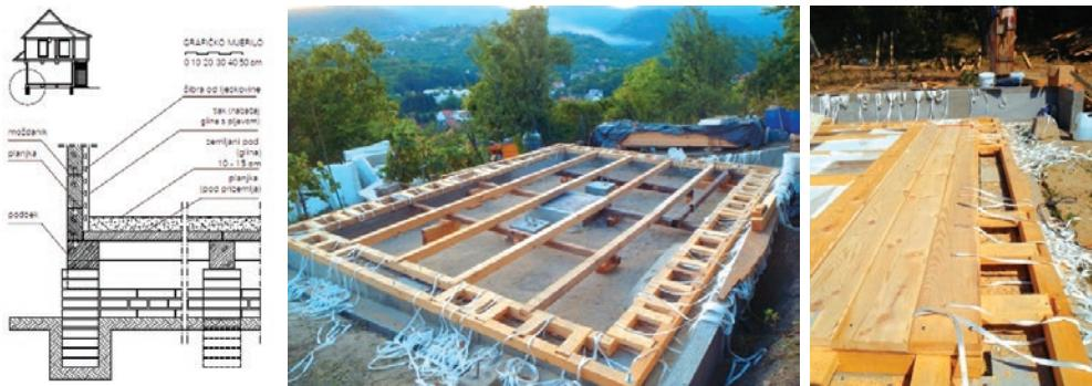
**Slika 46** Detalj podne konstrukcije tradicijske posavske drvene kuće; izvođenje drvenog roštilja uzdignutog poda novosagrađene kuće
