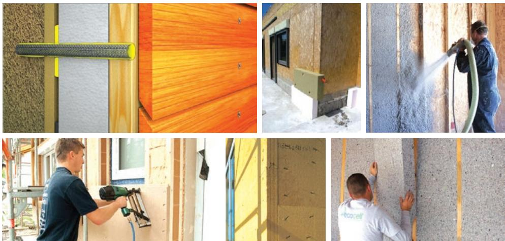
*Slika 49* Primjeri načina pričvršćivanja izolacije za drvenu konstrukciju
