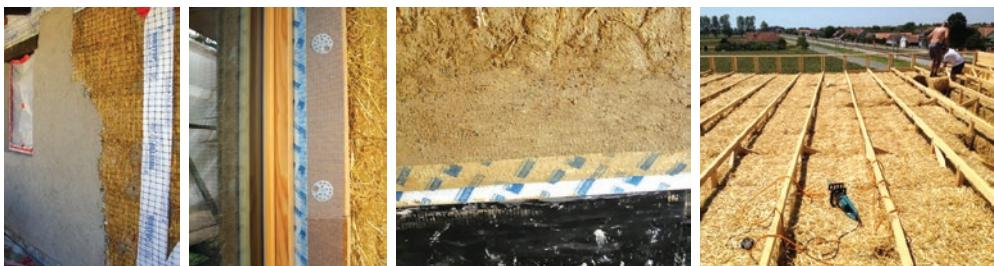
**Slika 80** Primjer ostvarenja zrakonepropusnosti ovojnica zgrade s ispunom od slame: **a)** žbuka s vanjske i unutarnje strane (vapnena ili glinena); **b)** brtvljenje prozora specijaliziranim trakama; **c)** brtvljenje spoja poda i zida
