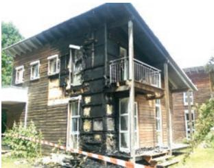
**Slika 66** Primjer požara koji su se proširili po fasadi drvene zgrade
