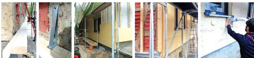
**Slika 86** Prikaz postupka izvođenja toplinske izolacije postoeće zgrade s vanjske strane upuhivanjem rasute toplinske izolacije
