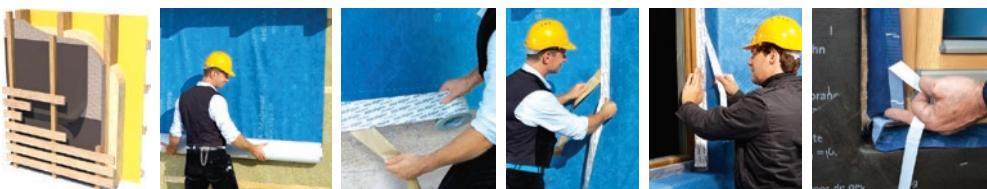
**Slika 60** Primjer postavljanja paropropusno-vodonepropusne folije na drvenu potkonstrukciju ventilirane fasade drvene zgrade
