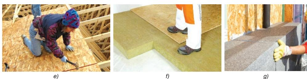
Slika 10 Ploče iverice: a) građevinska iverica; b) OSB ploča; c) QSB ploča; d) izvedba zrakonepropusne ovojnice korištenjem OSB ploča; e) daščanje krovija; f) suhi estrih korištenjem OSB ploča; g) izvedba ETICS sustava na podlogu od OSB ploča
