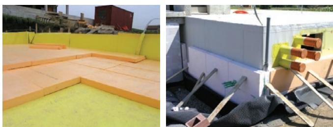
*Slika 45* Prikaz izvođenja perimetarske toplinske izolacije betonskog temelja korištenjem XPS-a
