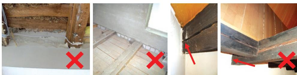
Slika 57 Primjeri nezabrtvlenih probava greda drvenih stropova prilikom energetske obnove zgrade
