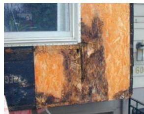
Loše brtvljenje "kišne brane" zgrade pri ugradnji prozora
