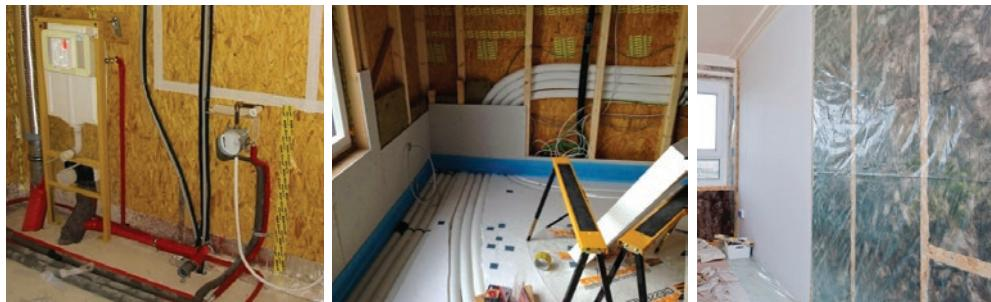
**Slika 68** Primjer postavljanja instalacija u drvenu kuću te oblaganje parnom branom i gipskartonskim pločama
