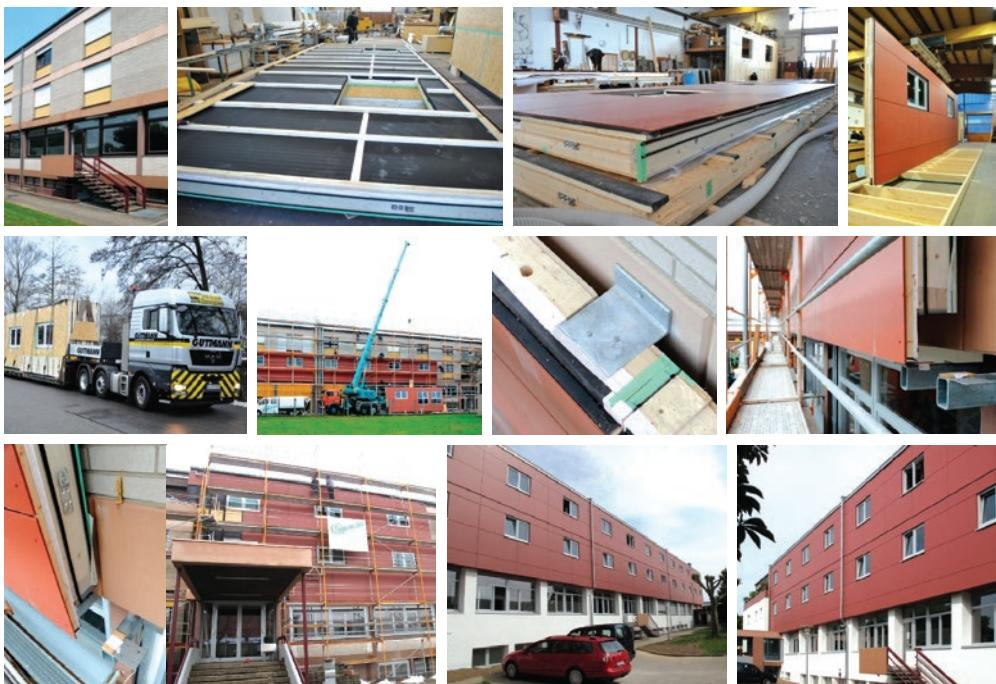
**Slika 88** Prikaz energetske obnove zgrade korištenjem predgotovljenih drvenih panela
