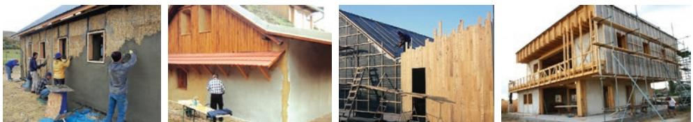
**Slika 81** Primjer žbukane završne obloge te ventilirane fasade s drvenom oblogom
