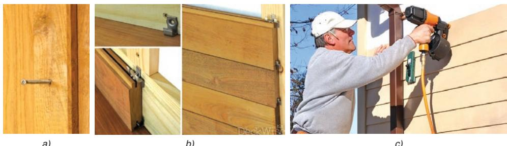
**Slika 62** Načini pričvršćenja drvene vanjske obloge: **a)** pričvršćenje vijkom za drvo; **b)** nevidljivo vješanje; **c)** pričvršćenje pribijanjem
