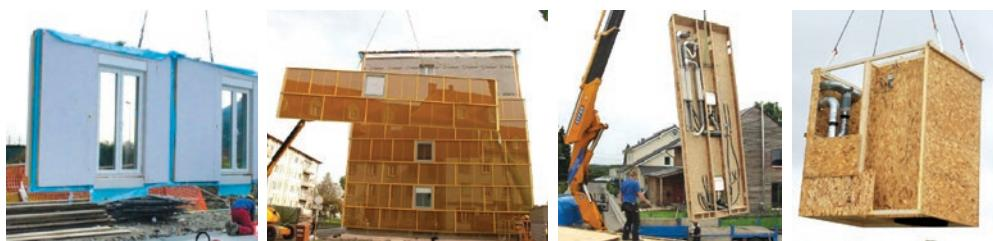
*Slika 31* Primjeri drvenih montažnih panela
