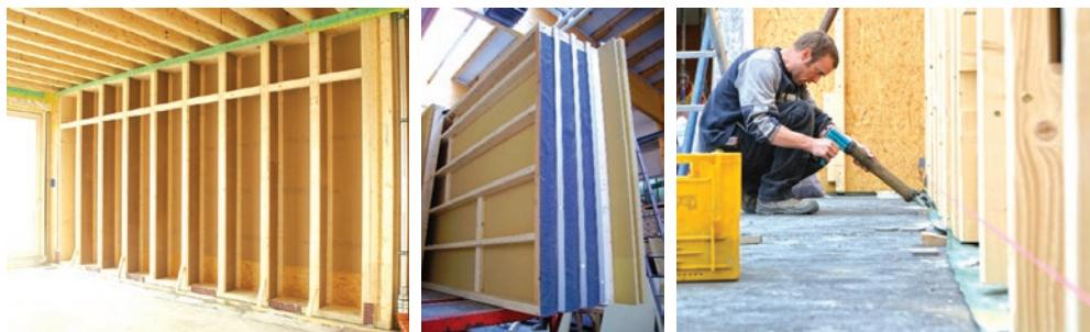
Slika 56 Primjeri dobrog planiranje i pripreme olakšava brtvljenje zrakonepropusne ovojnice
