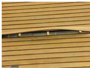
Izvijanje daske vanjske obloge
