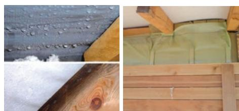
*Slika 59* Primjer kondenzacije vodene pare na PE foliji
