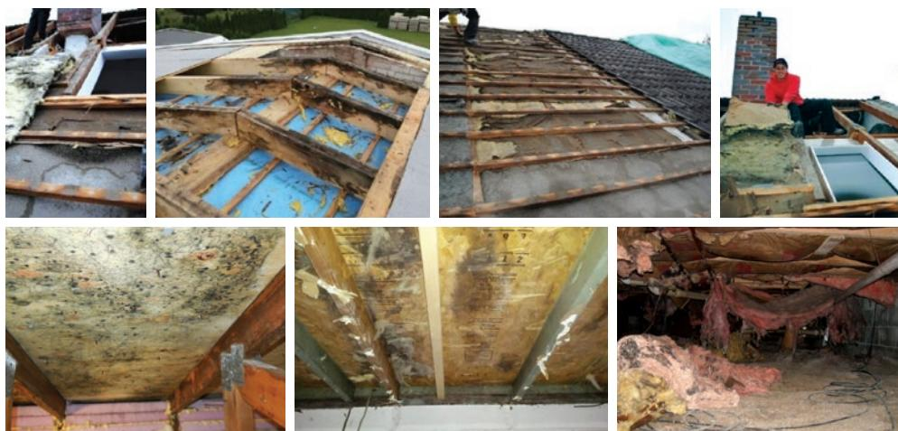
Primjeri građevinske štete nastale u slučaju lošeg funkcioniranja krova
