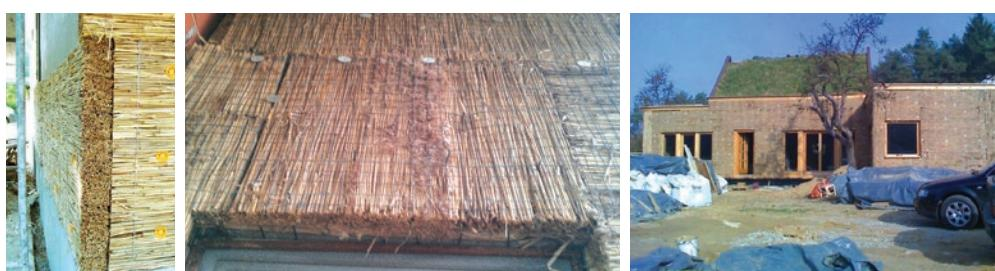
*Slika 83 Primjer ugradnje ploča od trstike kao toplinske izolacije s vanjske strane*
