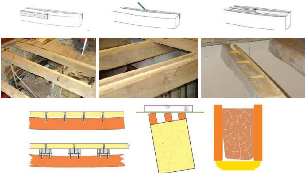
**Slika 72** Primjer izravnjanja progiba te izravnjanja izvijanja postojeće drvene greda
