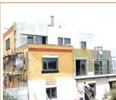
Izvođenje ETICS sustava na vlažnu podlogu od OSB ploča
