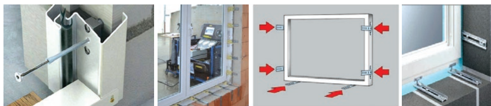
Slika 8 Prikaz mehaničkog učvršćenja prozora
