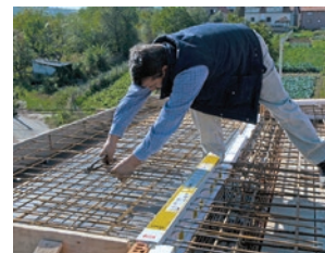
Slika 18 Primjer ugradnje specijaliziranog elementa za prekid linijskog toplinskog mosta
