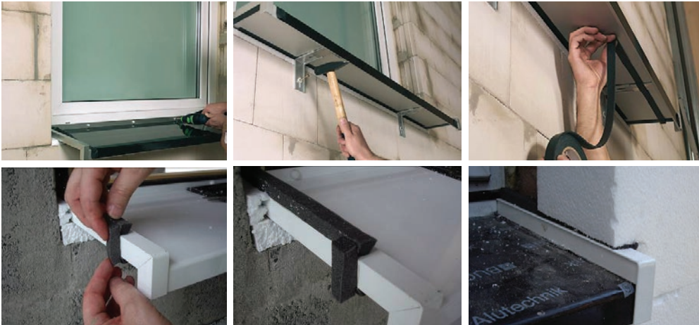
Slika 39 Ugradnje i brtvljenje prozorske klupčice
