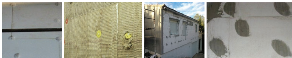
Slika 26 Primjeri loše postavljениh pričvrsnica, te naknadnog izravnavanja korištenjem polimercementnog ljepila
