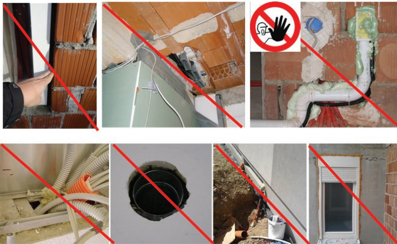
Slika 33 Primjeri nepravilnog brtvljenja prodora i ugradnje elemenata (nije osigurana zrakonepropusnost)
