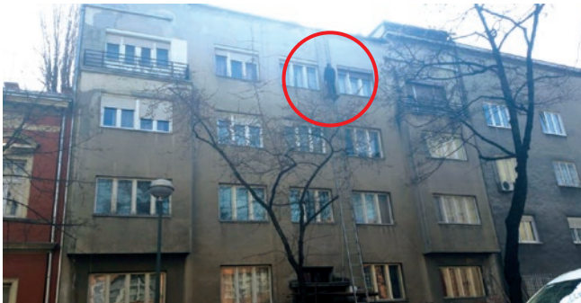
Slika 8 Primjer ne pridržavanja mjere zaštite na radu (prijevoz radnika na nezaštićenoj platformi)
