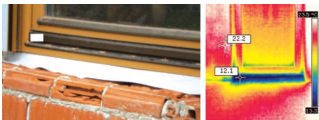
Slika 10 Prikaz nemogućnosti brtvljenja kod neobrađene špalete, te primjer termograma nezabrtvljenog okvira prozora
