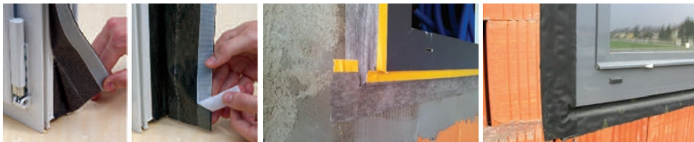
Slika 16 Vanjska strana prozora: Paropropusna i vodonepropusna folija – sprečavanje ulaska vode u spoj, a ujedno omogućava propuštanje vodene pare iz spoja prema van
