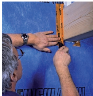
Koristiti specijalne trake za brtvljenje (ne univerzalne)
