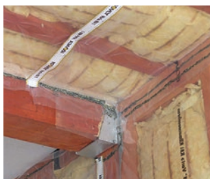
Pravilno spajanje parne brane s konstruktivnim elementima
