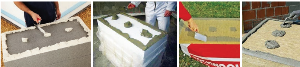
Slika 11 Ručno nanošenje morta za lijepljenje metodom „rubno-točkastog“ nanošenja uz izvođenje kontaktnog sloja kod ploča od mineralne vune
