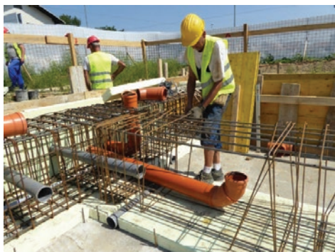
Slika 21 Izoliranje temelja toplinskom izolacijom
