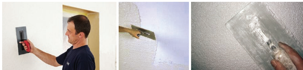
Slika 44 Nanošenje završno-dekorativne žbuke
