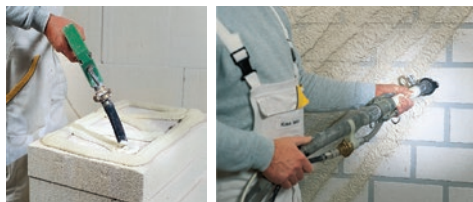
Slika 13 Strojno nanošenje morta za lijepljenje metodom „rubno-točkastog“ na ploče, a ne direktno na zid
