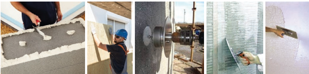
Slika 2 Osnovne faze izvođenja ETICS sustava
