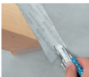
Brtvljenje oko drvenih nosača
