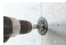
Montiranje pričvrsnica na izolaciju
