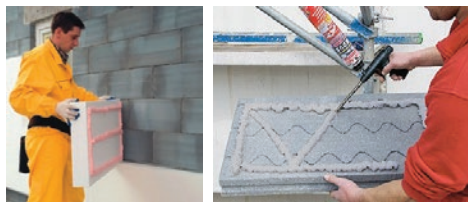
Slika 14 Jednokomponentno PUR ljepilo za lijepljenje EPS-a
