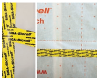
Izgled spoja ljepljen jednostruko ljepljivim trakama
