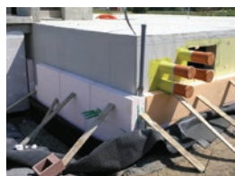
Slika 5 Toplinska izolacija zida prema tlu
