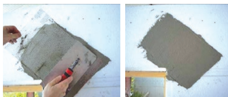
Slika 30 Dijagonalno armiranje uglova prozora
