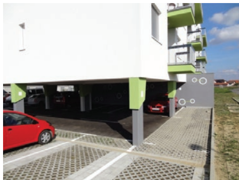
Slika 22 Produljenje toplinske izolacije stupa (zeleno)
