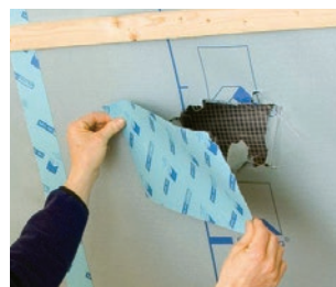
Ugradnja dodatne folije na mjestu loma
