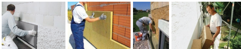
Slika 3 Izvedba ETICS sustava na različite vrste podloga: porobeton, opeka, OSB ploče, postojeća žbuka dobre kvalitete
