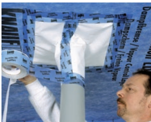
Pravilno brtvljenje proboja kroz parnu branu
