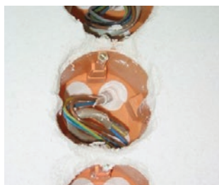
Ugradnja razvodnih kutija s gumenom opnom
