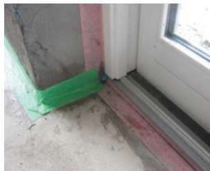
Brtvljenje spoja zida i poda posebnim trakama; RAL ugradnja vrata
