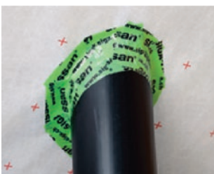
Malim komadima trake obujmiti cijelu cijev
