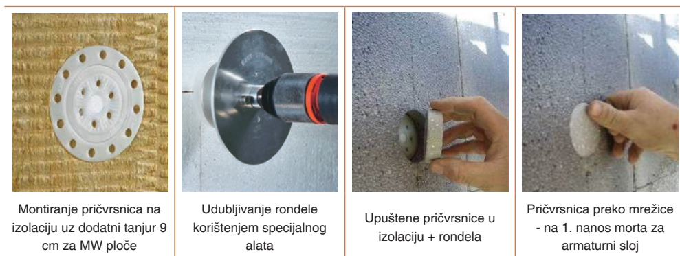
Tablica 3 Montiranje pričvrsnica
