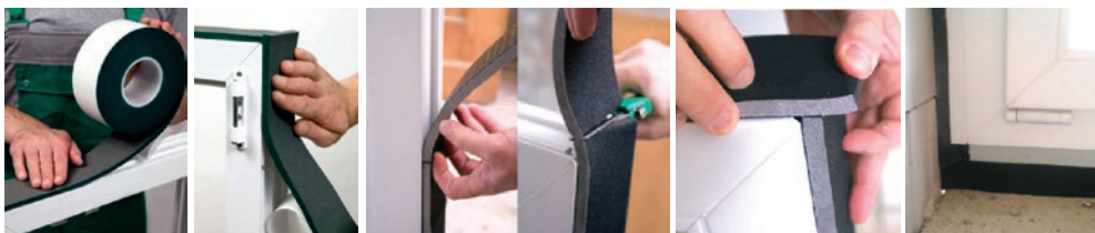
Slika 17 Brtvljenje pomoću brtvenih traka
