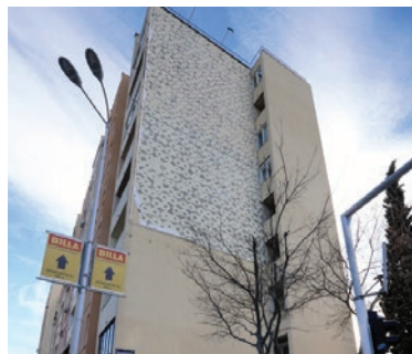
Slika 47 Neadekvatno ugrađen ETICS sustav, Vukovar, svibanj 2010.
