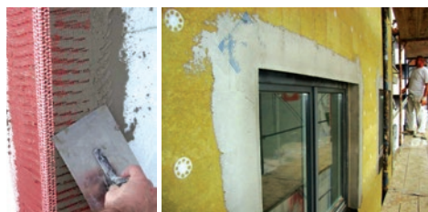
Slika 33 Izvedba ruba i kuta pomoću kutnog profila
