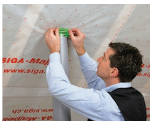
Brtvljenje proboja: polatrake na foliju, a pola na cijev
