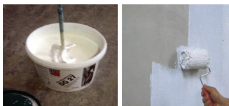
Slika 43 Miješanje i nanošenje predpremaza
