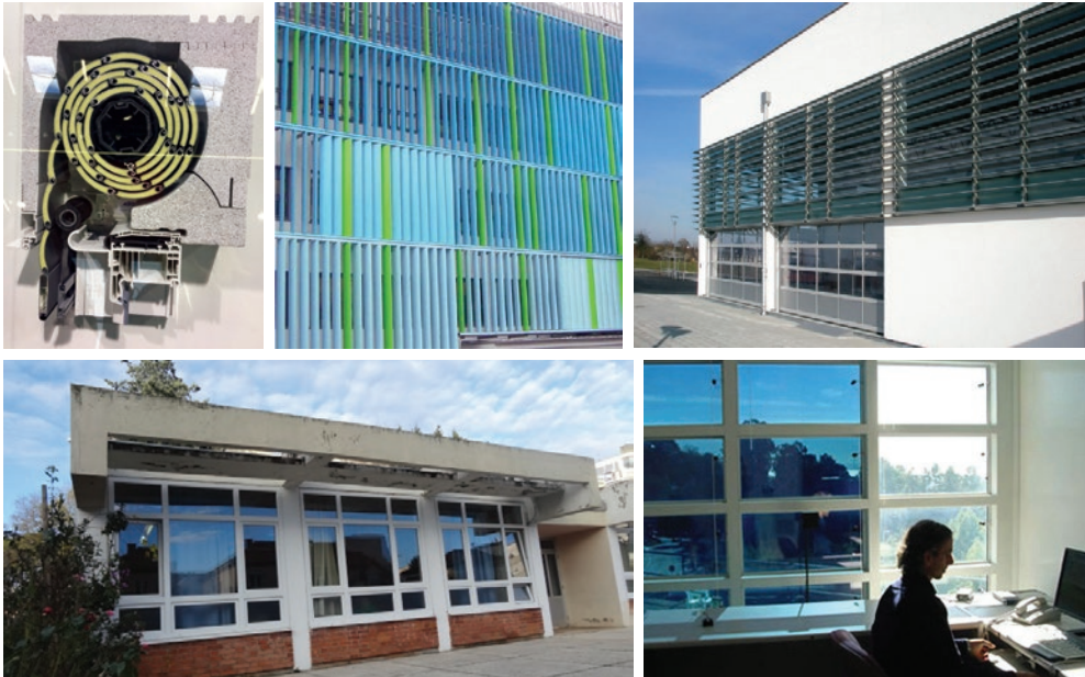
Slika 13 Primjeri različitih sustava zaštite od sunca (izolirane rolete, pomične i fiksne brisoleje, elektrokromirano staklo-pametno staklo)
