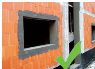
Slika 9 Prikaz ožbukane špalete zidarskog otvora
