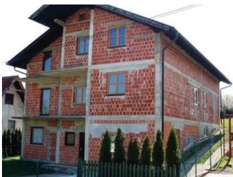
Slika 2 Kuće bez završne žbuke (nedovršene)
