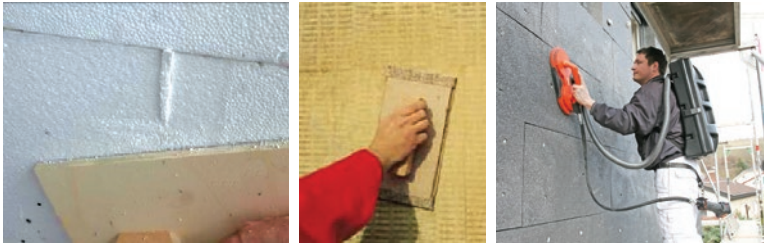
Slika 18 Brušenje EPS-a i mineralne vune
