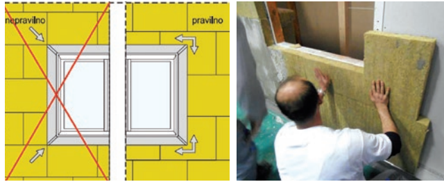
Slika 17 Postavljanje toplinsko-izolacijske ploče oko prozora – rezanje ploča
