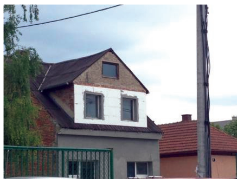
Slika 3 Postoji svijest o potrebi ugradnje toplinske izolacije, ali na neprimjeren način
