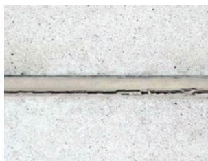
Slika 25 Brtvilo se ne smije nanositi u prekomjernim količinama (npr. po cijeloj debljini presjeka panela) - PUCANJE VEZE
