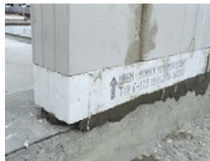
Primjer ugradnje Schoeck Novumur sustava
