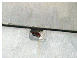
Slika 20 Usadna kuka, koja omogućava montažu panela
