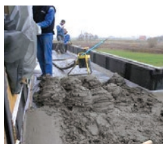
Slika 54 Izvedba betona za nagib
