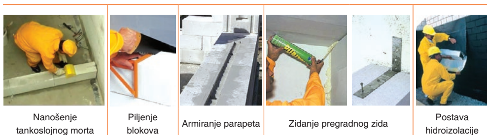
Tablica 10 Zidanje plinobetonom
