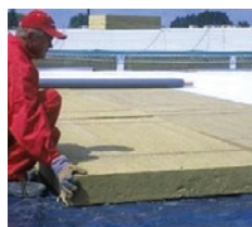
Slika 55 Postavljanje toplinske na ravan krov
