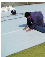
Slika 56 Izvedba hidroizolacije na ravan krov: samoljepljiva bitumenska traka, sintetičke krovne membrane
