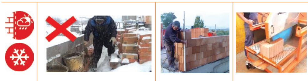
Tablica 8 Važnost zaštite od padalina, kontrole vertikalnosti, rezanje opeke stolnom pilom
