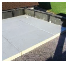
Slika 54 Izvedba betona za nagib
