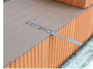
Slika 15 Spoj nosivog i pregradnog zida
