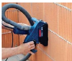
Alat za urezivanje kanala za električne instalacije
