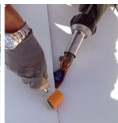
Slika 56 Izvedba hidroizolacije na ravan krov: samoljepljiva bitumenska traka, sintetičke krovne membrane
