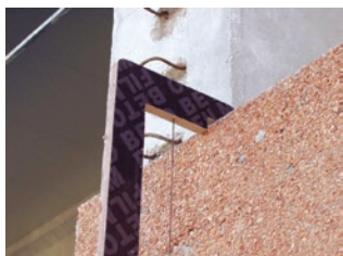
Slika 18 Namještanje predgotovljenih betonskih panela
