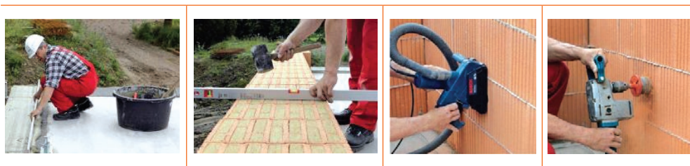
Tablica 9 Važnost izvedbe izravnavajućeg sloja morta i prvog sloja opeke, urezivanje kanala za električne instalacije
