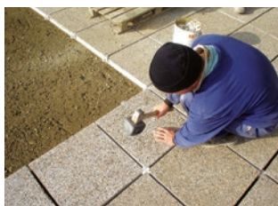
Izvedba vanjskih staza
