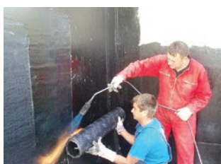
Izvedba hidroizolacije
