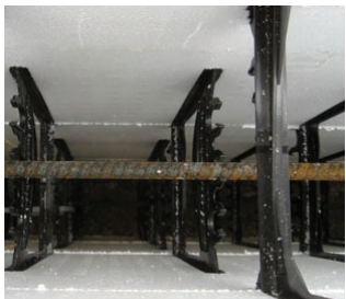
Slika 27 Modularni sustav izolirane oplata za betonske zidove
