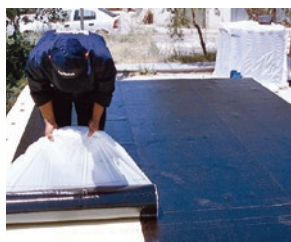
Slika 56 Izvedba hidroizolacije na ravan krov: samoljepljiva bitumenska traka, sintetičke krovne membrane
