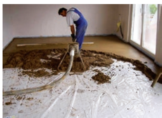
Izvedba podnih podloga
