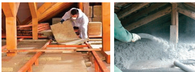
Slika 46 Postavljanje TI na pod tavana
