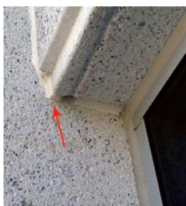
Slika 22 Rupa za odvođenje vlage iz predgotovljenih betonskih zidnih panela
