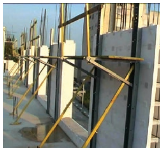
Slika 30 Podupiranje oplata ICF sustava
