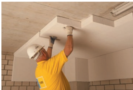
Slika 44 TI podgleda stropa negrijane prostorije ili pak iznad otvorenog prostora
