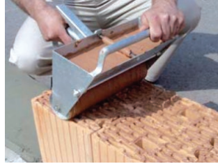
Slika 14 Nanošenje morta sa specijalnim valjkom za zidanje
