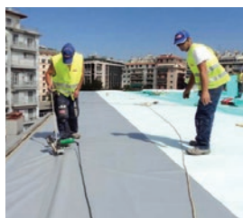
Slika 56 Izvedba hidroizolacije na ravan krov: samoljepljiva bitumenska traka, sintetičke krovne membrane
