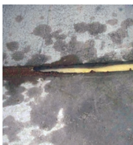
Slika 21 Baza (podloga) u reški prije brtvljenja
