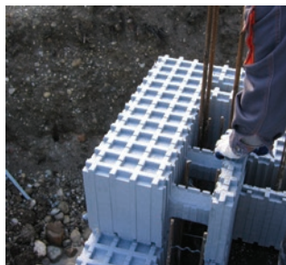
Slika 29 Zid ukupne debljine 43 cm građen ICF sustavom
