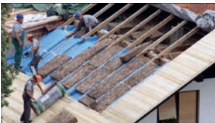
5) Postavljanje mekane mineralne vune između rogova
