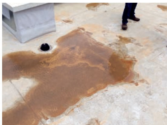
Slika 6-43 Primjer neučinkovite odvodnje s neprohodnog ravnog krova zbog ugažene toplinske izolacije [7]
