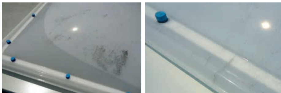
Slika 1-192 Primjer ulaska vode u samu kupolu, kod koje je uslijed djelovanja UV zračenja došlo do starenja materijala i pucanja [7]
