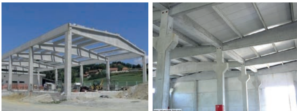
Slika 1-19 Primjer betonske krovne konstrukcije i pokrova [7]
