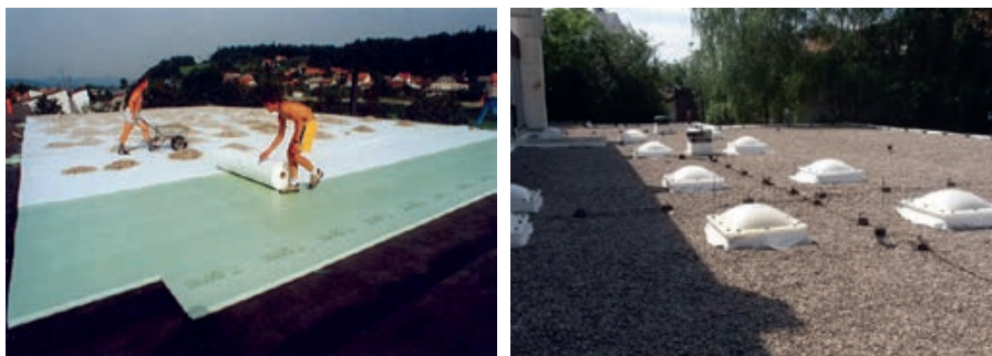
Slika 6-20 Opterećenje obrnutog ravnog krova nasipom od oblutaka [339]
