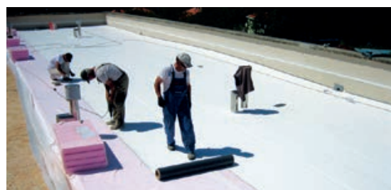
Slika 6-24 Postavljanje hidroizolacijske membrane na sloj staklenog voala [340]
