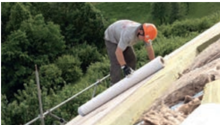
7) Izvedba paropropusne-vodonepropusne barijere
