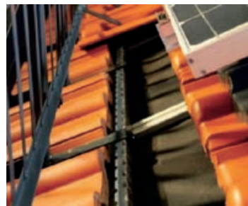
Slika 2-37 Držači rešetke snjegobrana [174]
