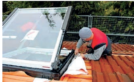
Slika 1-62 Primjer brtvljenja kišne brane na krovni prozor [44]
