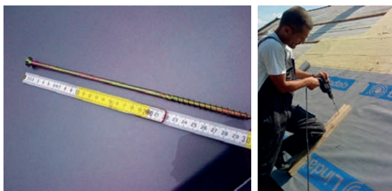
Slika 2-18 Pričvršćivanje kontraletvi ubušavanjem sistemskih vijaka SFS-WFR-T-6x240 mm [155]
