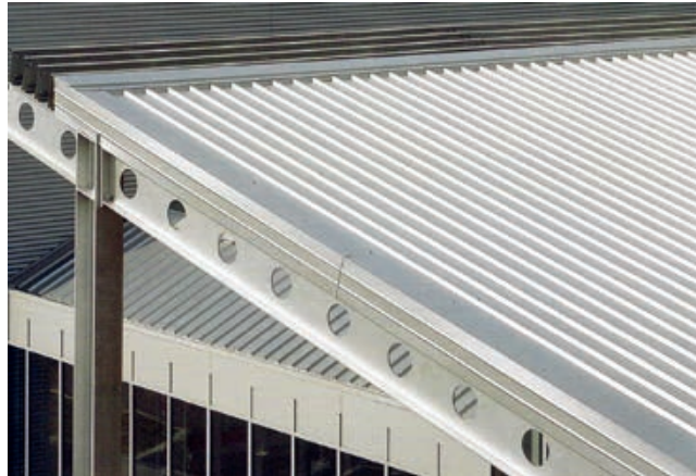
Slika 3-120 Krov od toplinsko-izolacijskih panela [4]
