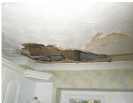
Slika 1-63 Štete uzrokovane lošom izvedbom kišne brane [45], [46]
