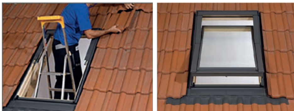
Slika 1-171 Postavljanje crijeva iznad prozora i izgled prozora nakon ugradnje [130]
