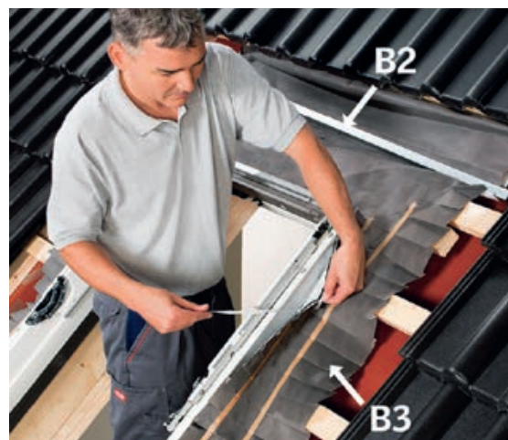
Slika 1-167 Ugradnja hidroizolacije oko prozora [128]
