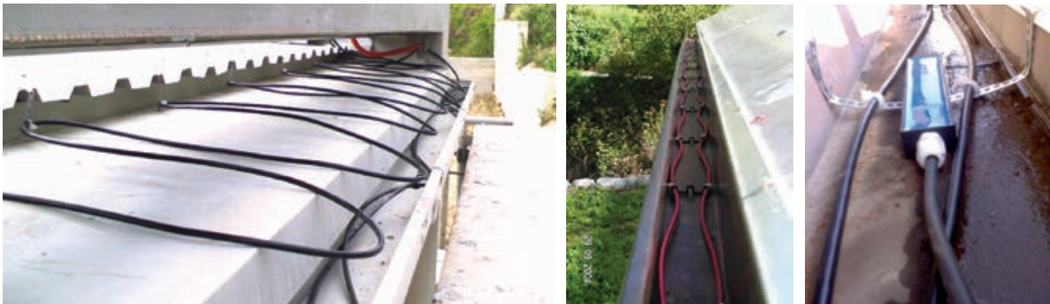
Slika 7-33 Fotografije sustava za grijanje oluka [363], [364]
