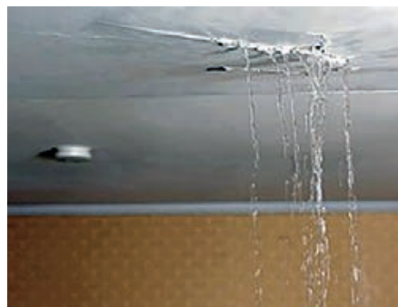
Slika 1-63 Štete uzrokovane lošom izvedbom kišne brane [45], [46]
