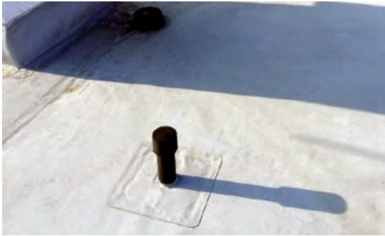
Slika 6-34 Odzračnik na neprohodnom ravnom krovu [7]
