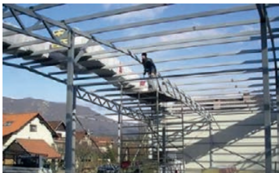
Slika 1-16 Ugradnja metalne konstrukcije - krov [12]
