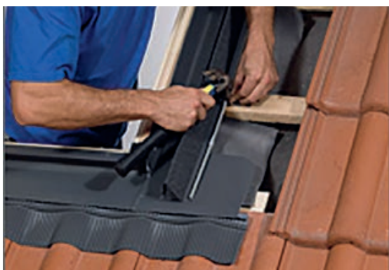
Slika 1-168 Učvršćivanje bočnog opšava [130]
