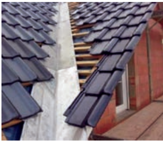
Slika 2-30 Izvedba krovne uvale limom [165]
