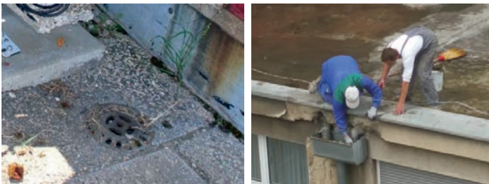
Slika 1-9 Čišćenje odvodnje s ravnog krova, NAPOMENA: Zaštita na radu [7]
