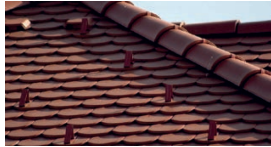
Slika 2-52 Primjeri izvedbe pokriva biber crijepom [187]
