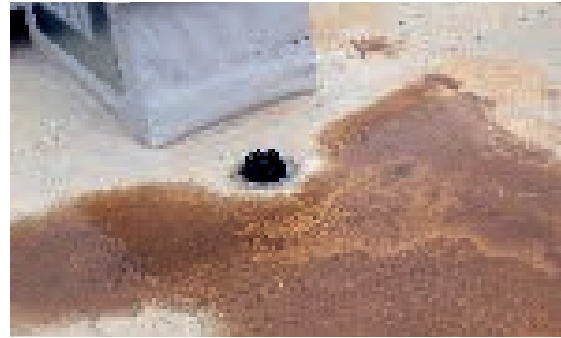
Slika 6-35 Vodolovno grlo na primjeru neprohodnog ravnog krova [7]
