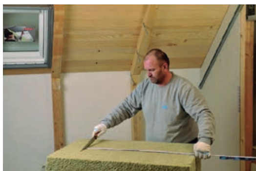
Slika 2-11 Postupak postavljanja toplinske između i ispod rogova [147]
