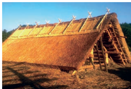
Slika 5-7 Pokrivanje sljemena slamom [307]
