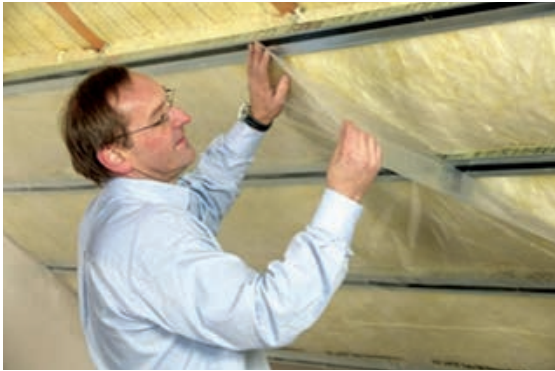
Slika 1-72 Postavljanje parne brane s donje strane [51]
