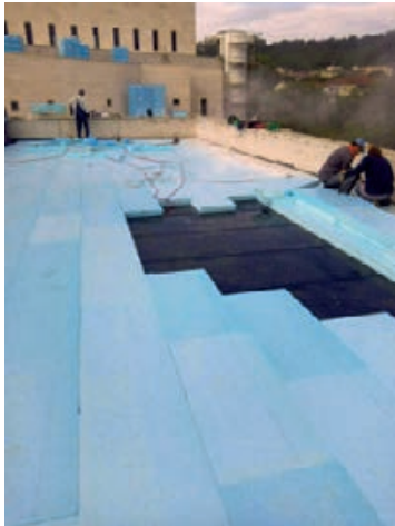
Slika 6-19 Postavljanje toplinske izolacije na ravni krov [24], [338], [148]
