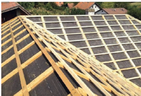
Slika 7-23 Sljeme krova - priprema [362]
