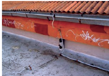
Slika 6-39 Začepljena rešetka sifona na krovu i oštećenja na krovnoj hidroizolaciji [349]
