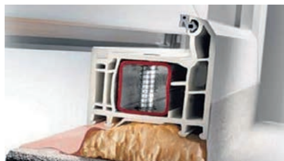
Slika 1-148 Brtvljenje folijama i ekspan-dirajućom brtvom [122]
