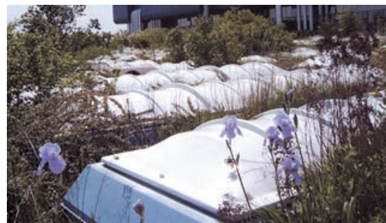
Slika 6-36 Primjer krova na kojem su zbog neodržavanja urasle biljke [349]
