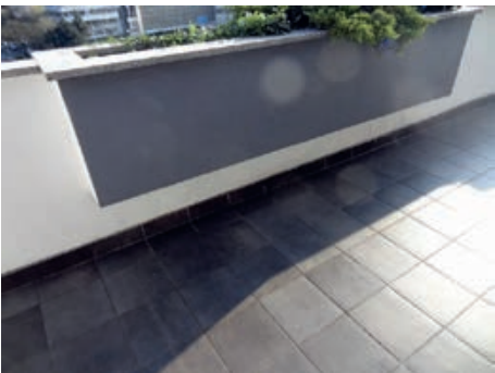
Izvedba zaštite hidroizolacije pomoću keramičkih pločica
