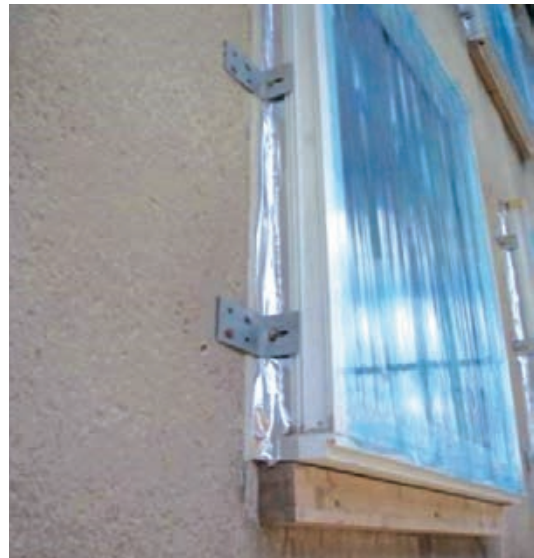
Slika 1-153 Pravilan položaj stolarije za RAL ugradnju u vrlo niskoenergetske zgrade i zgrade gotovo nulte energije
