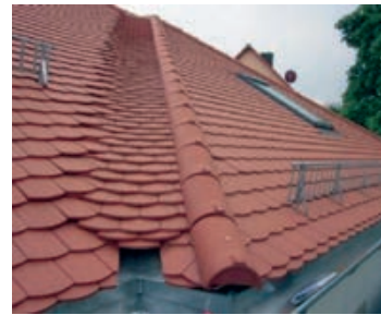
Slika 2-31 Izvedba biber crijepom [166]
