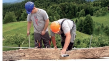
4) Rezanje mekane mineralne vune
