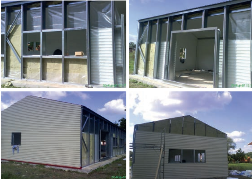
Slika 1-18 Ugradnja metalne potkonstrukcije, ugradnja zidnih toplinsko-izolacijskih panela i pokrivanje krova profiliranim limom [13]
