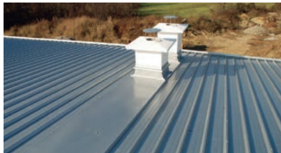
Slika 3-4 Pokrov ravnim limenim trakama [217]
