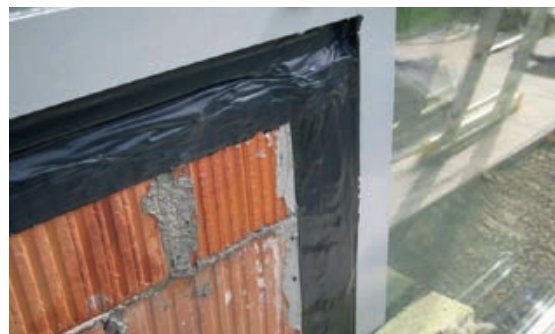
Slika 1-151 Primjer brtvljenja folijom [124]
