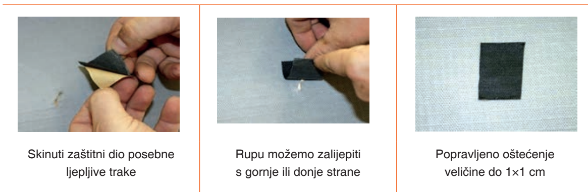
Slika 1-66 Pravilno izvođenje popravka malog oštećenja
