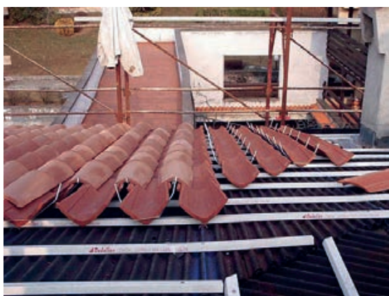
Slika 2-66 Postavljanje kupe kanalice na krovne ploče [198]
