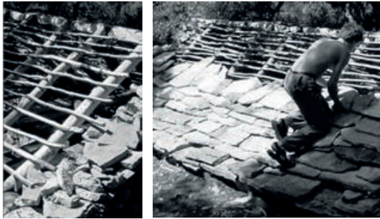
Slika 5-35 Pokrivanje debelim kamenim pločama [323]
