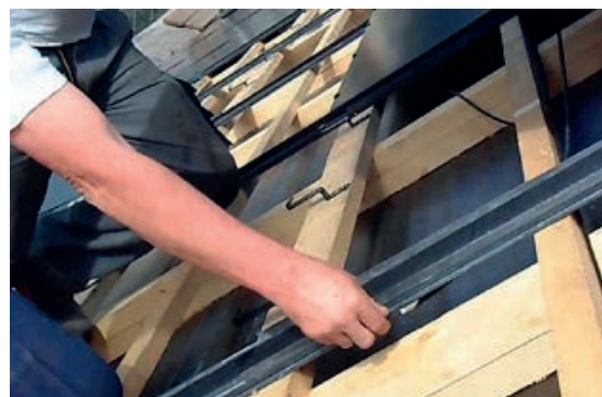
Slika 4-11 Pokrivanje kopčama (kukama) [268]
