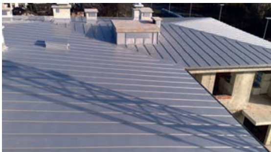
Slika 3-5 Pokrov limom krov malog nagiba [218]
