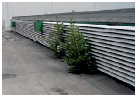
Slika 6-40 Primjeri lošeg održavanja krova [349]
