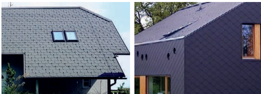
Slika 4-16 Primjeri izvedbe pokrova eternit pločama [269], [270]
