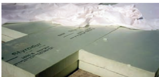
Slika 6-23 Stakleni voal na pločama za toplinsku izolaciju ravnog krova [339]
