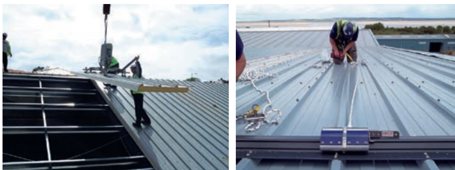
Slika 3-81 Prikaz pričvršćenja krovnih toplinsko-izolacijskih panela [248], [249]
