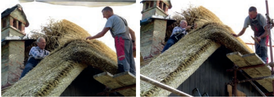
Slika 5-15 Obnova slamnatog krova na objektu „Staro selo“ Kumrovec [311]
