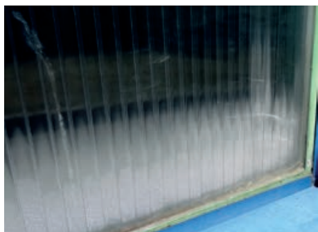
Kondenzacija vodene pare u pločama
