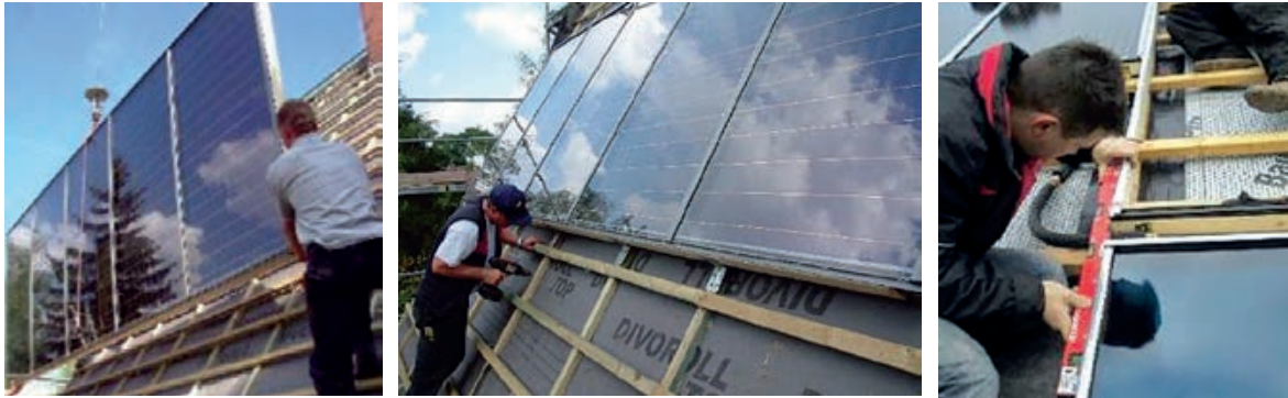
Slika 1-68 Izvedba fotonaponskih sustava iznad paropropusne-vodonepropusne folije [48]
