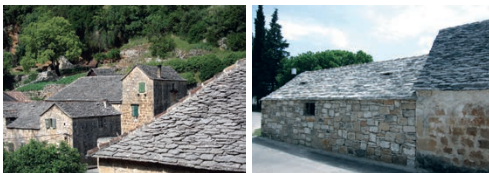
Slika 5-52 Pokrivanje kamenim pločama [330]
