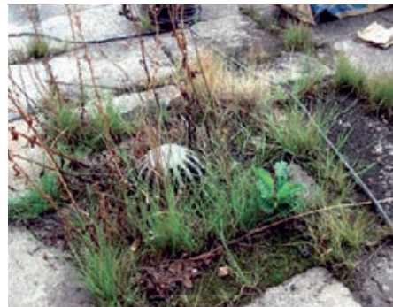
Slika 6-37 Otpad na krovu i lišćem začepljen slivnik [349]
