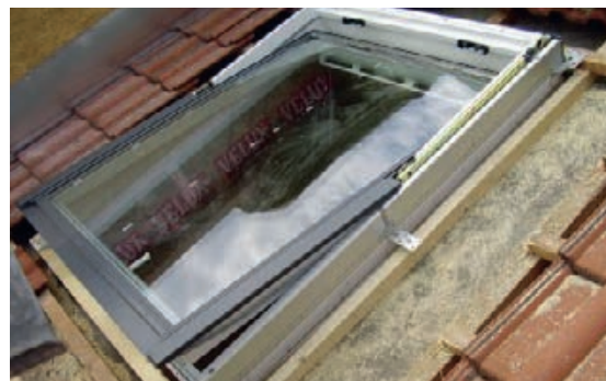
Slika 1-159 Učvršćivanje krovnog prozora [127]
