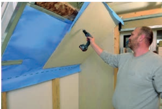
Slika 2-11 Postupak postavljanja toplinske između i ispod rogova [147]
