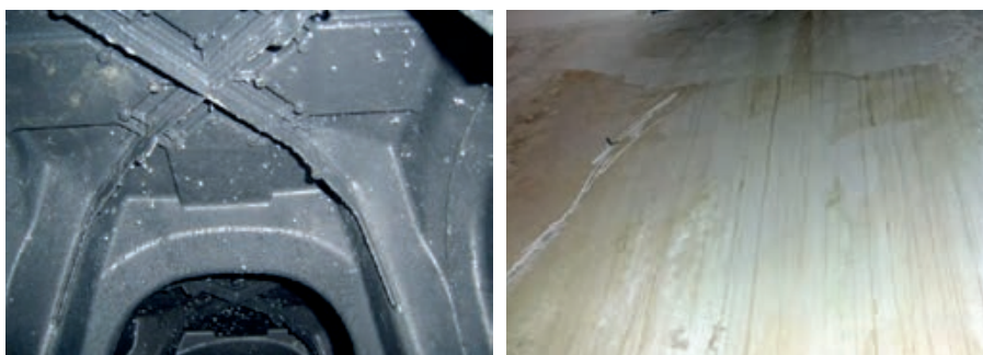
Slika 6-16 Kondenzat i curenje kondenzata zbog izostanka parne brane u zelenom ravnom krovu [7]
