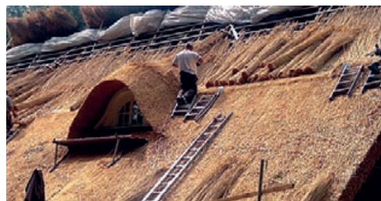
Slika 5-21 Pokrivanje krovova trskom [314]
