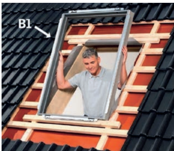
Slika 1-166 Okvir prozora s ugrađenom trakom toplinske izolacije [128]
