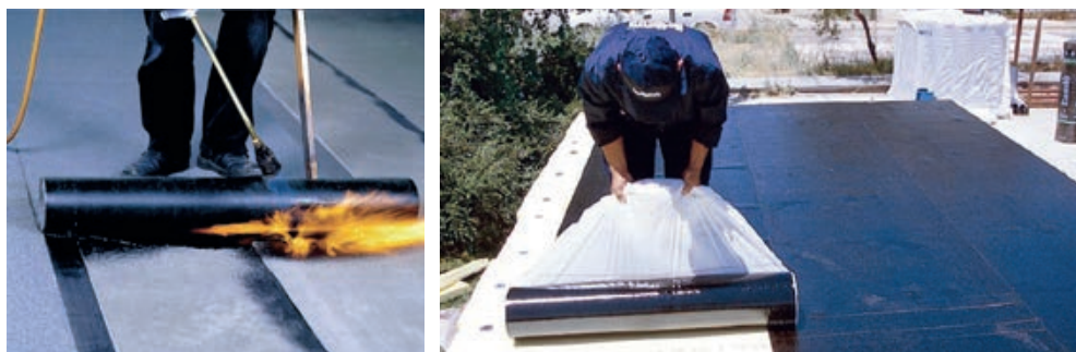
Punoplošno lijepljenje bitumenskih traka plamenikom
