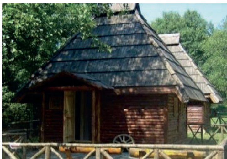
Slika 5-30 Primjer pokriva drvenom šindrom [321]
