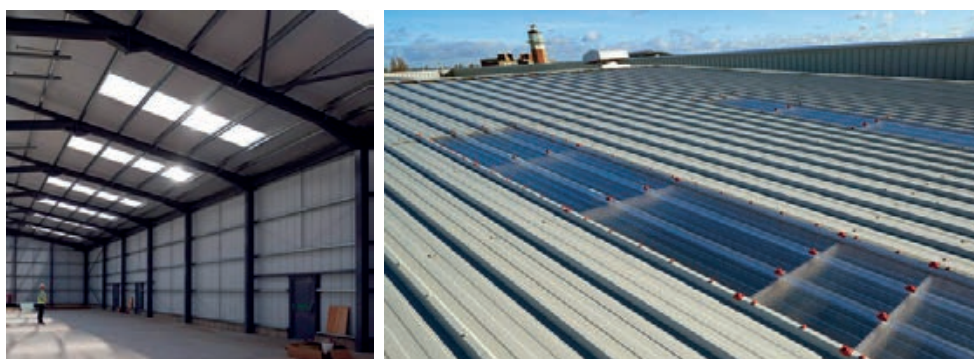
Slika 3-151 Ugrađene prozime ploče u krov hale [266], [264]
