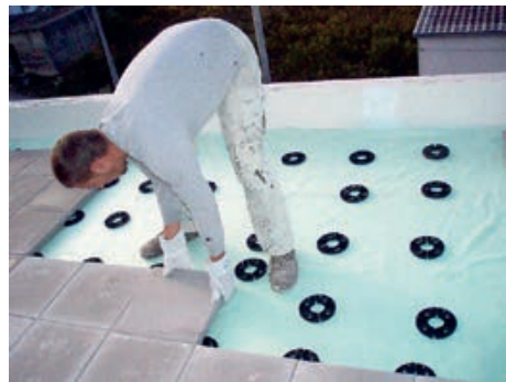
Izvedba zaštite hidroizolacije pomoću betonskih ploča
