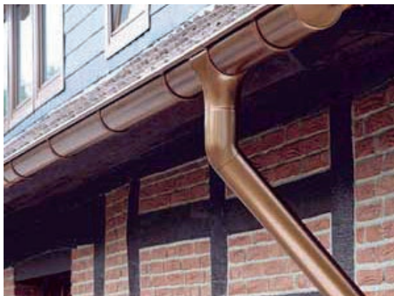
Slika 7-11 Spoj vodoravnog i okomitog oluka [355]
