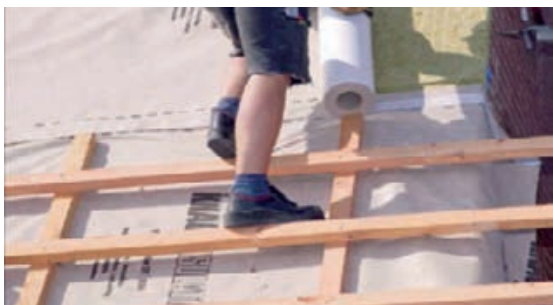
Slika 2-15 Postavljanje paropropusne-vodonepropusne folije na toplinsku izolaciju iznad rogova [24]
