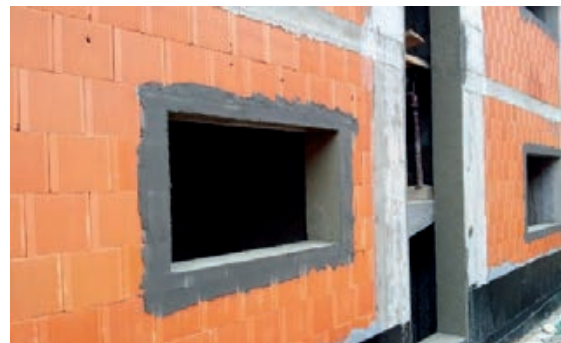
Slika 1-153 Žbukanje zidarskih otvora [124]
