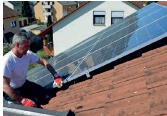
Slika 1-69 Izvedba fotonaponskih sustava na postojeći pokrov [49]
