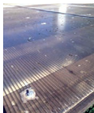
Promjena boje ploča zbog krivog okretanja (samo jedna strana ima zaštitu od UV zračenja)
