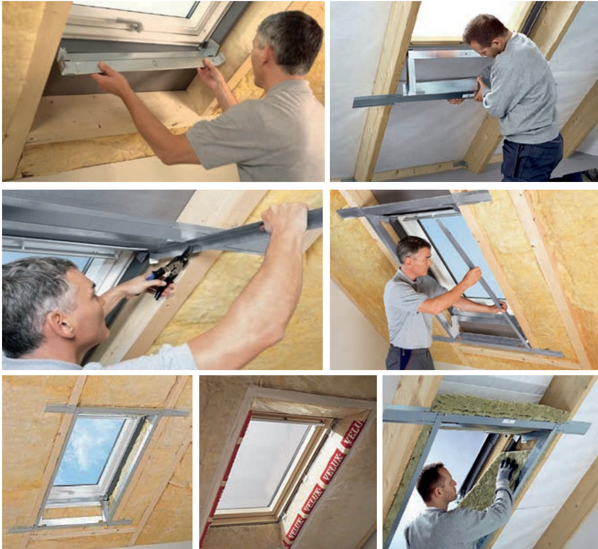
Slika 1-173 Postavljanje potkonstrukcije, toplinske izolacije i parne brane oko krovnog prozora [128]
