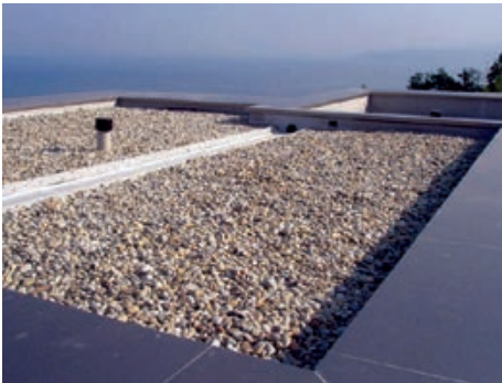
Izvedba zaštite hidroizolacije pomoću šljunka
