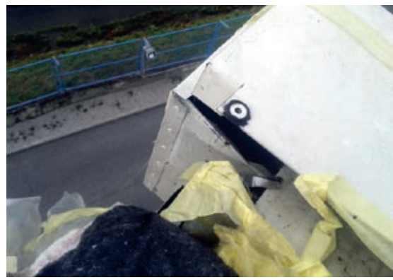
Slika 3-136 Primjer neodgovarajuće izrade opšava [7]
