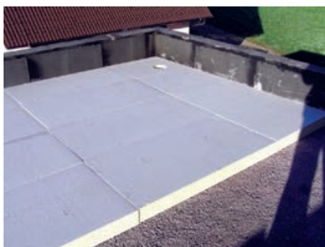
Korištenje toplinske izolacije na bazi PIR-a na obrnutom ravnom krovu
