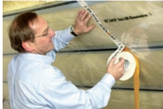
Slika 1-73 Lijepljenje parne brane s donje strane [31]
