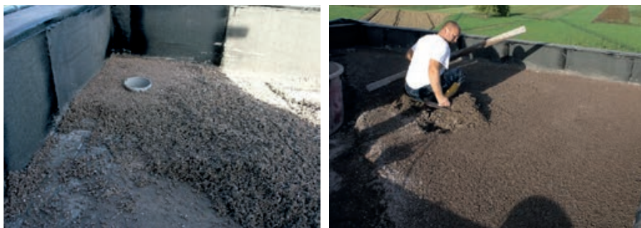
Slika 6-13 Izvedba nagiba od suhog nasipa [338]
