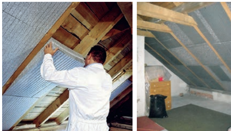
Slika 2-12 Posebni proizvodi od EPS-a za izolaciju između rogova [148]
