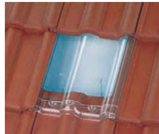
Slika 2-70 Crijep od polikarbonata: izgled na krovu [23]
