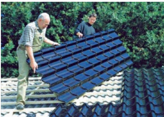
Slika 3-39 Rukovanje limenim pločama [238]
