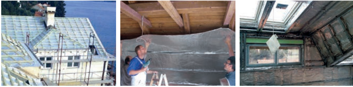
Slika 2-13 Primjer krovišta obloženog reflektirajućom folijom [149]
