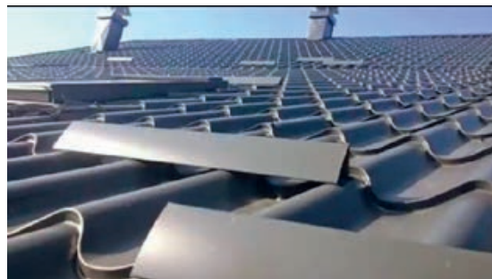
Slika 3-72 Pokrivanje limenim profiliranim pločama u obliku crijepa [242]
