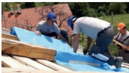
1) Postavljanje parne brane s gornje strane rogova
