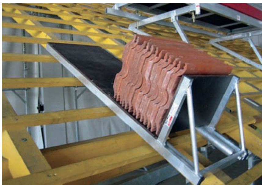
Slika 1-144 Klizni aluminijski nosač crijepa [120]
