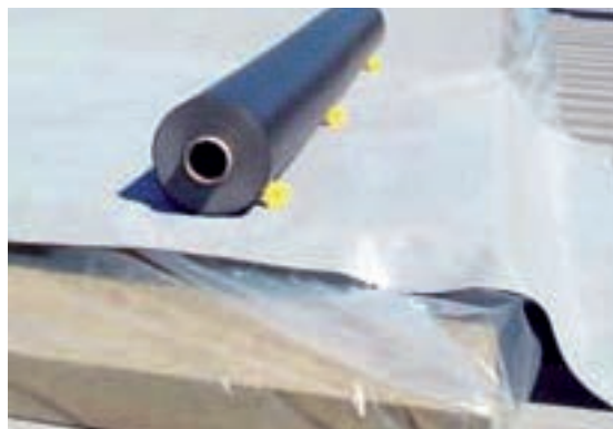
Slika 6-15 Prikaz sloja za izjednačenje [6]
