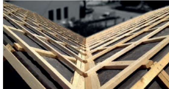
Slika 7-19 Izvedba krovne uvale [360]
