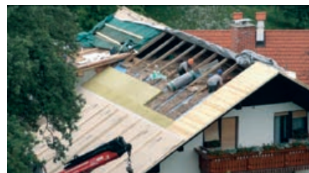
10) Toplinska izolacija postojećeg krova
