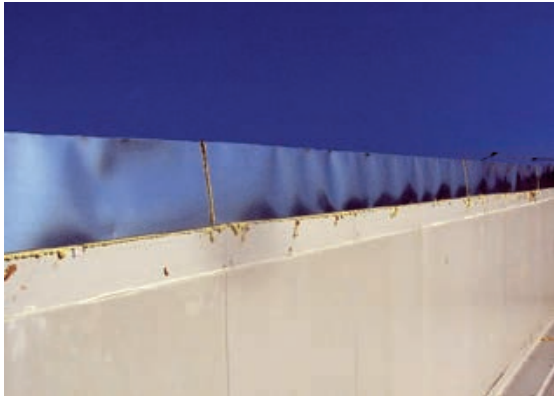
Slika 3-133 Primjer neodgovarajućeg brtvljenja zabata limom i PUR pjenom [7]
