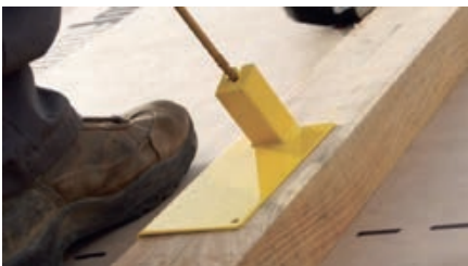
9) Pričvršćivanje kontraletvi na tvrde ploče mineralne vune
