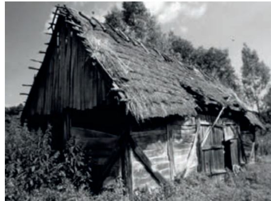
Slika 5-2 Pokrov slamom kojem treba sanacija
