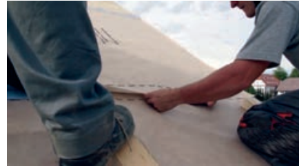
8) Postavljanje paropropusne-vodonepropusne folije s preklopom
