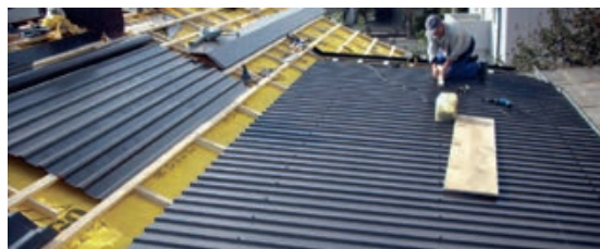
Slika 3-48 Primjer polaganja lima na kontraletve i letve [239]
