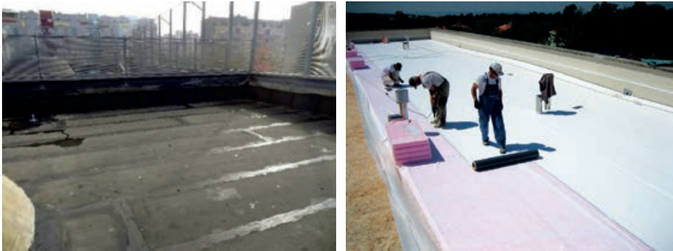
Slika 1-8 Popravak ravnog krova [7]
