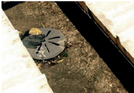
Slika 6-39 Začepljena rešetka sifona na krovu i oštećenja na krovnoj hidroizolaciji [349]
