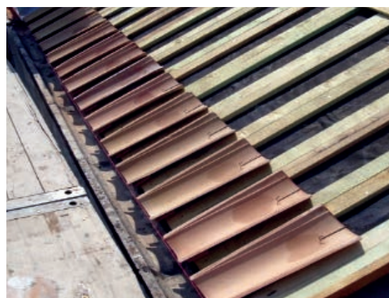
Slika 2-67 Postavljanje kupe kanalice na daščanu podlogu [199]
