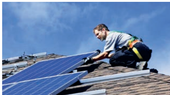
Slika 1-21 Primjer ugradnje fotonaponskih ploča na postojeći krov [15]
