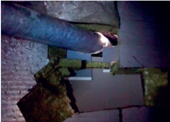
Slika 3-137 Primjer neodgovarajuće izrade proboja kupole za odimljavanje [7]
