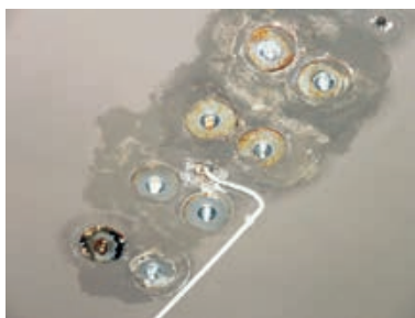
6-49 Procurivanje vode na mjestima proboja hidroizolacije ankerima [7]
