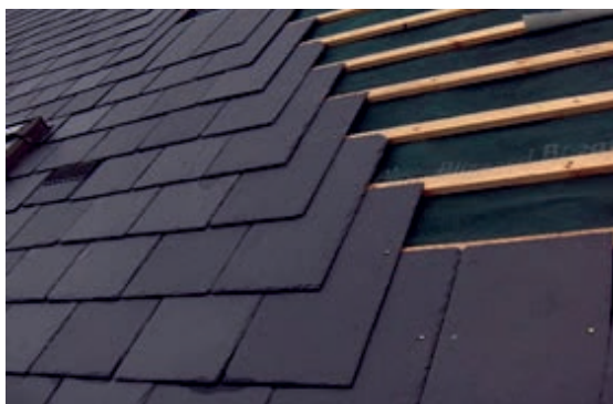
Slika 4-10 Pokrivanje pribijanjem [267]
