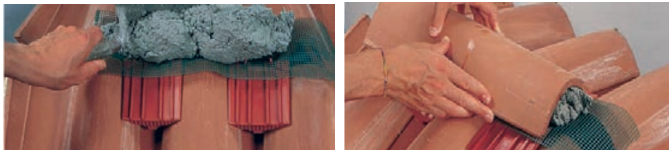
Postavljanje odzračnika na sljemenu - preko mrežice postavlja se mort
