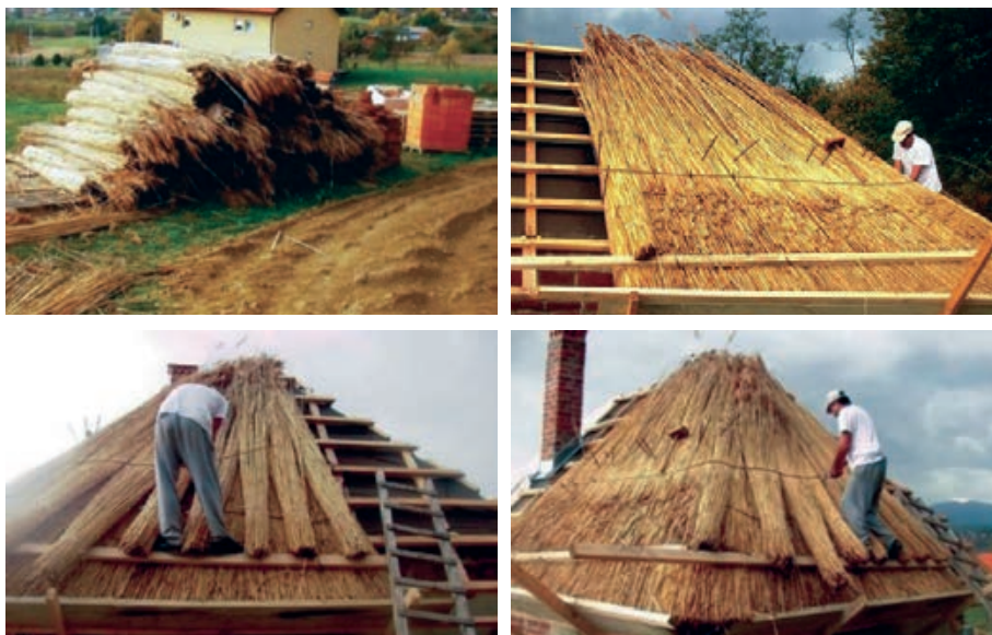
Slika 5-25 Pokrivanje manjeg objekta trskom [315]
