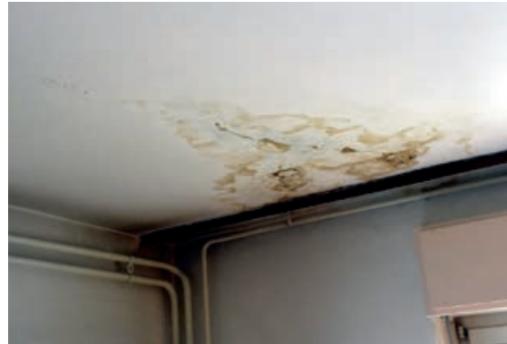
Slika 6-45 Primjer procurivanja hidroizolacije ravnog krova u prostoriju [7]
