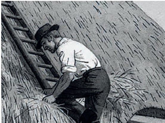
Slika 5-1 Pokrivanje slamom [304]
