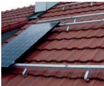
Slika 2-36 Držači solarnih kolektora [173]
