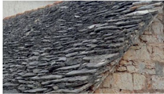
Slika 5-36 Izgled krovnog pokrova od debljih kamenih ploča [7]
