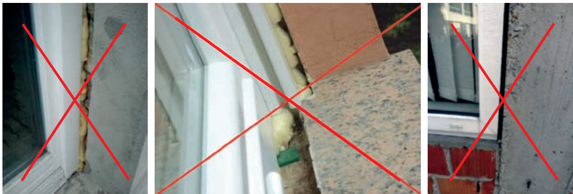
Slika 1-146 Brtvljenje međuprostora PUR pjenom [121], [7]
