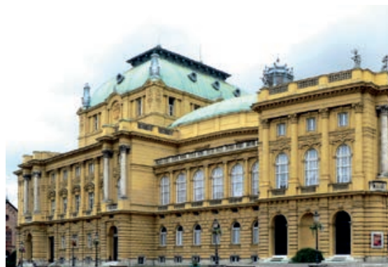
Slika 7-2 Primjer oksidiranog krova HNK u Zagrebu [350]
