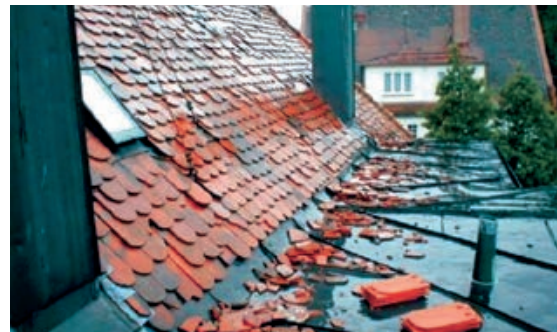
Slika 1-24 Oštećenje krova uslijed vjetra [20]
