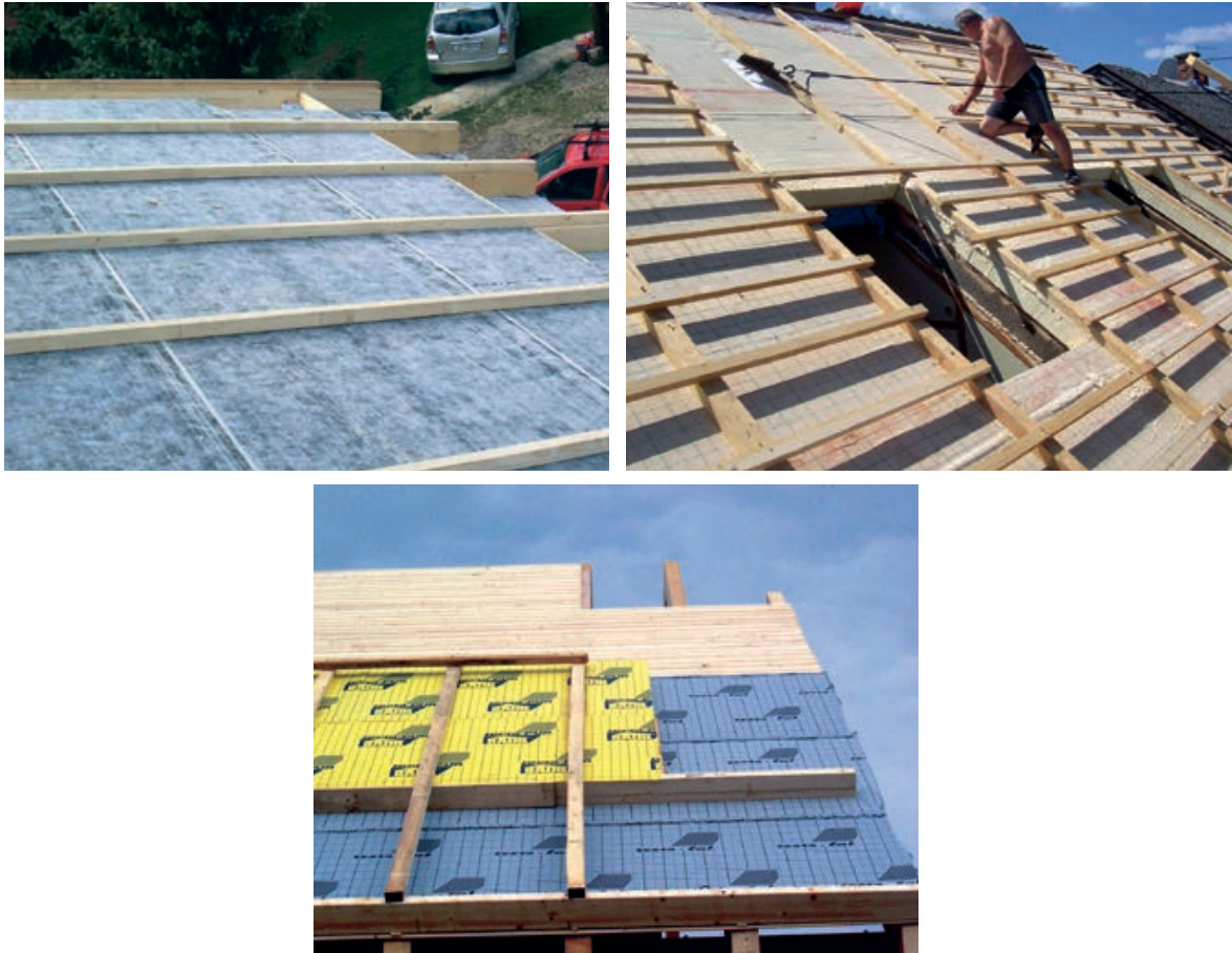
Slika 2-8 Postavljanje toplinske izolacije od tvrdih ploča toplinske izolacije od PUR-a ili PIR-a iznad rogova [144]
