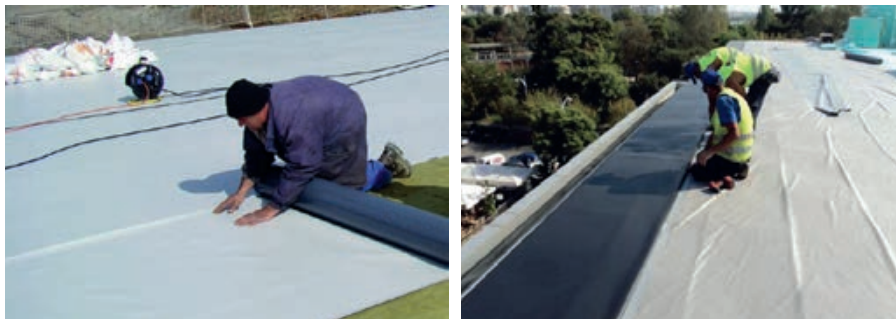
Slika 6-25 Postavljanje hidroizolacijske membrane na toplinsku izolaciju ravnog krova od mineralne vune [340], [7]
