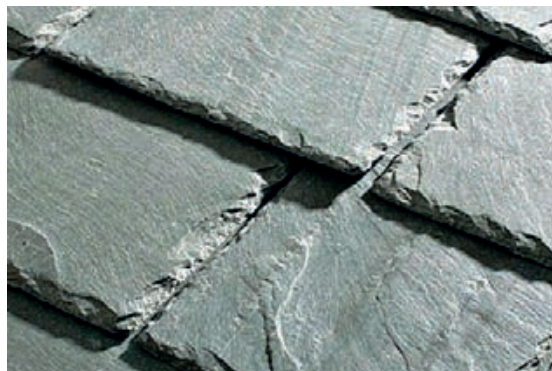
Slika 5-34 Pokrov prirodnim kamenom [322]
