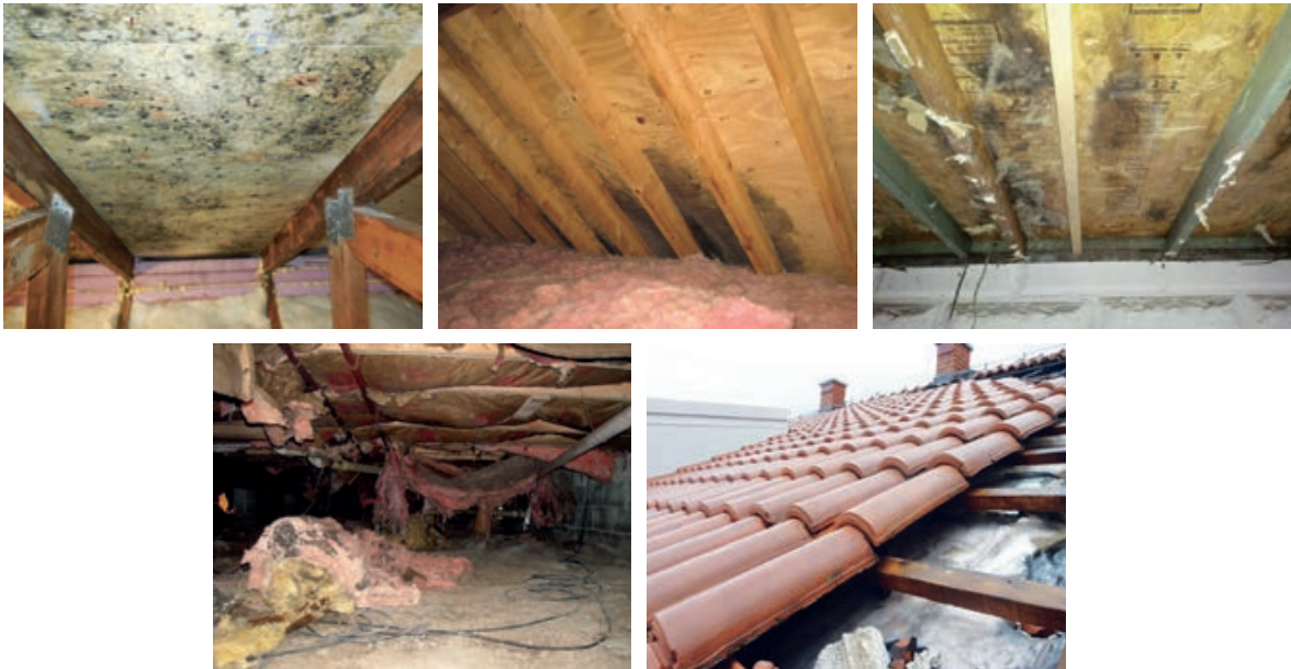
Slika 1-74 Štete uzrokovane lošom zrakopropusnošću [52], [53], [54], [55], [56]
