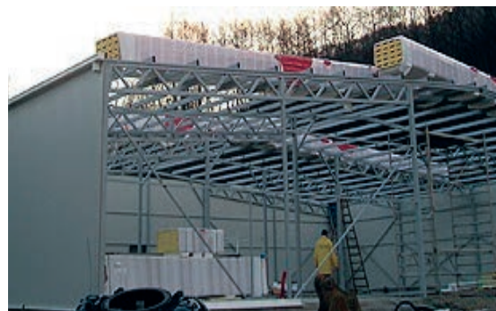
Slika 1-17 Ugradnja krovnih i fasadnih panela -pokrivanje [12]
