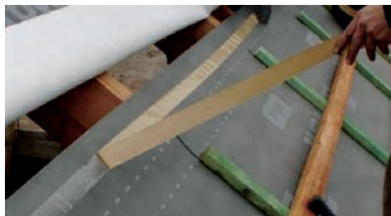
Slika 2-16 Mogući način spajanja traka na preklopima lijepljenjem [153]
