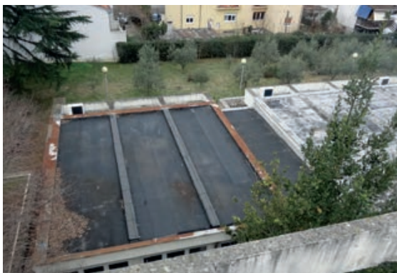
Slika 7-1 Primjer oksidiranog opšava neprohodnog ravnog krova [7]
