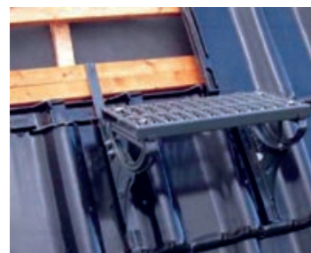
Slika 2-39 Držači krovnih ljestava penjalica [176]
