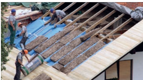
5) Postavljanje mekane mineralne vune između rogova
