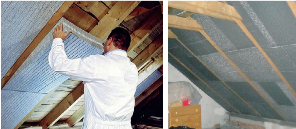
Slika 2-102 Specijalni proizvodi od EPS-a za izolaciju između rogova [140]
