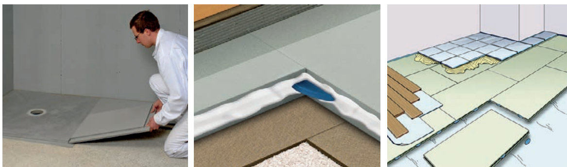
Slika 2-129 Primjeri izvedbe estriha cementnovlaknastim pločama [171], [172], [173]
