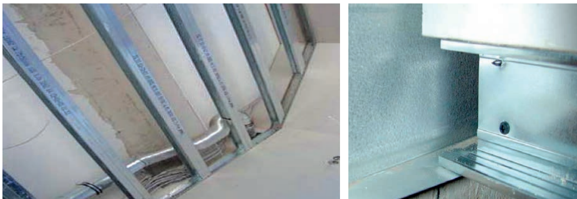
Slika 2-78 Samonosivi spuštteni strop [38]
