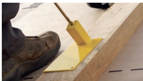
9) Pričvršćivanje kontraletvi na tvrde ploče mineralne vune
