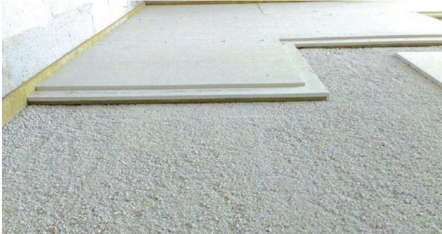
Slika 2-130 Primjer spoja suhog estriha na nasipu od perlita sa zidom zbog zaštite od udarnog zvuka [174]
