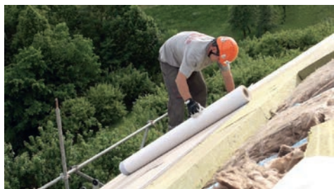
7) Izvedba paropropusne-vodonepropusne barijere
