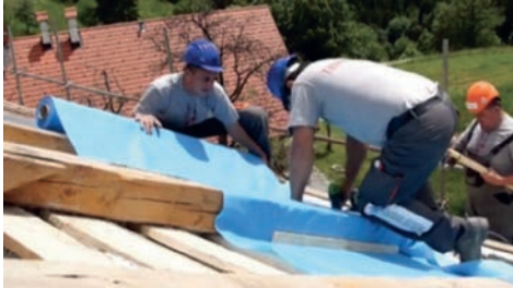
1) Postavljanje parne brane s gornje strane rogova
