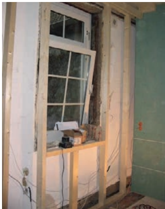
Slika 2-10 Drvena potkonstrukcija za unutarnju izolaciju [92]
