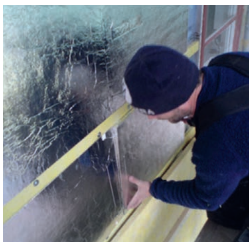
Slika 2-16 Prikaz unutarnje izolacije korištenjem vakumizolacijskih ploča [96]
