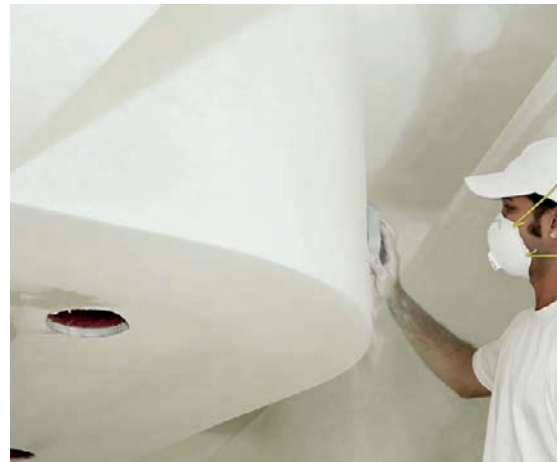
Slika 2-85 Spušteni strop u više razina [129]
