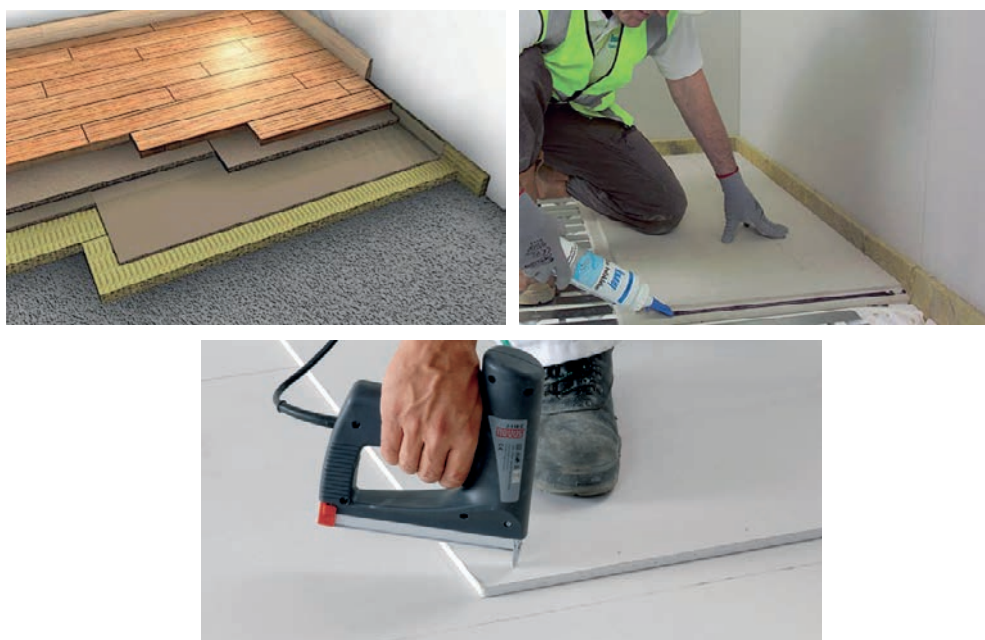
Slika 2-126 Postavljanje gipsanih ploča suhog estriha na izolacijski sloj [1], [164]
