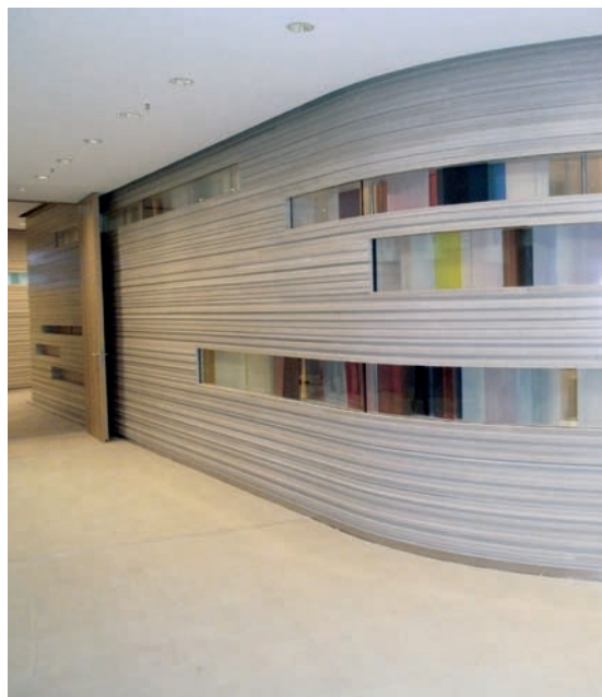
Slika 1-2 Zakrivljeni zid izveden suhom gradnjom [2]
