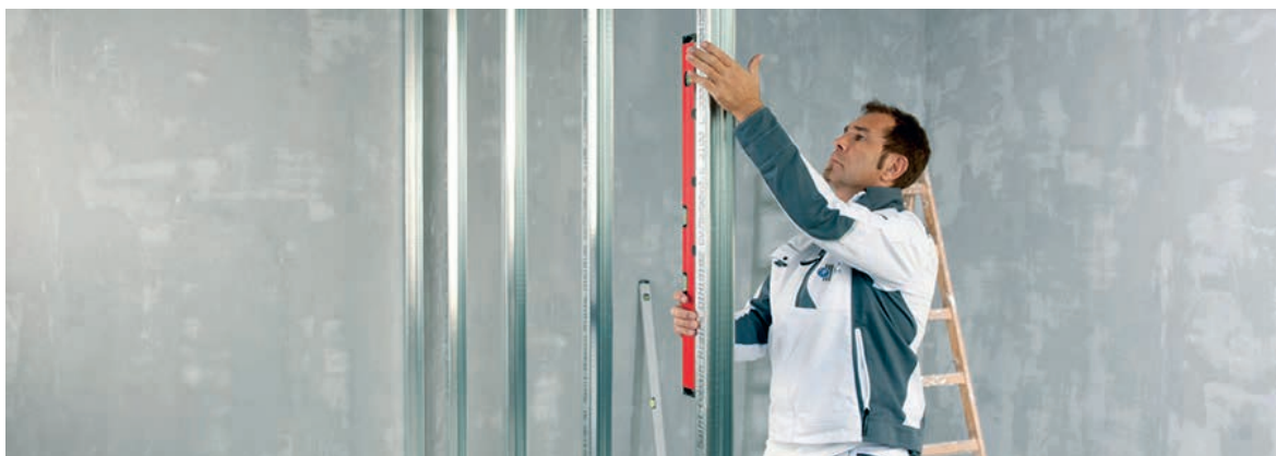
Slika 2-44 Čelična potkonstrukcija pregradnog zida [99]
