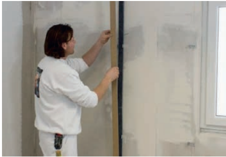
Ugradnja parne brane
