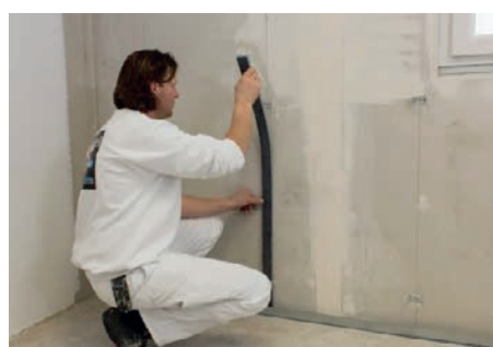
Učvršćenje toplinske izolacije na susjedne stropove i zidove
