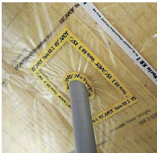
Slika 2-101 Lijepljenje parne brane i brtvljenje prodora [81]
