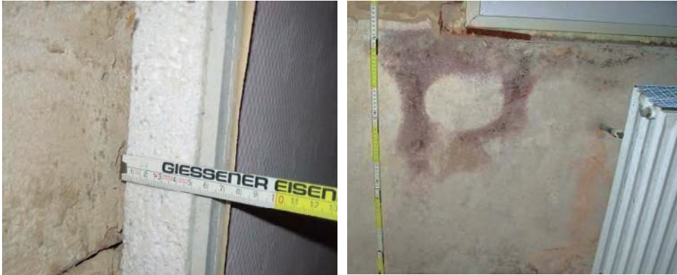
Slika 2-36 Razvoj gljivica nakon skidanja sloja unutarnje toplinske izolacije [103]
