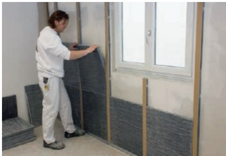
Ugradnja toplinske izolacije
