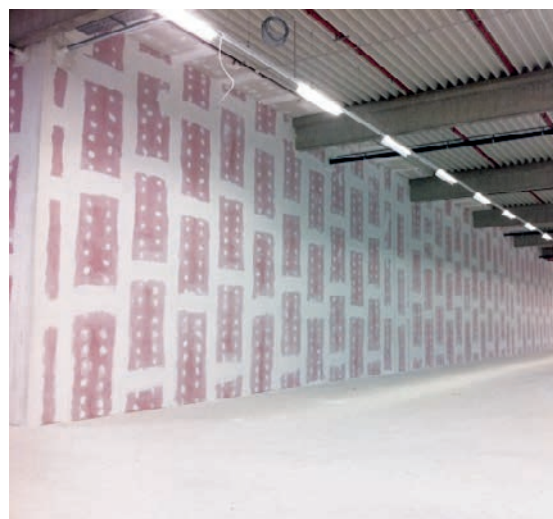
Slika 2-149 Nakon izvedbe tekućeg anhidritnog estriha mogu se završno obrađivati gipsane ploče [209]
