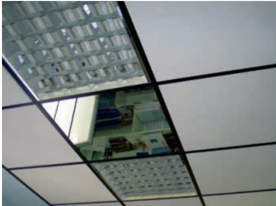
Slika 2-63 Spušteni strop s vidljivom potkonstrukcijom [121]
