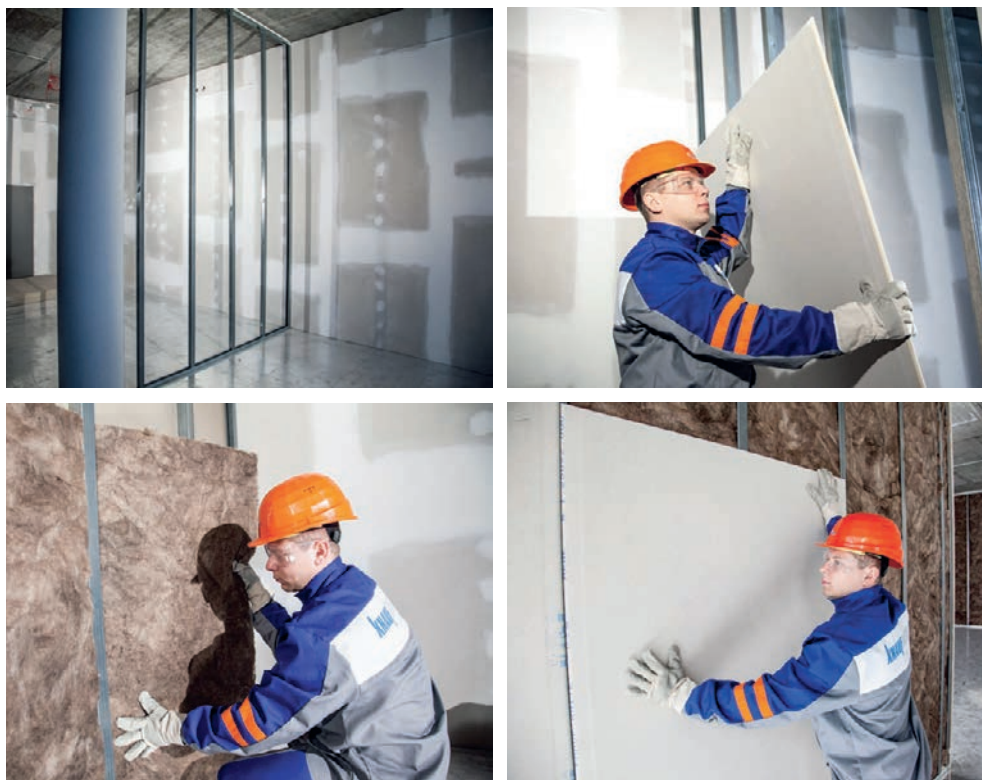
Slika 2-46 Ugradnja mineralne vune [111]
