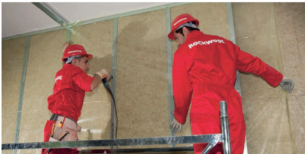
Slika 2-28 Postavljanje parne brane na vanjski zid [1]
