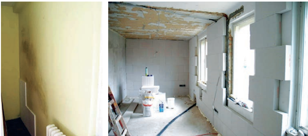
Slika 2-3 Primjeri izolacije s unutarnje strane [85], [86]
