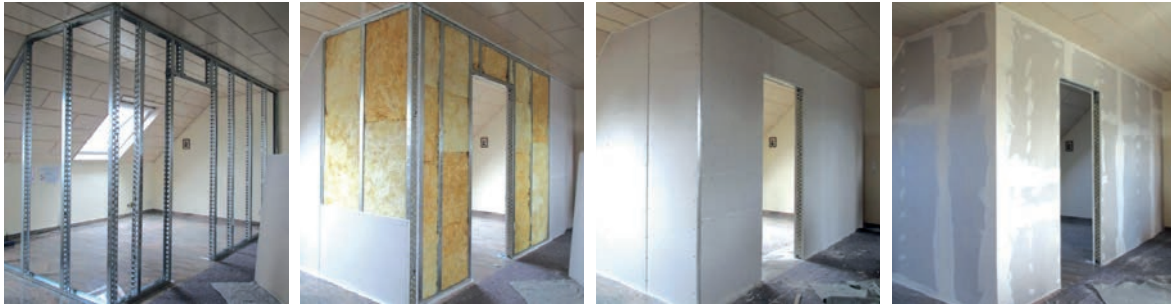
Slika 2-48 Postupnost formiranja pregradnog suhomontažnog zida [113]
