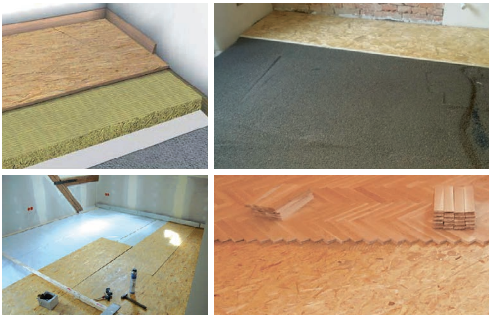
Slika 2-128 Primjeri izvedbe suhog estriha s drvenovlaknastim pločama [1], [168], [169], [170]
