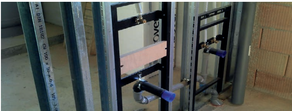
Slika 2-61 Potkonstrukcija za instalacijski zid s nosačima [119]
