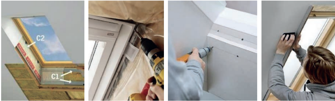
Slika 2 -105 Postavljanje parne brane i završne obloge s unutarnje strane krova [142]
