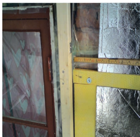
Slika 2-16 Prikaz unutarnje izolacije korištenjem vakumizolacijskih ploča [96]
