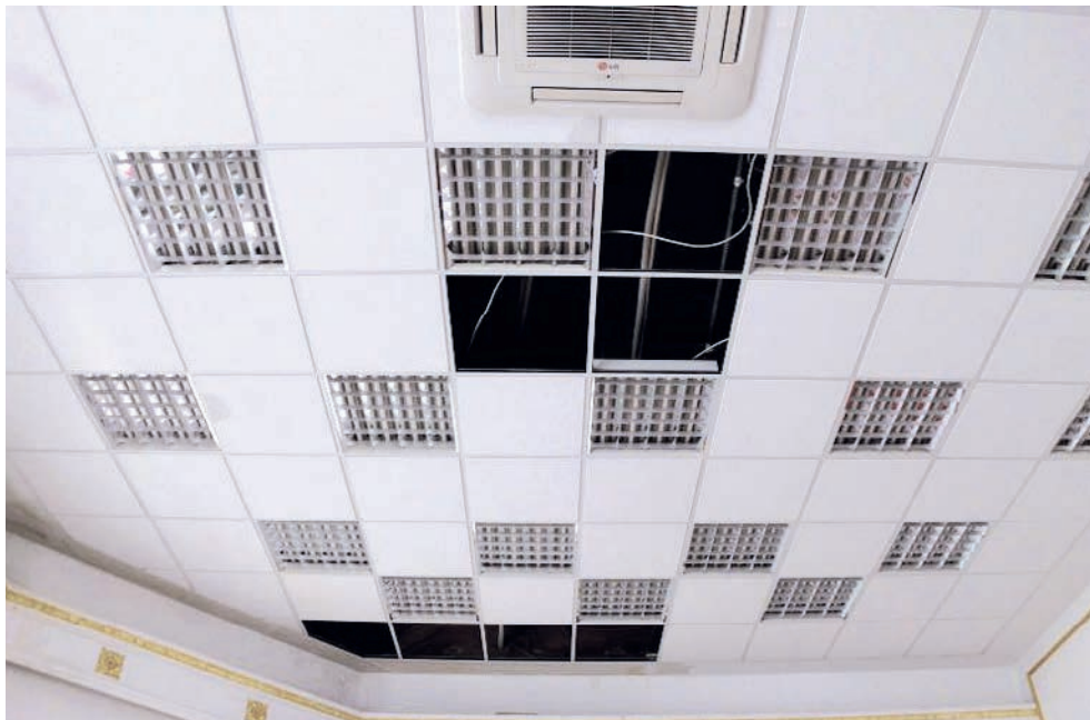
Slika 2-65 Modularni spuštteni stropovi [123]
