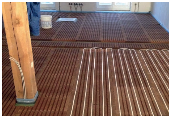
Slika 2-136 Primjeri postavljanja elemenata za podno grijanje [91], [181], [182], [38]
