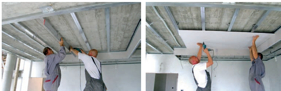
Slika 2-68 Izvedba spušenog stropa s direktnim pričvršćenjem potkonstrukcije [91]
