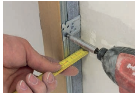
Ugradnja gipskartonskih ploča
