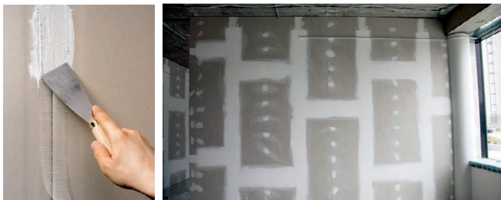
Slika 2-148 Primjena bandažne trake i ispunjivača spojeva [208], [1]
