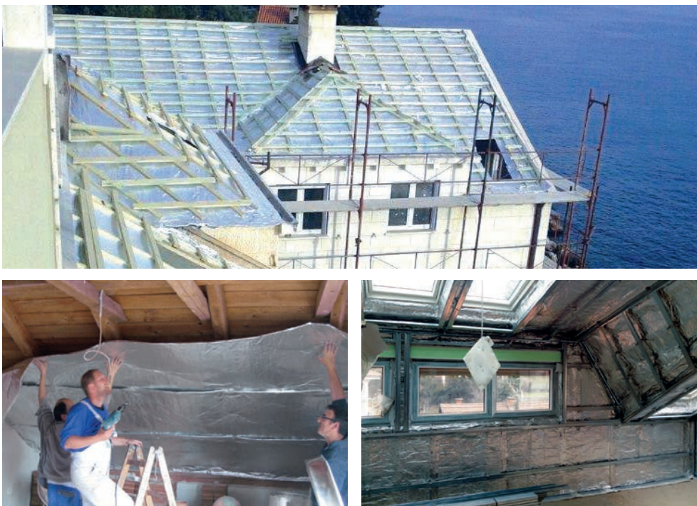
Slika 2-103 Primjer krovišta obloženog reflektirajućom folijom [140]
