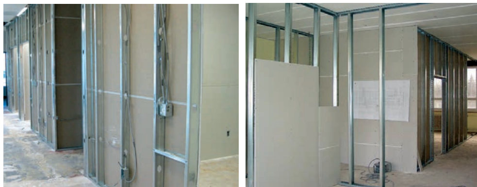
Slika 2-47 Izvedba obloge pregradnog suhomontažnog zida [112]
