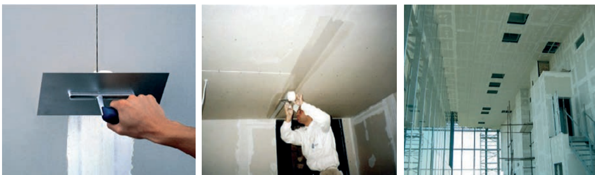
Slika 2-146 Završna obrada površine gipsanih ploča [82]
