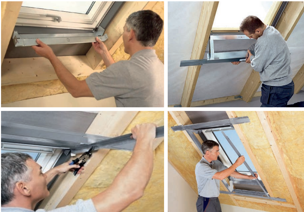
Slika 2 106 Postavljanje potkonstrukcije, toplinske izolacije i parne brane oko krovnog prozora [142]
