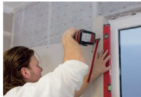
Ugradnja gipskartonskih ploča
