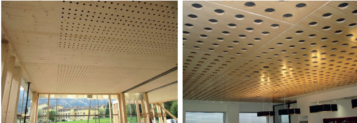
Slika 2-81 Perforirane i užljebljene akustične ploče [125]
