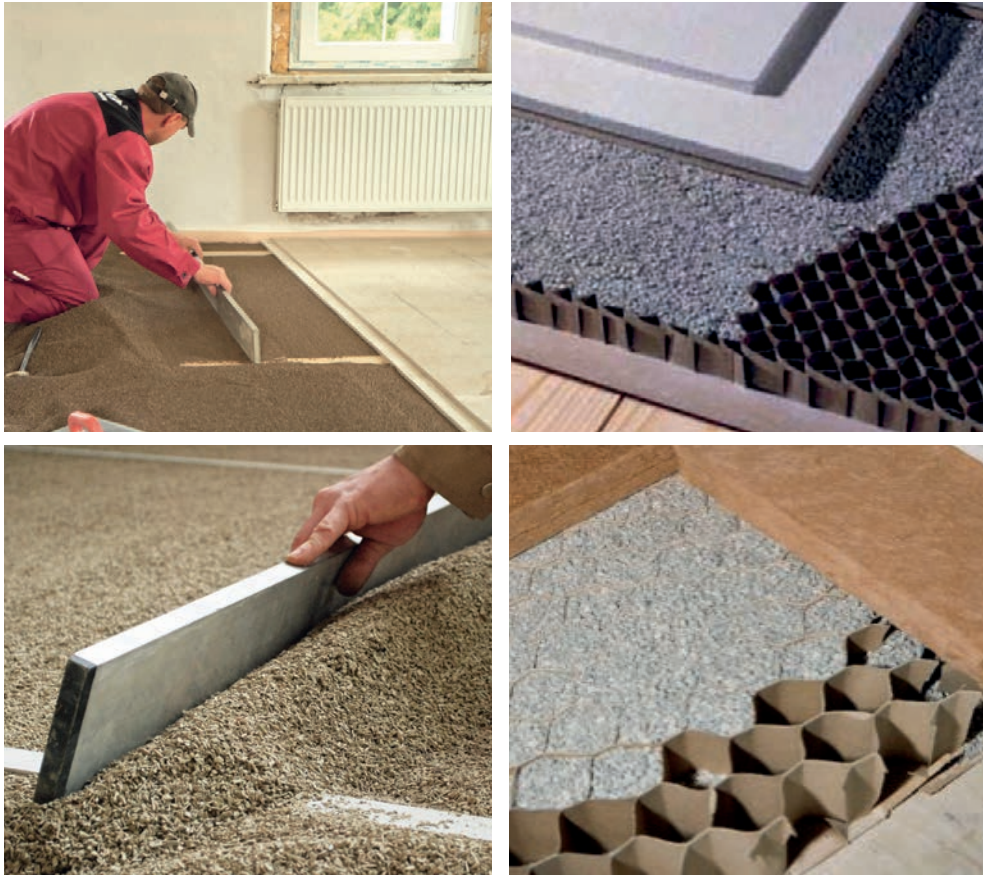
Slika 2-127 Primjeri moguće izvedbe estriha sa suhim nasipom [165], [100], [166], [167]
