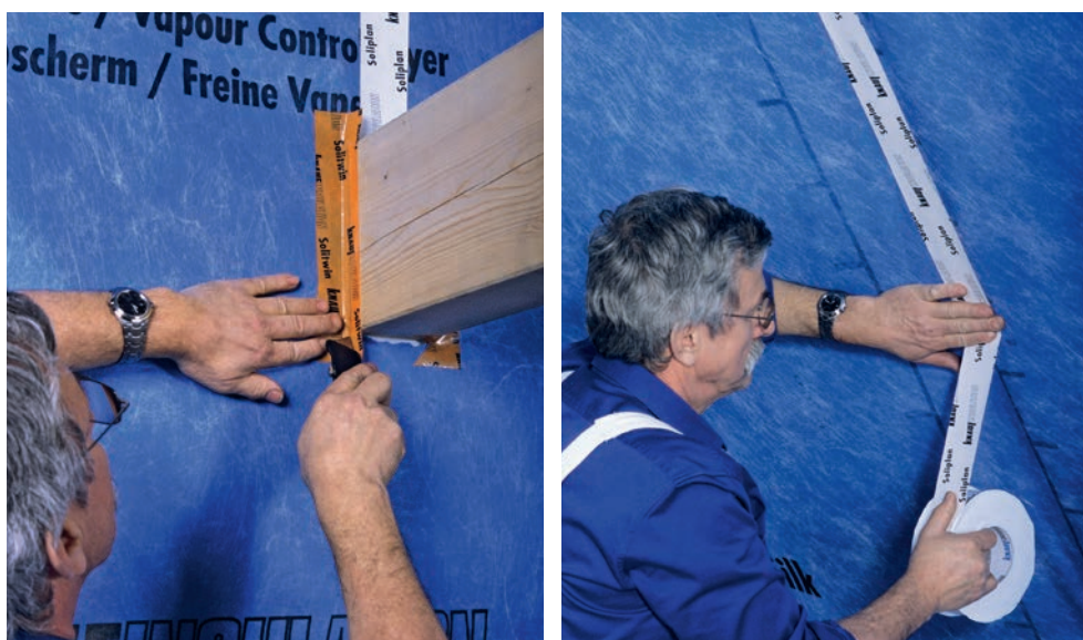
Slika 2-29 Lijepljenje parne brane [1]
