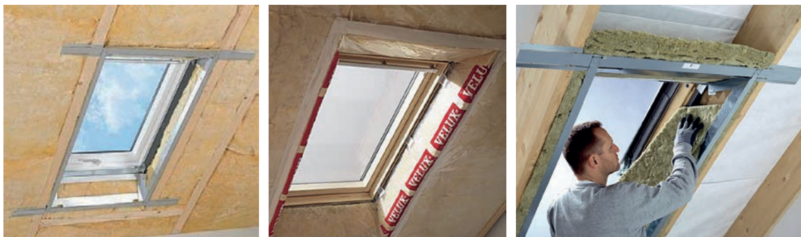
Slika 2-106 Postavljanje potkonstrukcije, toplinske izolacije i pame brane oko krovnog prozora [142]
