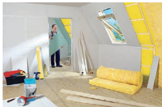
Slika 2-87 Oblaganje potkrovlja suhom gradnjom [130]
