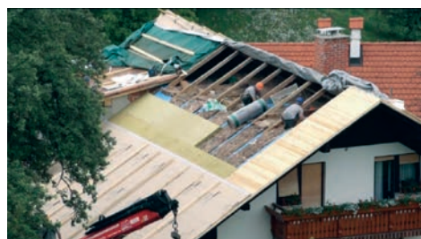
10) Toplinska izolacija postojećeg krova
