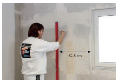
Postavljanje potkonstrukcije, drvene ili metalne
