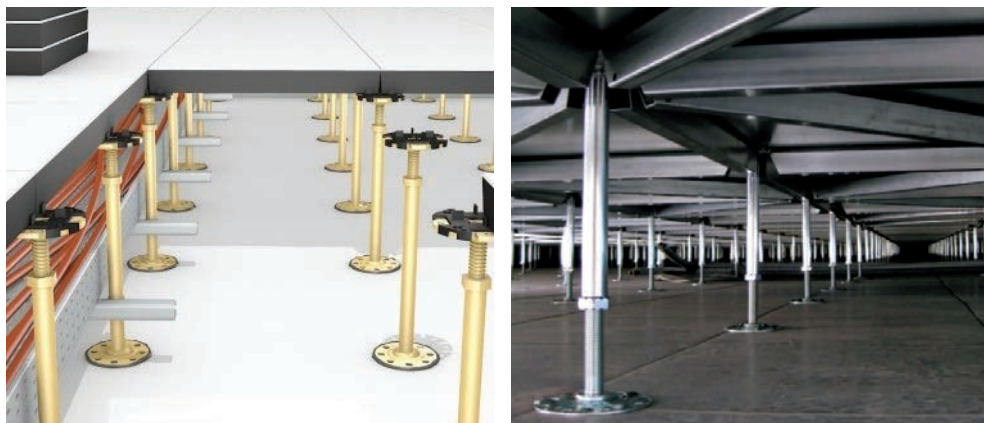
Slika 2-140 Nosiva konstrukcija uzdignutog poda [193], [194]
