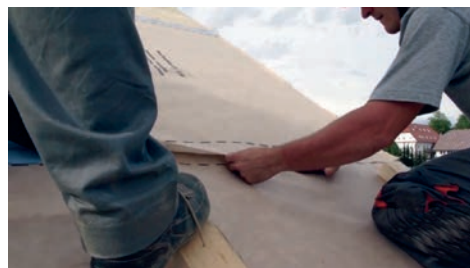
8) Postavljanje paropropusne-vodonepropusne folije s preklopom
