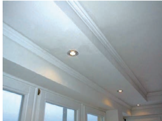
Slika 2-64 Spušteni strop s nevidljivom potkonstrukcijom [122]
