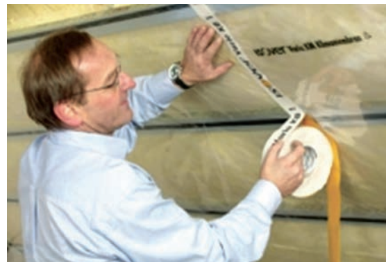
Slika 1-83 Lijepljenje parne brane s pristupom iznutra [81]
