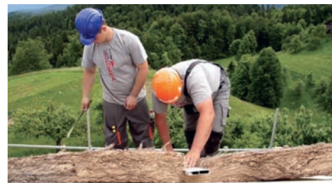
4) Rezanje mekane mineralne vune
