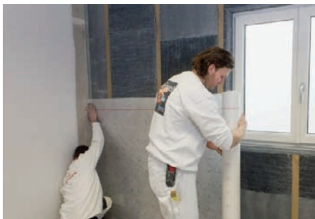
Ugradnja parne brane
