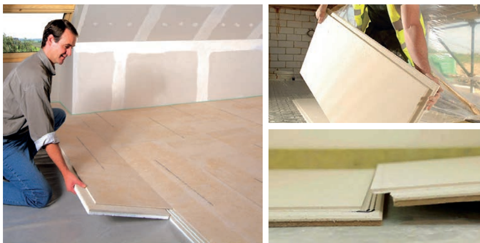
Slika 2-125 Postavljanje višeslojnih gipsvlaknastih ploča direktno na nosivu konstrukciju [91], [99]
