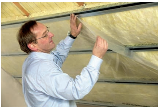
Slika 1-82 Postavljanje parne brane s pristupom iznutra [81]
