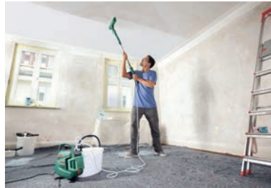
Slika 1-110 Bojanje električnim valjkom [70]
