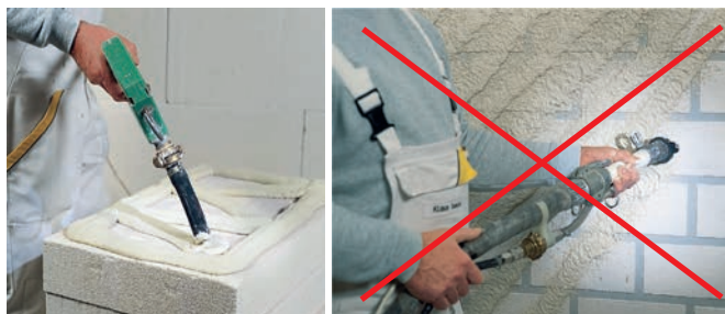
Slika 3-25 Strojno nanošenje morta za lijepljenje „rubno-točkastom“ metodom [10]
