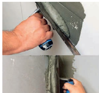
Slika 1-96 Nanošenje glet mase na gletericu [58]
