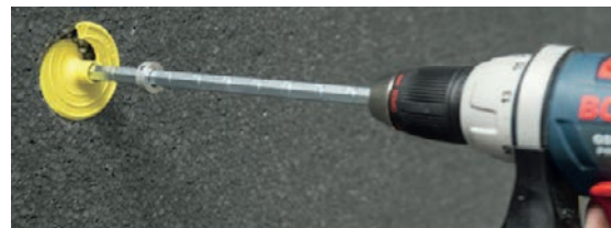
Slika 2-5 Dodatno mehaničko pričvršćivanje toplinske izolacije [10]
