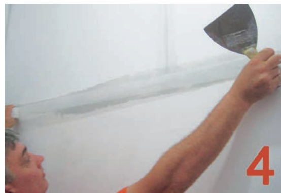
Slika 4-56 Bandažiranje pukotine [196]
