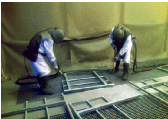
Slika 4-40 Skidanje korozije pjeskarenjem [193]
