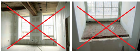
Slika 3-7 Izvođenje unutarnje izolacije stana bez izolacije prozorske klupčice ne preporučuje se [156]
