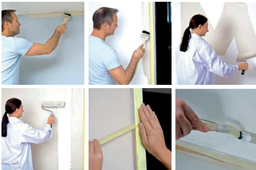
Slika 6-4 Primjer postupka ličenja zida [201]
