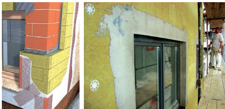
Slika 2-56 Izvedba ruba i kuta pomoću kutnog profila [10], [102]
