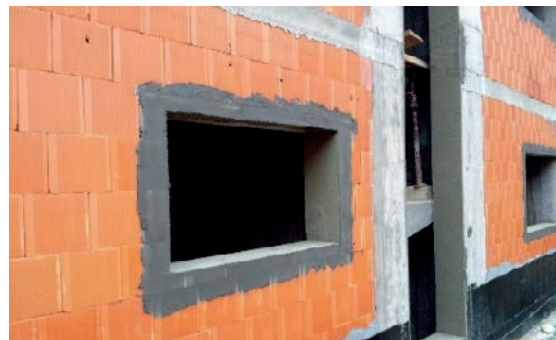
Slika 2-117 Žbukanje zidarskih otvora [149]
