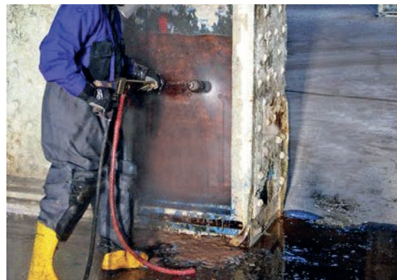
Slika 4-41 Skidanje korozije mlazom vode [194]
