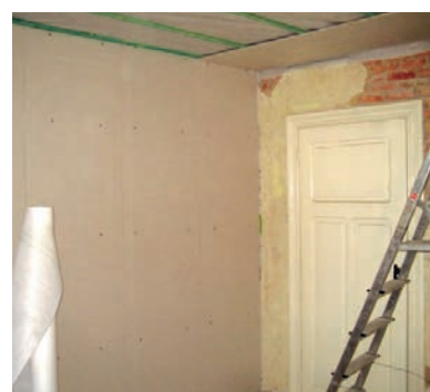
c) Postavljanje gipskartonskih ploča fiksiranjem na mjestima drvenih nosača
