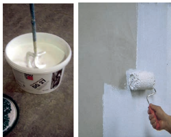
Slika 2-74 Miješanje i nanošenje pretpremaza [10]
