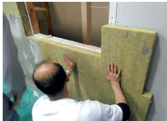
Slika 2 32 Postavljanje toplinskoizolacijske ploče oko prozora – rezanje ploča [10]
