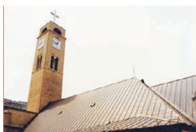
Slika 1-81 Bakrena podloga [55]
