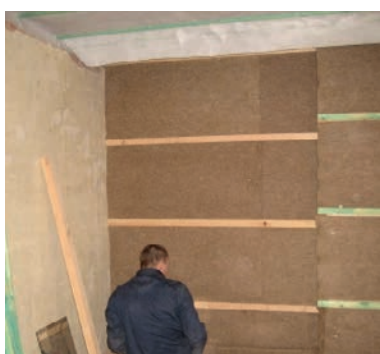
a) Postavljanje izolacije od industrijske konoplje između nosača potkonstrukcije
