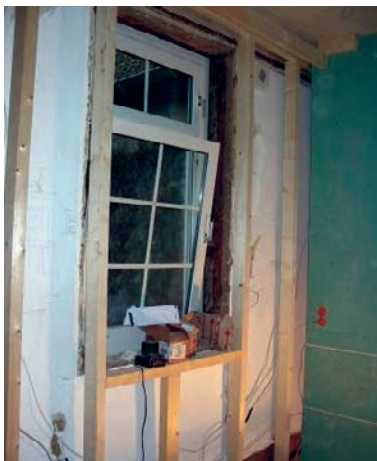
Slika 3-11 Drvena potkonstrukcija za unutarnju izolaciju [159]
