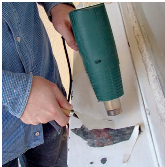
Slika 4-42 Skidanje starog premaza fenom [190]
