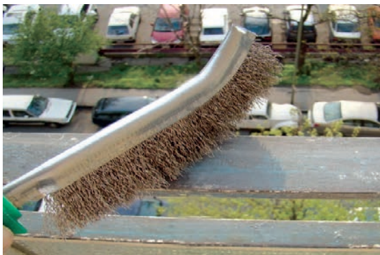
Slika 4-38 Ručno skidanje korozije žičanom četkom [190]
