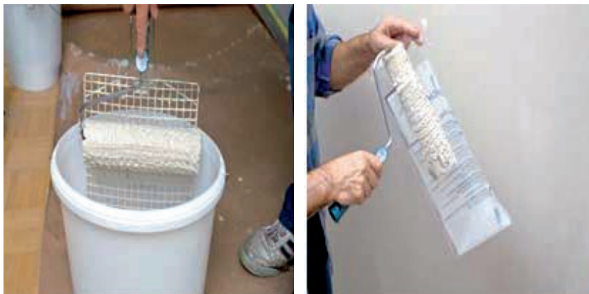
Slika 6-5 Primjer čišćenja alata [201]
