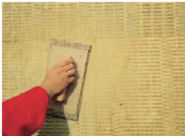
Slika 2-33 Brušenje EPS-a i mineralne vune [10]
