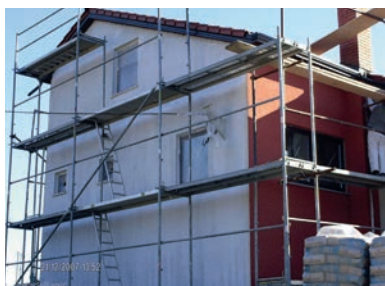
Slika 1-106 Priprema za fasadu [68]
