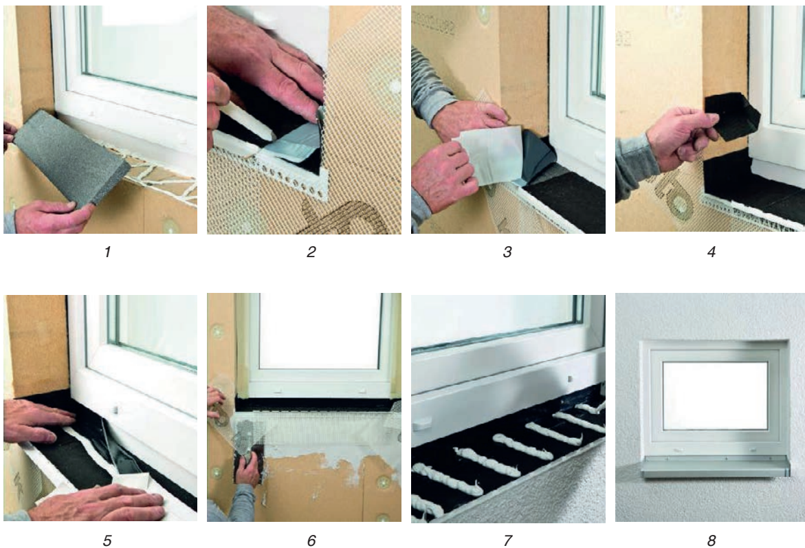
Slika 2-63 Proces ugradnje prozorske klupčice [10]
