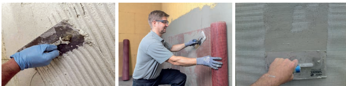
Slika 2-8 Pri nanošenju temeljnog polimercementnog sloja na mineralnu vunu utiskuje se staklena mrežica [10]
