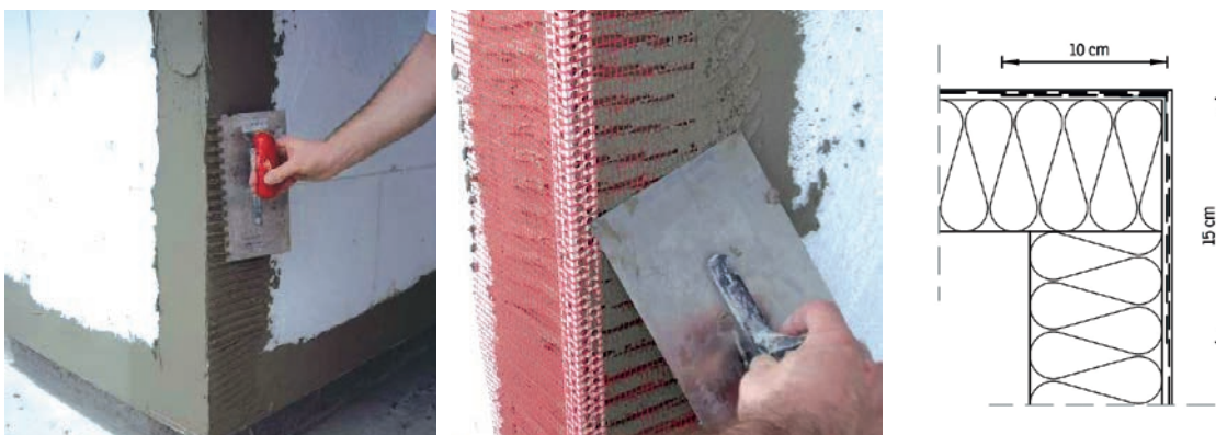
Slika 2-55 Izvedba ruba i kuta pomoću kutnog profila [10] [102]
