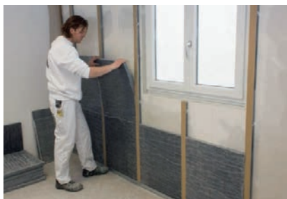
Ugradnja toplinske izolacije
