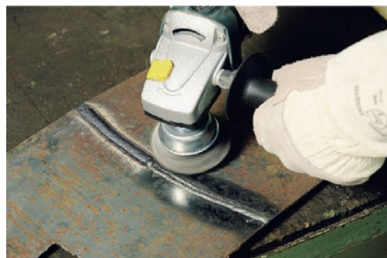
Slika 4-39 Strojno skidanje korozije žičanom četkom [192]
