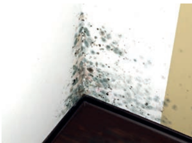
Slika 1-88 Plijesan i gljivice na površini [60]
