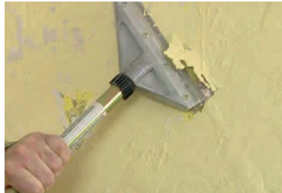
Slika 1-87 Čišćenje i odmaščivanje lakiranih naliča [58]
