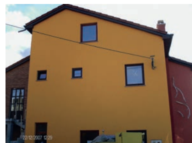
Slika 1-108 Gotova fasada kuće [68]
