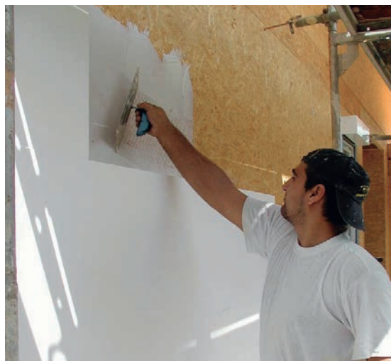
Slika 2-11 Izvedba ETICS sustava na OSB ploče [10]
