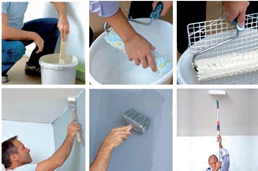
Slika 6-3 Primjer postupka ličenja stropa [201]
