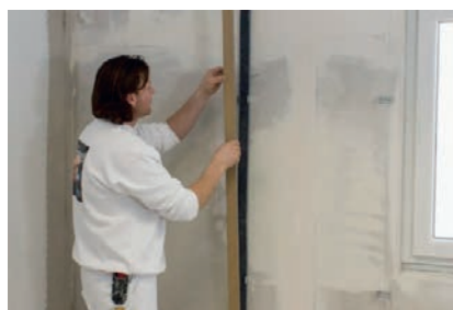
Ugradnja parne brane
