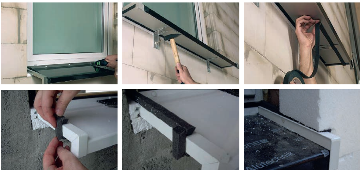
Slika 2-65 Ugradnja i brtvljenje prozorske klupčice [106], [10]
