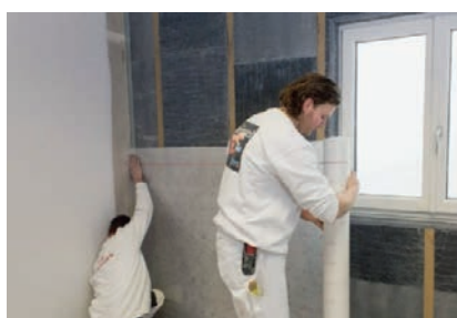
Ugradnja parne brane
