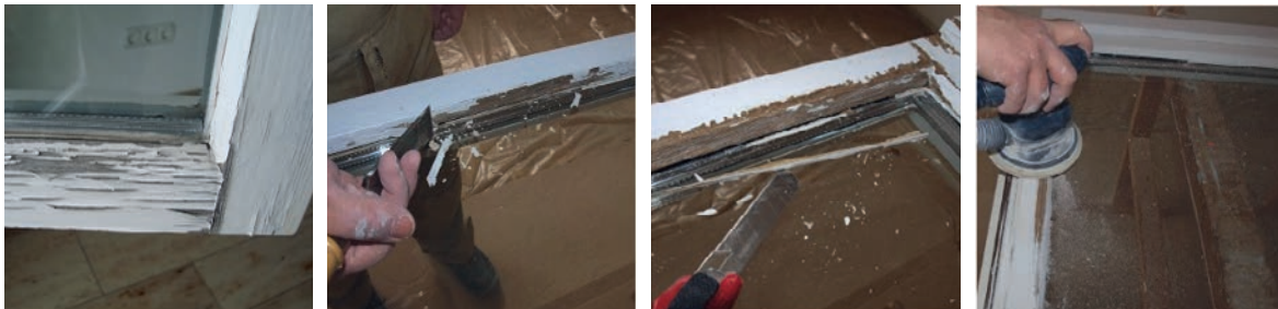
Slika 4-32 Primjer starog naliča, skidanje brtve sa stakala i brušenje starog naliča s drvene stolarije [187]
