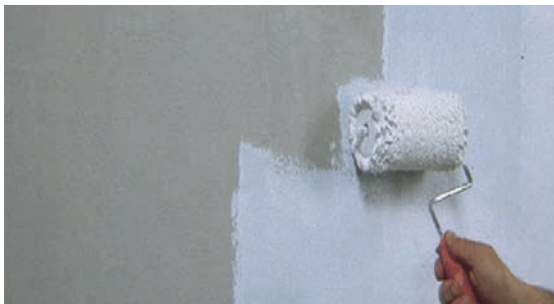
Slika 2-9 Nanošenje predpremaza [10]
