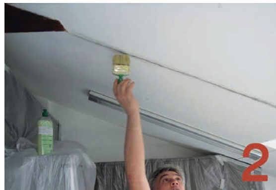
Slika 4-54 Impregniranje temeljnim premazom [196]
