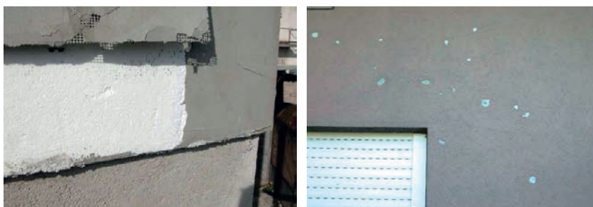
Slika 2-94 Pretanak armaturni sloj [10]
