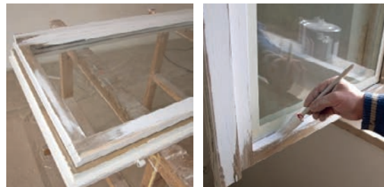
Slika 4-33 Primjer zaglađenog prozorskog krila i nanošenje premaza za drvo [187]
