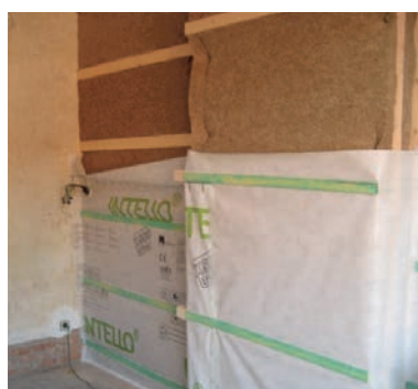
b) Postavljanje parne brane fiksiranjem na drvene nosače, uz postavljanje parne brane na strop te okolne zidove
