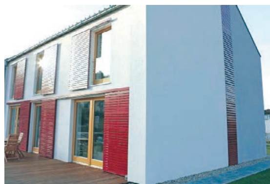
Slika 2-20 Podnožje u ravnini s pročeljem i istim završnim slojem [10]
