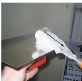
Slika 4-45 Nanošenje mase na gleter [190]
