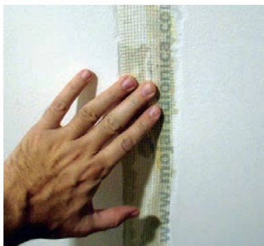
Slika 1-94 Rabciranje pukotine u zidu [63]
