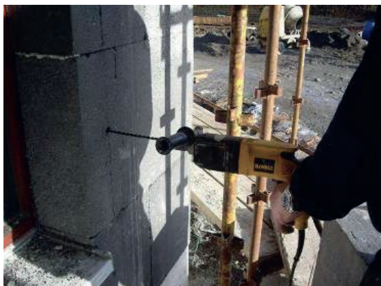
Slika 2-36 Bušenje rupa za pričvrsnice [10]
