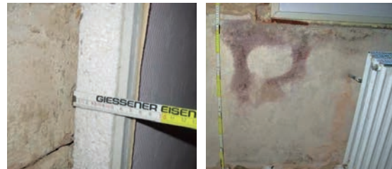
Slika 3-10 Razvoj gljivica nakon skidanja sloja unutarnje toplinske izolacije [158]
