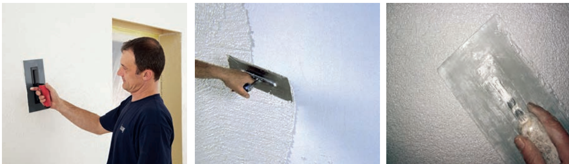
Slika 2-76 Nanošenje završno-dekorativne žbuke [10]
