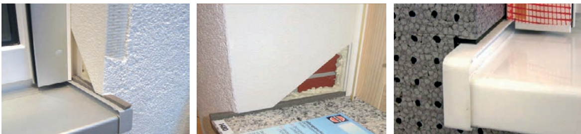
Slika 2-66 Izgled spoja ETICS sustava i prozorske klupčice [10]
