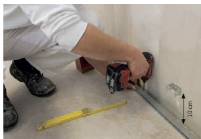
Ugradnja toplinske izolacije
