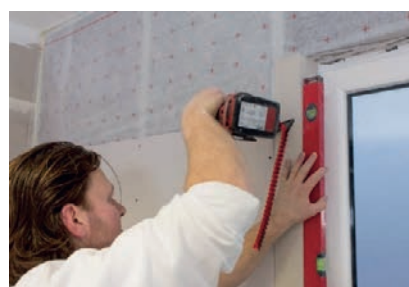
Ugradnja gipskartonskih ploča
