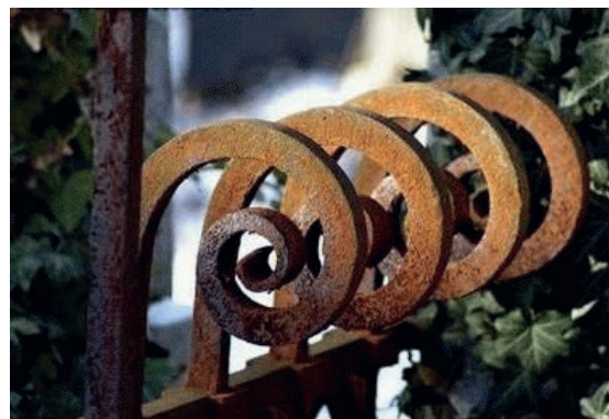
Slika 4-35 Korodirana ograda [189]
