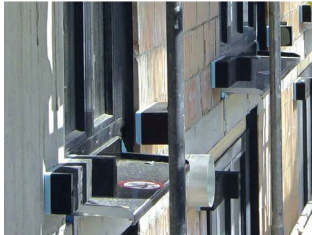
Slika 2-67 Priključivanje dodatnih elemenata za ETICS sustav [107]
