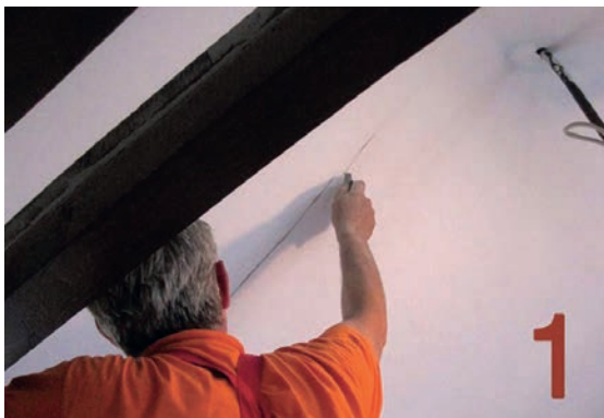
Slika 4-53 Zasjećanje pukotine skalpelom [196]
