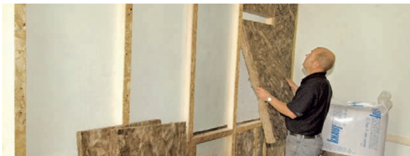
Slika 3-14 Prikaz postavljanja toplinske izolacije od mineralne vune te postavljanje parne brane na drvenu potkonstrukciju [160], [161]
