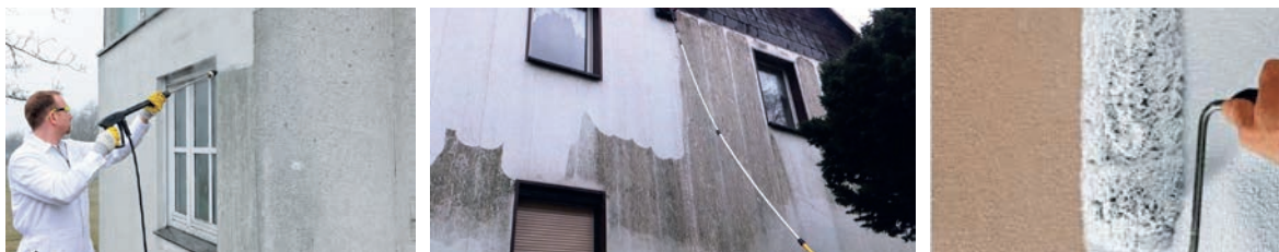
Slika 2-108 Sanacija pojave algi i gljivica [141], [142]
