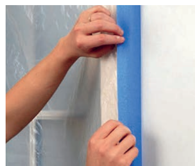
Slika 1-85 Zaštitne trake na rubnim mjestima [58]
