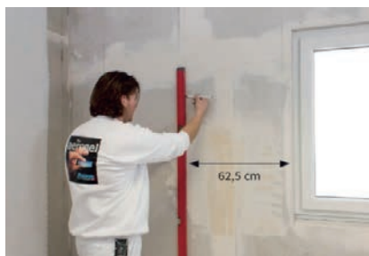
Postavljanje potkonstrukcije, drvene ili metalne
