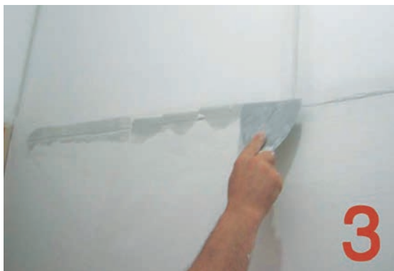
Slika 4-55 Ispunjavanje pukotine [196]
