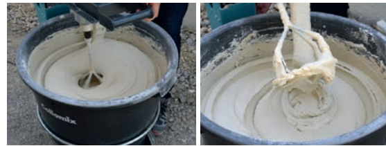
Slika 2-3 Priprema polimercementnog ljepila [79]
