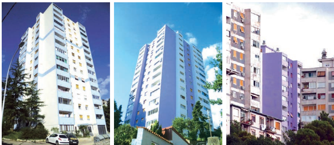
Slika 4-2 Primjeri bojanja fasada višestambenih zgrada u Rijeci nakon njihove energetske obnove [173]
