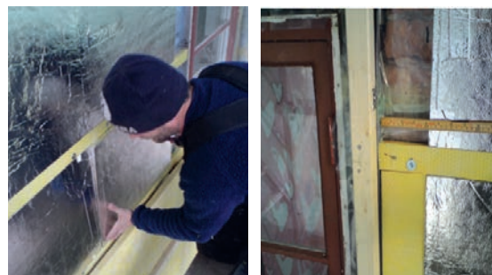
Slika 3-17 Prikaz unutarnje izolacije korištenjem vakumizolacijskih ploča [163]
