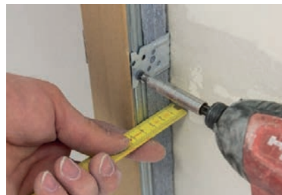
Ugradnja gipskartonskih ploča
