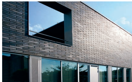
Slika 1-73 Podloga od klinker fasadne opeke [47]
