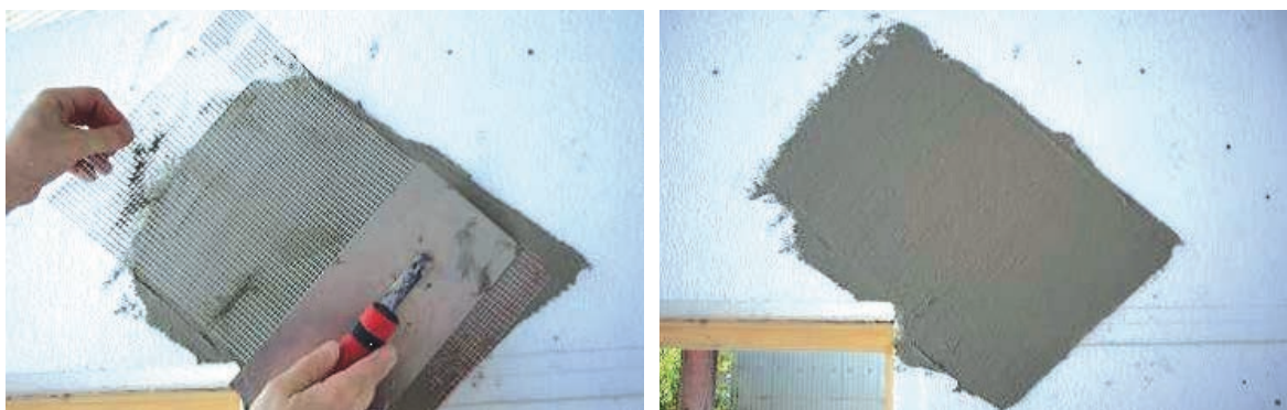
Slika 2-51 Dijagonalno armiranje uglova prozora [10]
