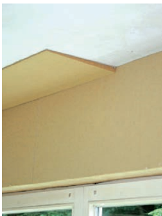
Slika 3-23 Prikaz klina toplinske izolacije susjednih građevnih dijelova [170]
