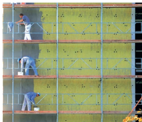
Slika 2-29 Postavljanje toplinsko-izolacijske ploče i lamele [10]
