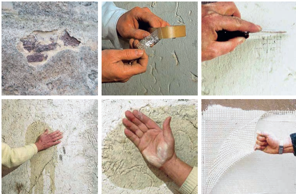
Slika 2 12 Načini ispitivanja postojeće žbuke prije izvođenja novog ETICS sustava [10]
