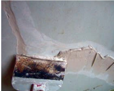
Slika 1-91 Popunjavanje pukotina i rupa [59]
