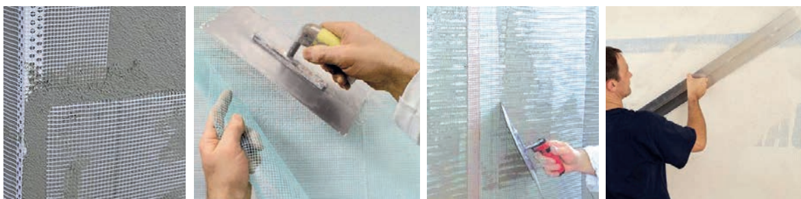
Slika 2-49 Umetanje staklene mrežice u prvi sloj morta [93], [94], [10]
