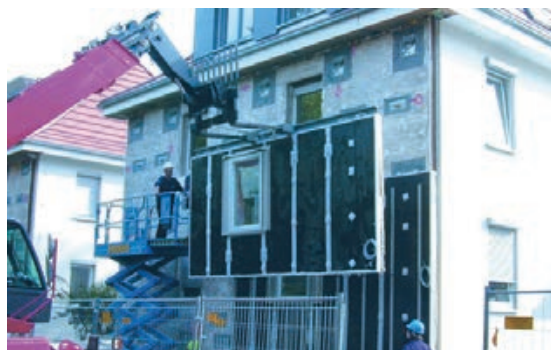
Slika 5-5 Energetska obnova postojećih zgrada korištenjem predgotovljenih drvenih panela [396]
