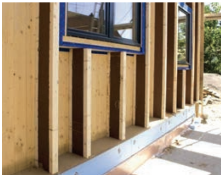
Detalj napuštene paropropusno- vodonepropusne trake na prozoru za ostvarivanje kontinuiteta s paropropusno-vodonepropusnom folijom zida
