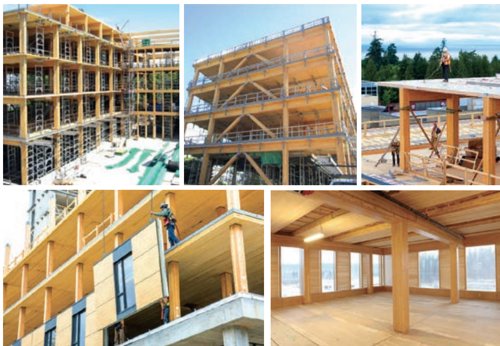
Slika 2-32 Izgled skeletnog sustava i elementi stijene [174], [175], [176], [177]
