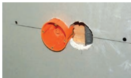
Ugradnja zrakonepropusne razvodne kutije u oblogu od gipskartonskih ploča
