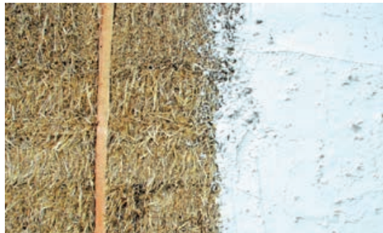
Slika 4-18 Žbukanje ispune od slame korištenjem vapnene žbuke [376]
