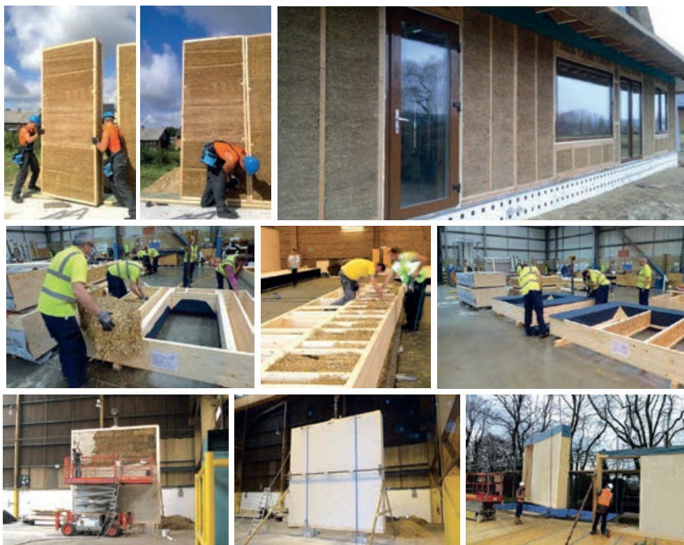
Slika 4-7 a Montažni elementi u zidu s ispunom od slame i ožbukani sustavi Ecococon i Modcell [359], [360], [361]
