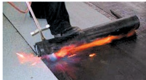
Slika 1-97 Varenje bitumenske ljepjenke [111]
