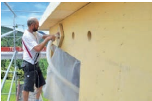
Korak 5: Upuhivanje rasute toplinske izolacije u međuprostor između toplinske izolacije i postojećeg zida
