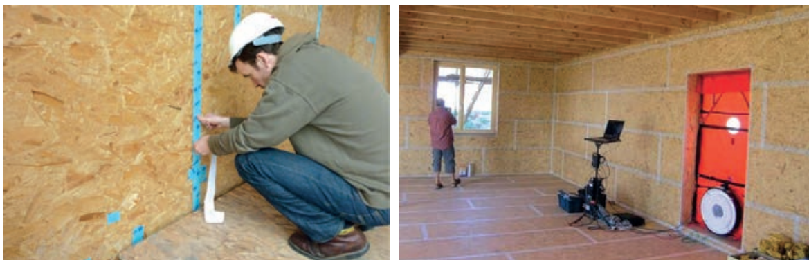
Slika 3-52 Primjer ostvarenja zrakonepropusne ovojnice korištenjem ploča [256]
