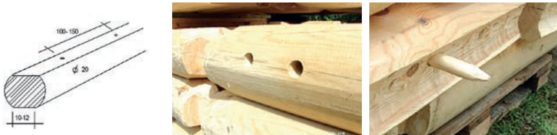
Slika 2-14 Osnovna obrada trupca u brvi [117], [161]
