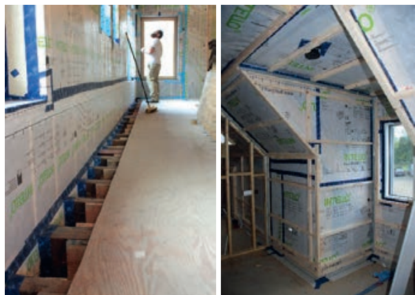
Slika 3-51 Primjer ostvarenja zrakonepropusne ovojnice korištenjem folija [253], [254], [255]
