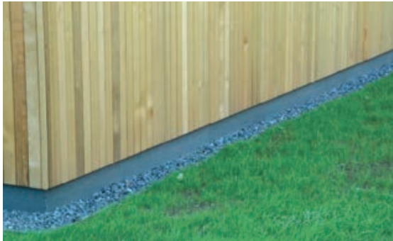
Slika 3-78 Prikaz vertikalne završne obloge s izvedenim podnožjem [217]
