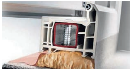
Slika 3-132 Brtvljenje folijama i ekspandirajućom brtvom [304]
