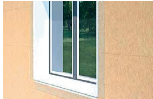
Korak 4: Ugradnja prozora u sloj toplinske izolacije
