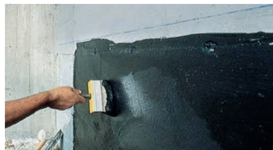
Slika 1-98 Hladni premaz bitumen [112]
