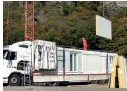
Slika 2-72 Primjer zaštite drvenih panela tijekom prijevoza [106]
