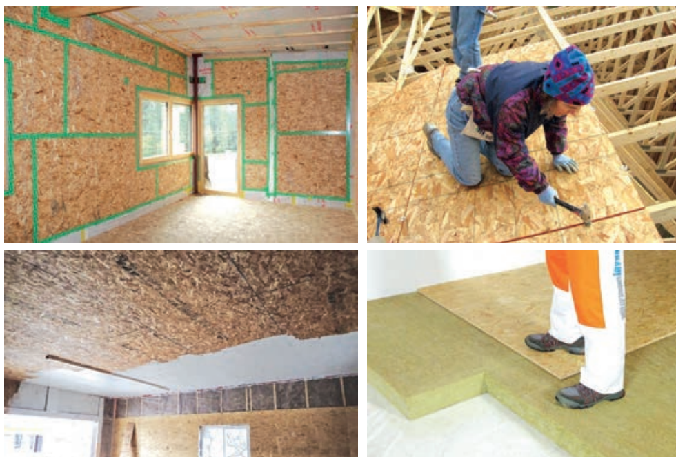
Slika 1-82 Primjena OSB ploča za gradnju energetski učinkovitih zgrada [89], [90], [91], [92]
