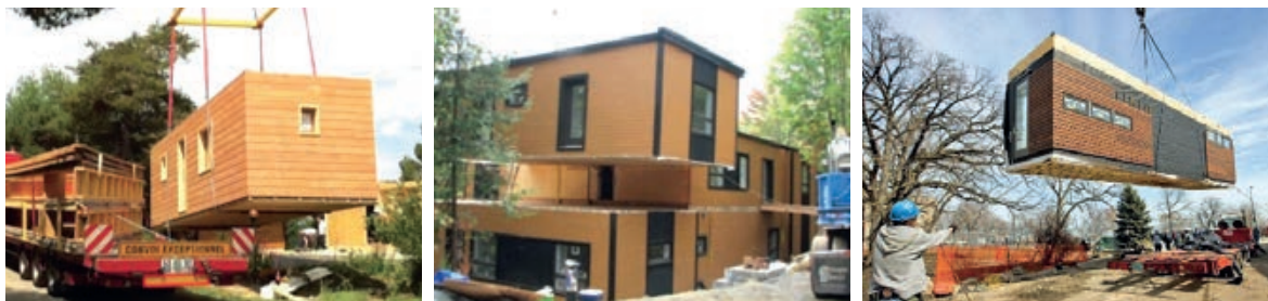
Slika 2-42 Transport prostornog elementa i montaža zgrade od prostornih elemenata [187], [188], [189]
