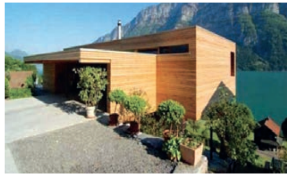
Slika 2-3 Trajna nosiva drvena konstrukcija [146]
