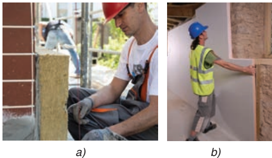
Slika 1-106 Položaj toplinske izolacije u zgradi a) s vanjske strane, b) s unutarnje strane [13], [118]
