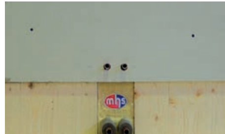
Oblaganje niše s ugrađenim cijevima radijatora pomoću gipskartonskih ploča
