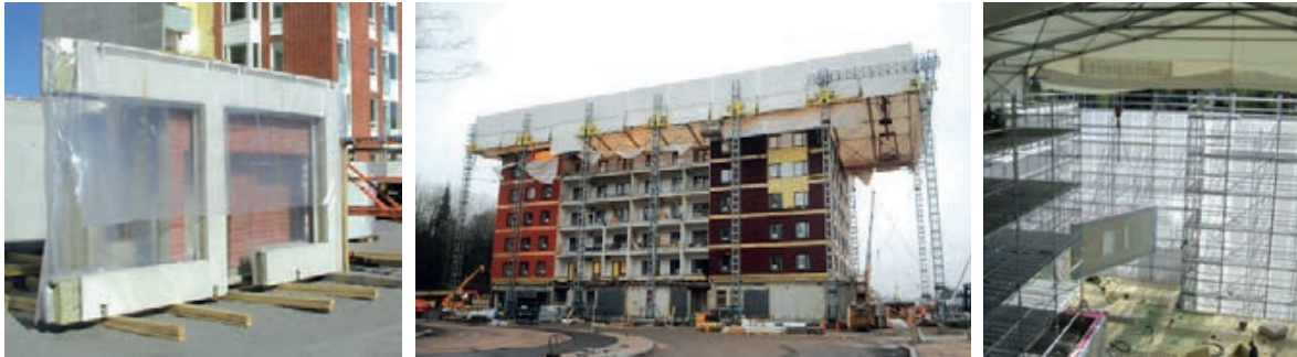
Slika 2-70 Primjeri zaštite pojedinačnih drvenih panela, odnosno zaštite cjelokupne drvene kuće tijekom gradnje [206]
