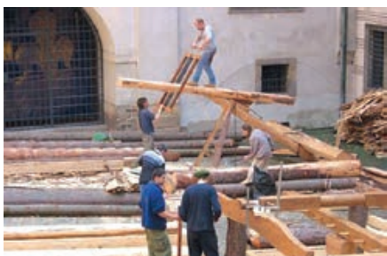
Slika 1-3 Rezanje i piljenje građe [3]
