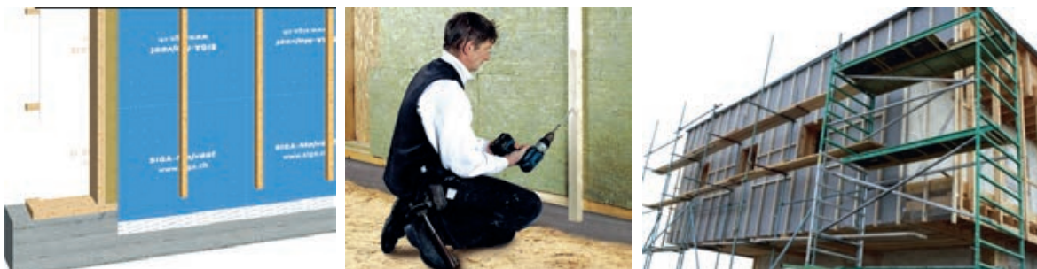
Slika 3-69 Ostvarenje zračnog sloja letvicama drvene potkonstrukcije [266], [265]
