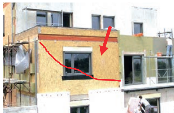
Slika 6-2 Izvođenje ETICS sustava na vlažnu podlogu od OSB ploča [12]
