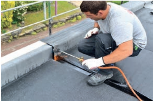
Postavljanje parne brane varenjem
