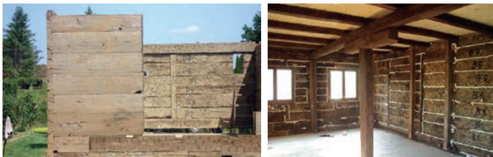
Slika 2-12 Sustavi punih drvenih stijena s horizontalnom građom [158]
