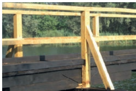
Slika 2-7 Vezovi pojačanja ili podebljanja i njegova primjena u drvenoj konstrukciji [148], [150]
