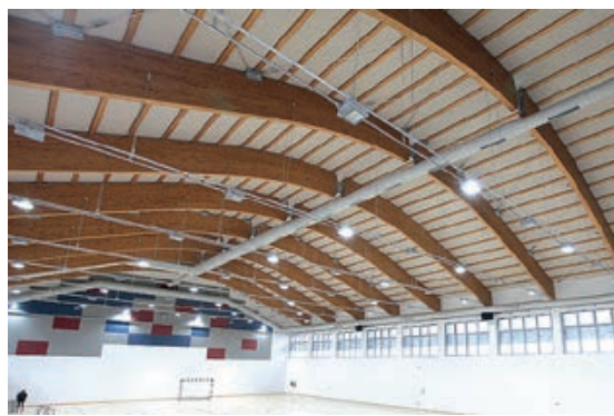
Slika 1-70 Primjer krova sportske dvorane izvedenog s lučno lameliranim drvom [78]
