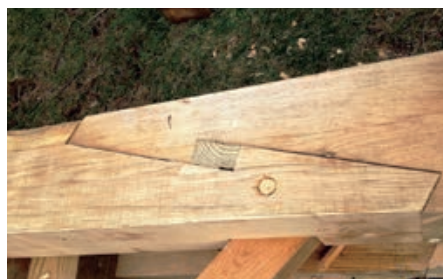
Slika 2-5 Vezovi horizontalnog produženja i njegova primjena u drvenoj konstrukciji [148], [149]
