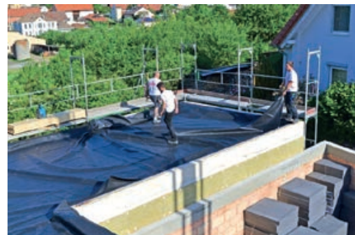
Razvlačenje hidroizolacijske membrane
