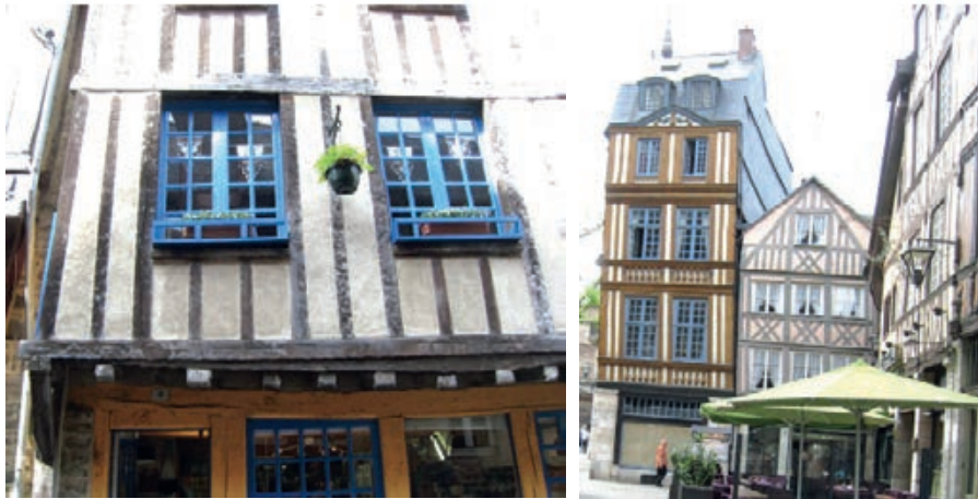
Slika 2-30 Slike građevina s višekratnom kanatnom konstrukcijom [172]
