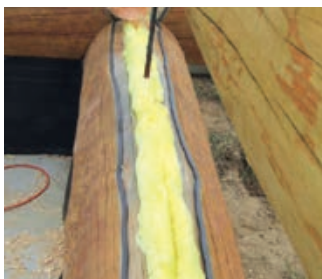
Slika 2-24 Postizanje zrakonepropusnosti staklenom vunom [167]
