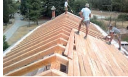
Slika 1-6 Izrada drvenih krovišta [6]
