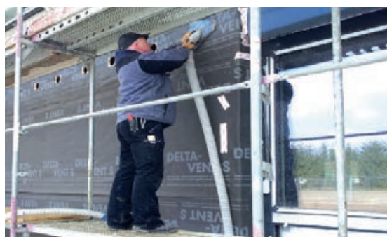
Slika 3-65 Ugradnja toplinske izolacije s vanjske strane upuhivanjem u međuprostor između zida i paropropusno-vodonepropusne folije [261]
