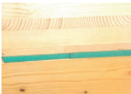
Primjer upotrebe elastomernog ležaja za sprečavanje prijenosa udarne buke
