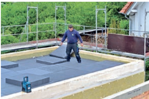
Postavljanje drugog sloja toplinske izolacije
