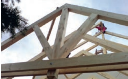
Slika 1-5 Izrada drvenih krovišta [5]
