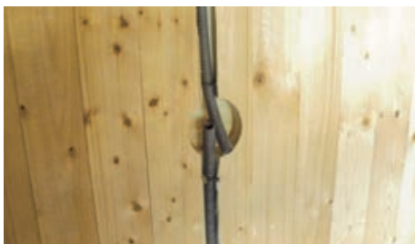
Ugradnja bužira u urezane kanale za instalacije
