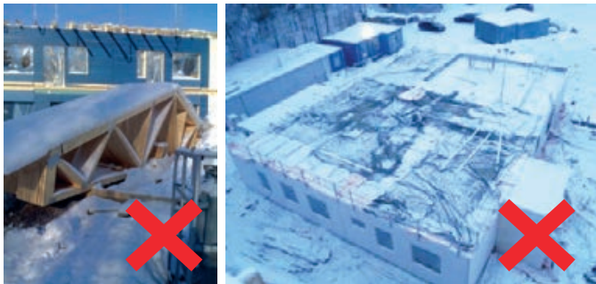
Slika 2-71 Primjeri nezaštićenih drvenih konstrukcija tijekom gradnje
