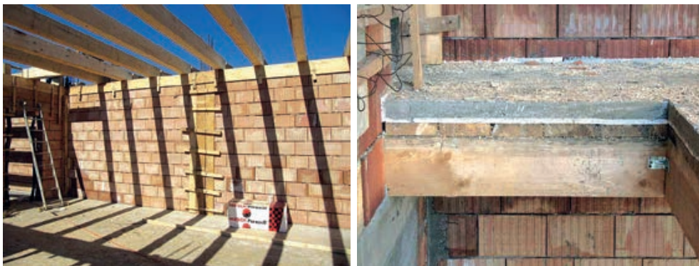
Slika 3-100 Drvena međukatna konstrukcija oslonjena na zidanu konstrukciju [292]
