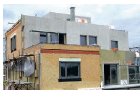
Izvođenje ETICS sustava na drvenu konstrukciju
