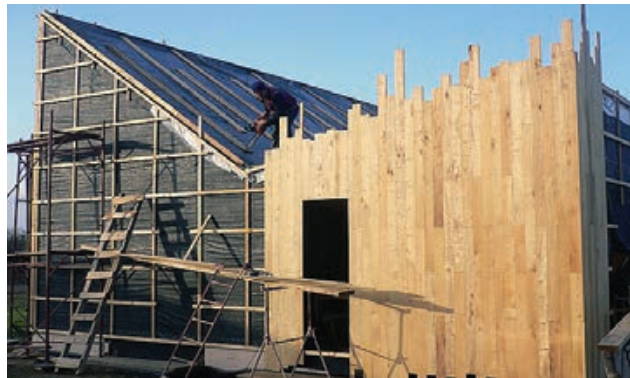
Izvođenje paropropusno-vodonepropusne folije ispod završne obloge
