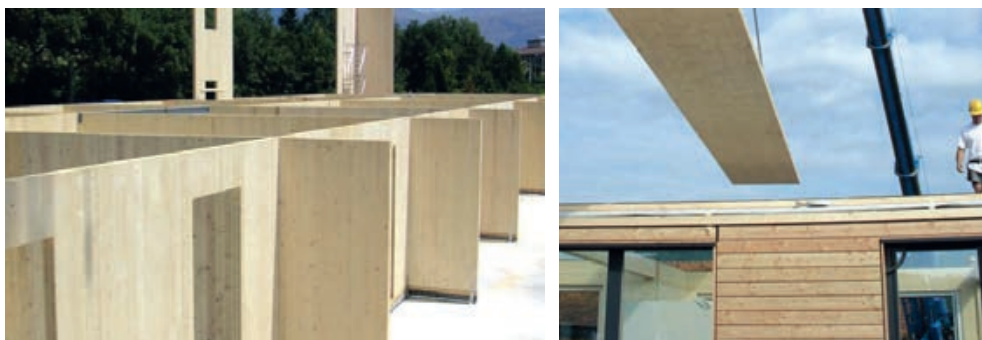
Slika 2-54 Tehnologija gradnje pomoću križno lameliranih ploča [196]
