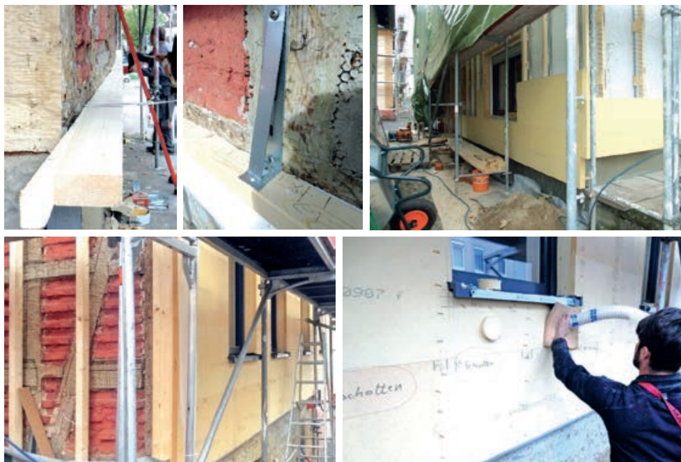
Slika 5-1 Fotografije energetske obnove postojeće zgrade upuhivanjem rasute toplinske izolacije [389], [390], [391]
