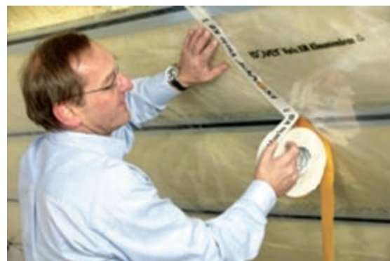
Slika 3-175 Lijepljenje parne brane s donje strane [323]
