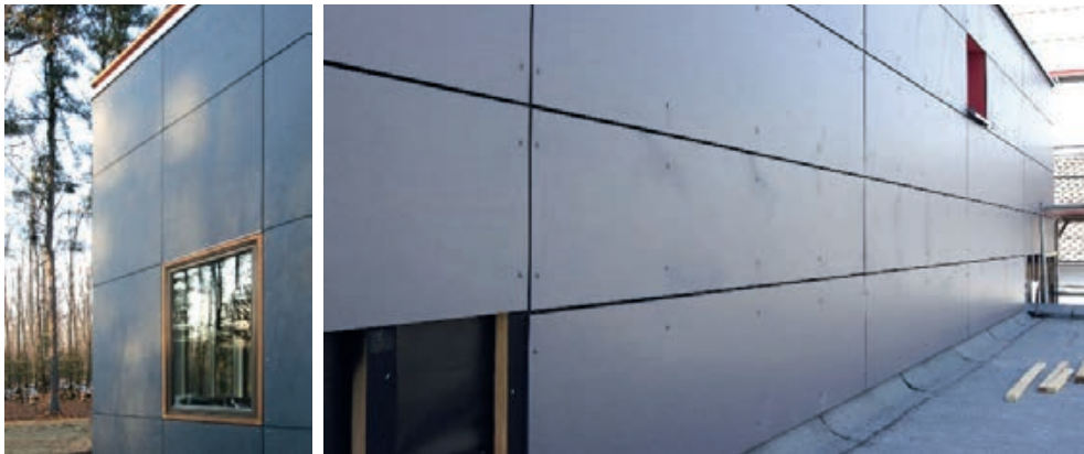
Slika 3-75 Primjeri oblaganja drvenim pločama [67], [275]
