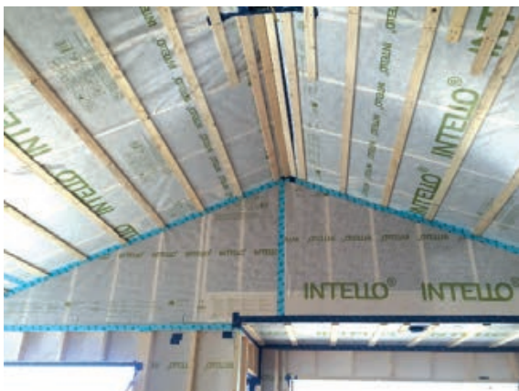
Slika 3-51 Primjer ostvarenja zrakonepropusne ovojnice korištenjem folija [253], [254], [255]
