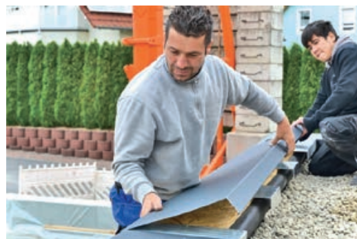
Izvođenje limarskih radova oko atike
