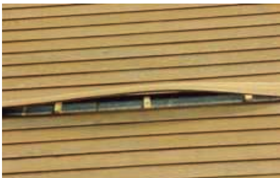
Slika 6-10 Izvijanje daske vanjske obloge [405]
