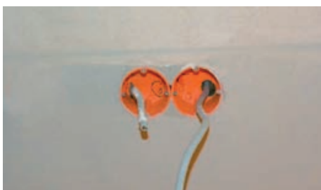
Ugradnja zrakonepropusne razvodne kutije
