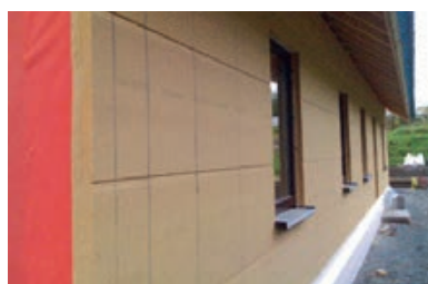
Slika 3-22 Tvrde izolacijske ploče od drvenih vlakana s vanjske strane drvene kuće [229]
