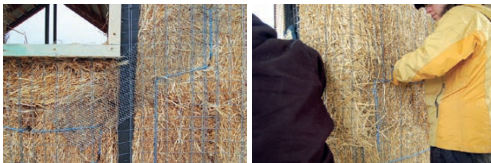
Slika 4-19 Postavljanje čelične „rabic“ mreže protiv glodavaca i armiranje same žbuke [377]
