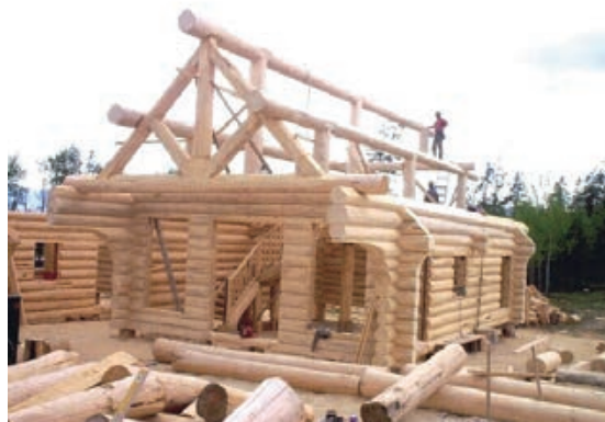
Slika 1-57 Gradnja kuće od oble građe [67]
