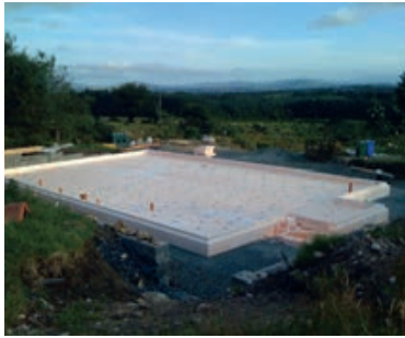
Slika 3-6 Izvođenje toplinske izolacije ispod poda na tlu korištenjem XPS-a [220]
