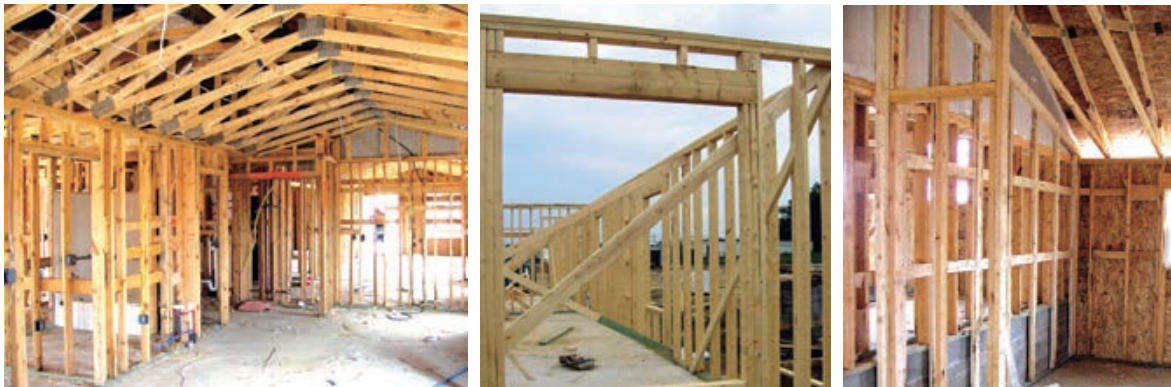
Slika 2-31 Američki tip novije kanatne stijene s tanjom građom [173]
