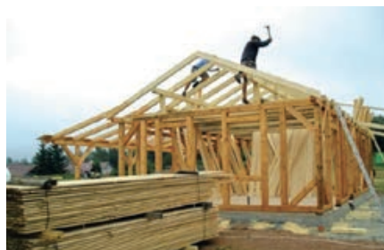
Slika 1-4 Izrada drvenih konstrukcija [4]
