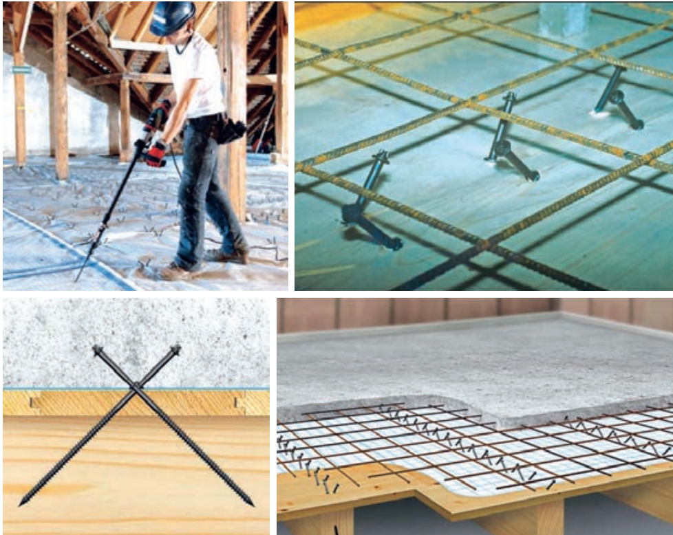
Slika 3-119 Spregnuti sustav drvo-beton [296]
