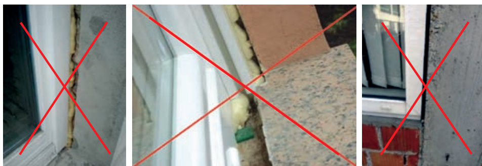
Slika 3-130 Brtvljenje međuprostora PUR pjenom [303], [13]
