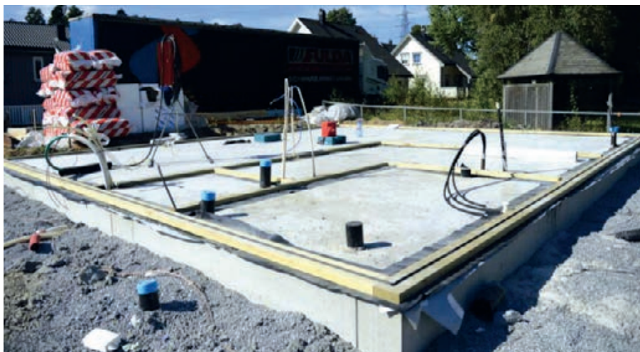
Slika 2-77 Prikaz završenih pripremnih radova neposredno prije početka montaže [209]
