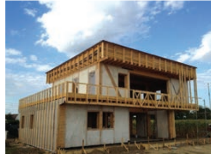
Izgled zgrade nakon žbukanja
