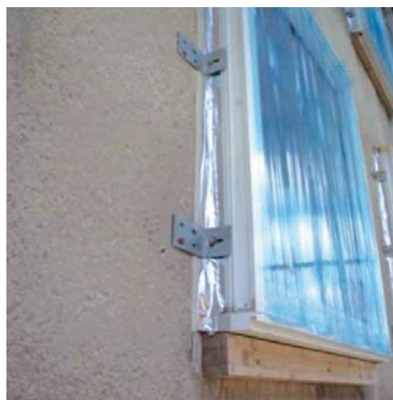
Slika 3-138 Pravilna pozicija stolarije za ugradnju RAL montažom u vrlo niskoenergetske zgrade i zgrade gotovo nulte energije
