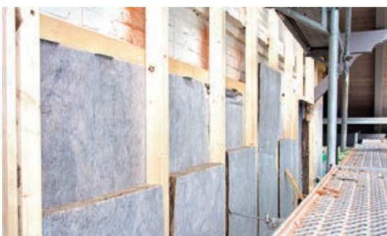
Slika 3-64 Ugradnja ploča toplinske izolacije između nosača potkonstrukcije ventilirane fasade [263]
