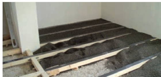
Slika 3-127 Postavljanje konstrukcije poda i usipavanje suhog nasipa [301]
