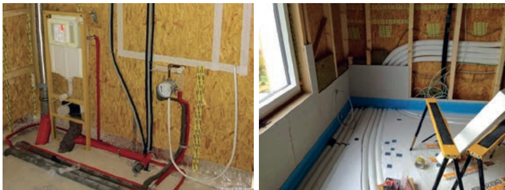
Slika 3-88 Prikaz instalacija u drvenoj kući [286], [287]
