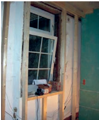
Slika 3-89 Drvena potkonstrukcija za unutarnju izolaciju [288]
