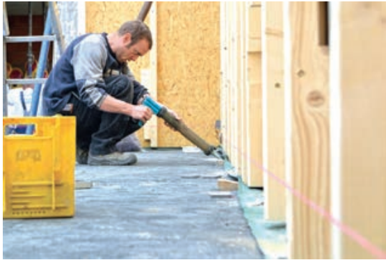
Slika 3-47 Brtvljenje hidroizolacije poda i zrakonepropusne folije ispod montažnih panela [251]
