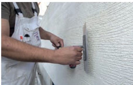
Izvođenje završne dekorativne žbuke ETICS sustava
