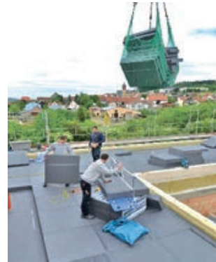
Postavljanje toplinske izolacije
