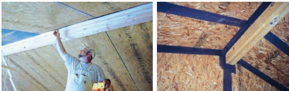
Slika 1-90 Brtvljenje drvenih SIP panela za ostvarenje zrakonepropusnosti vanjske ovojnice zgrade [104], [105]
