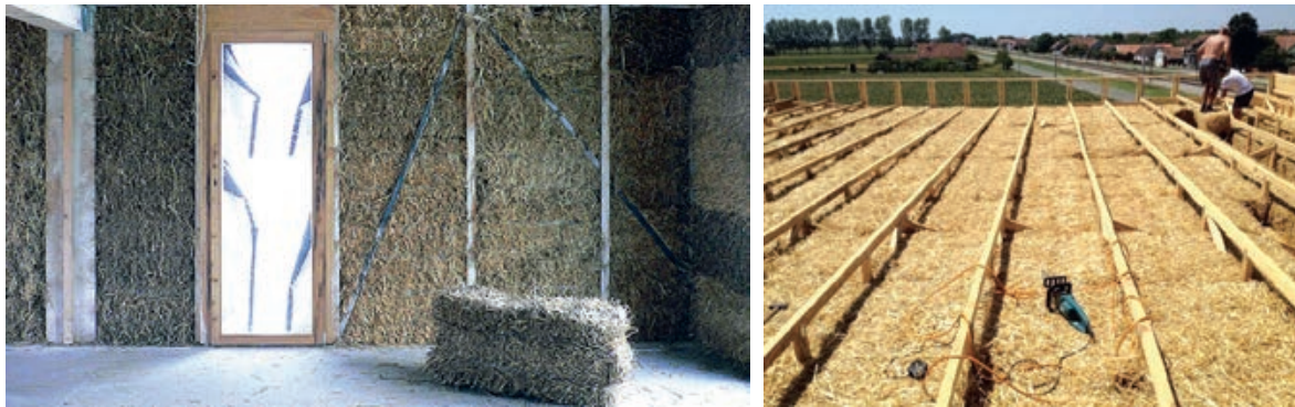
Slika 4-4 Drvena konstrukcija s ispunom od slame [354], [355]
