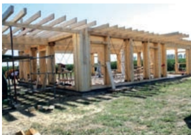
Slika 2-27 Primjer drvene kuće građene kanatnim sustavom [170]
