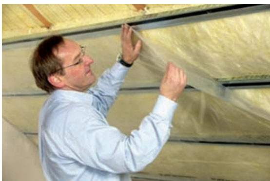
Slika 3-174 Postavljanje parne brane s donje strane [323]
