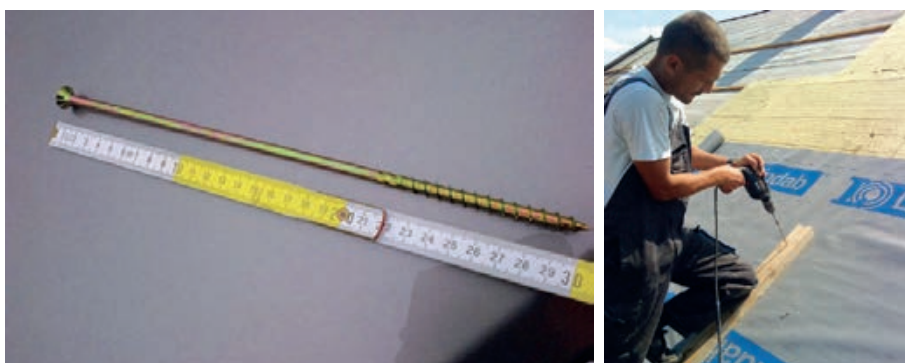
Slika 3-193 Pričvršćenje kontraletvi ubušavanjem sistemskih vijaka SFS-WFR-T-6x240 mm [338]
