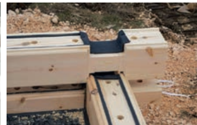
Slika 2-23 Postizanje zrakonepropusnosti poliuretanskim brtvama [161]
