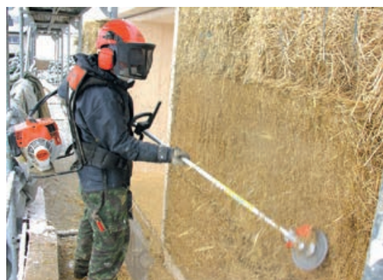
Slika 4-14 Dotjerivanje vanjske površine trimerom prije žbukanja [369]
