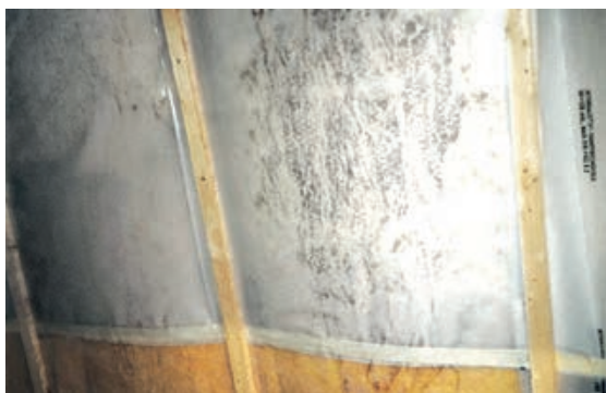
Slika 6-1 Stvaranje gljivica i plijesni zbog nemogućnosti isušivanja [309]
