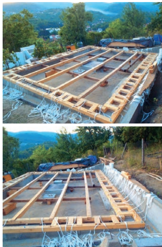
Slika 3-11 Prikaz izvođenja drvenog roštilja uzdignutog poda novosagrađene kuće od slame [223]
