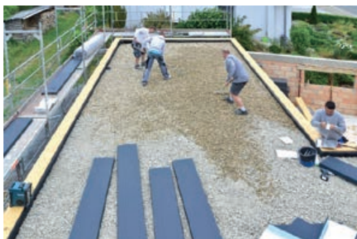
Zaštita hidroizolacije sa šljunkom
