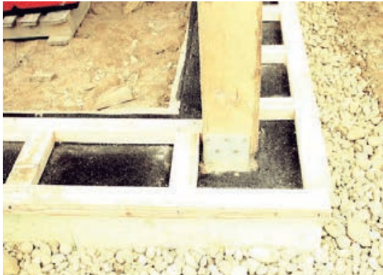
Slika 4-9 Spoj konstrukcije na hidroizolaciji temelja [346]
