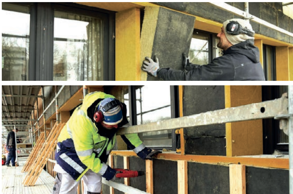
Slika 5-4 Ugradnja toplinske izolacije između potkonstrukcije te osiguranje sloja ventilirajućeg zraka [92], [395]
