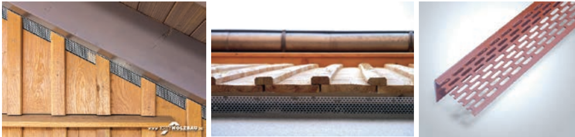
Slika 3-83 Prikaz ugradnje perforiranog lima za osiguranje postizanja ventilacije [281], [282], [283]
