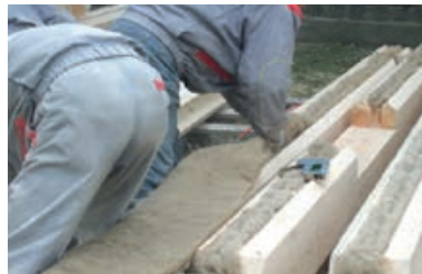
Slika 2-22 Korištenje ovčje vune za postizanje zrakonepropusnosti [161]
