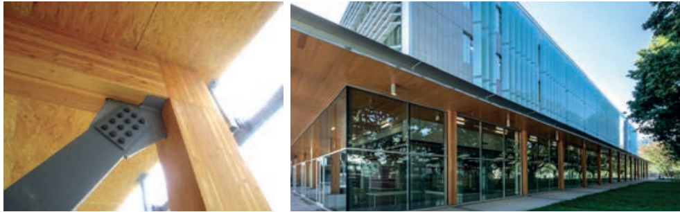
Slika 2-34 Čelična dijagonala vertikalnog sprega (lijevo), velike staklene plohe (desno) [176], [179]
