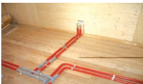
Postavljanje instalacija u slojeve poda
