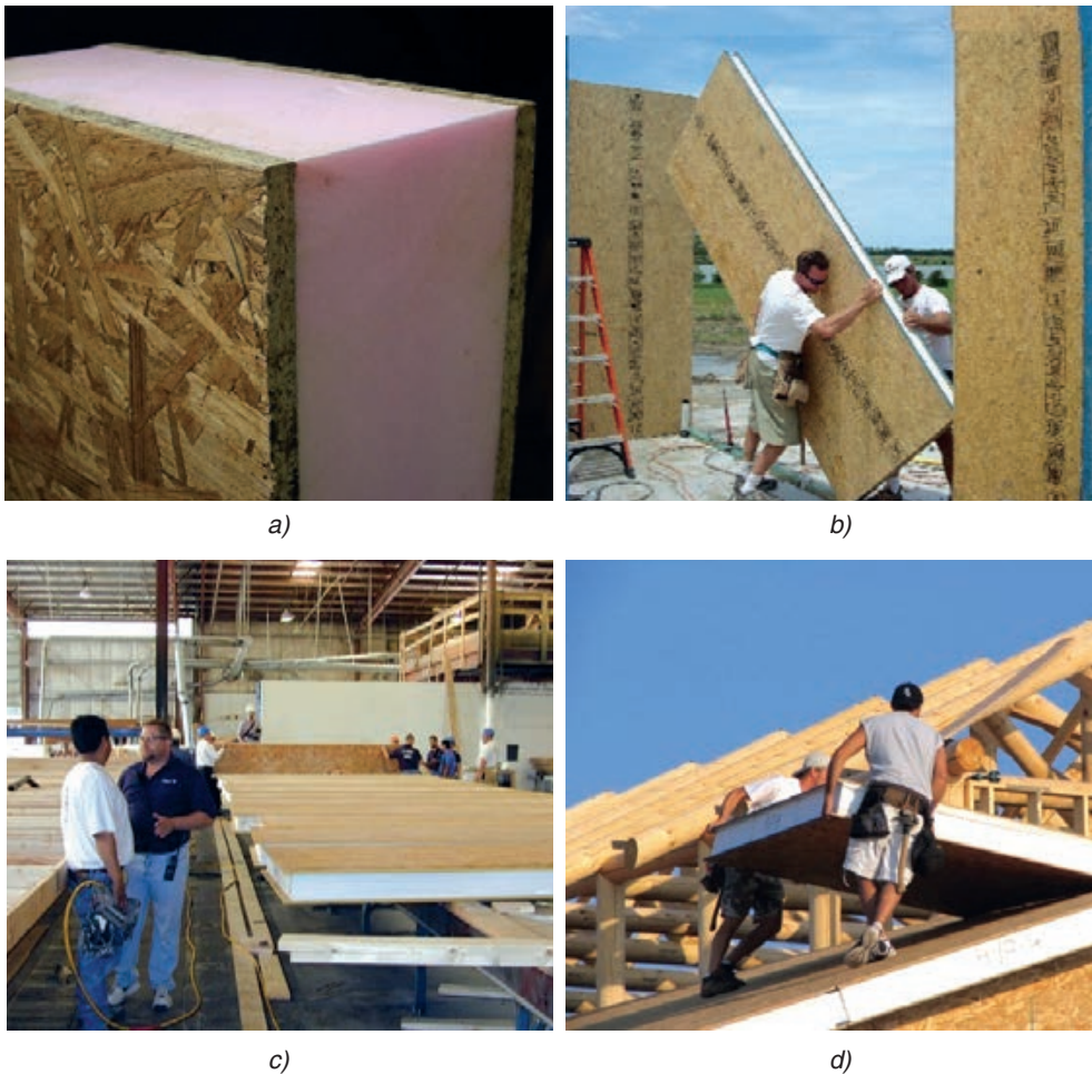
Slika 1-88 Drveni SIP paneli: a) detalj, b) montaža zida, c) proizvodnja u tvornici, d) montaža krovnog panela [100], [101], [102]
