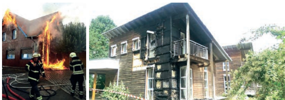
Slika 3-85 Primjer požara koji su se proširili po fasadi drvene zgrade [285]
