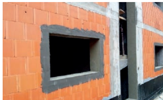
Slika 3-137 Žbukanje zidarskih otvora [306]
