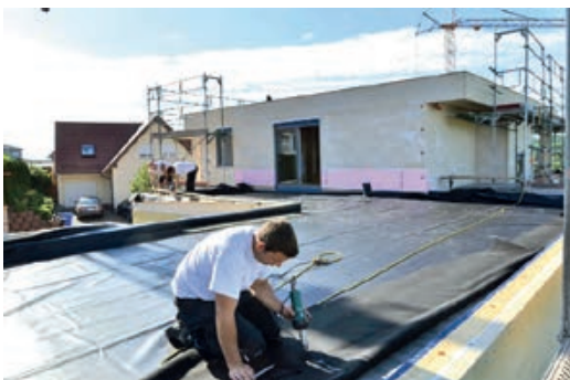
Međusobno varenje hidroizolacijske membrane
