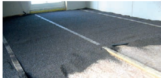
Slika 3-126 Jednostavno poravnanje između drvenih elemenata stropa [300]
