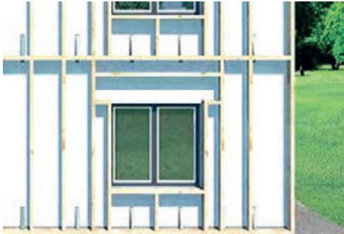
Korak 1: Ugradnja drvene potkonstrukcije na pročelje postojeće zgrade
