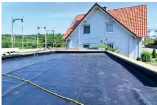
Postavljena hidroizolacijska membrana
