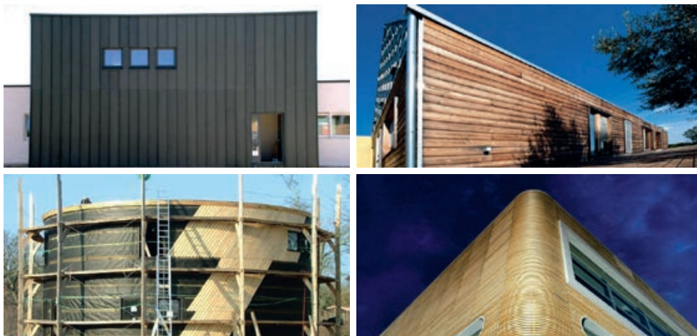
Slika 3-71 Primjeri oblaganja daskama i letvicama [245], [266]
