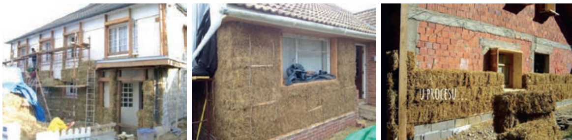
Slika 4-7 b Prikaz moguće energetske obnove postojećih zgrada korištenjem bala slame [362], [363], [364]
