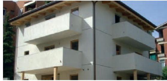
Slika 3-40 Drvena kuća s ETICS sustavom i dilatacijskim fugama u razini međukatnog spoja [245]
