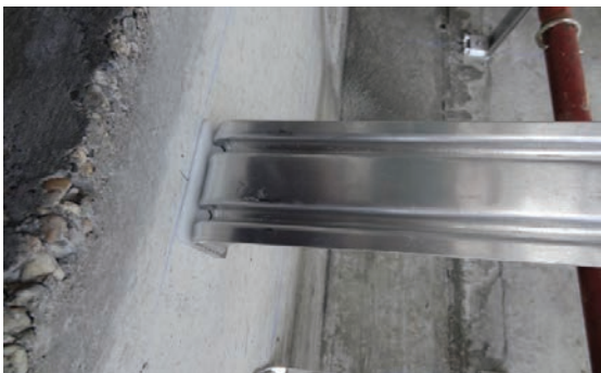
Slika 4-115 Prekid toplinskog mosta kod nosača ventiliranih fasada [11]
