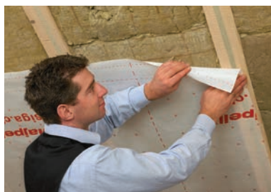
Lijepljenje parne brane (paro i zrakonepropusne folije)
