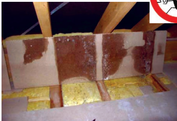
Slika 5-10 Vlaženje i truljenje materijala uslijed kondenzacije vodene pare [11]
