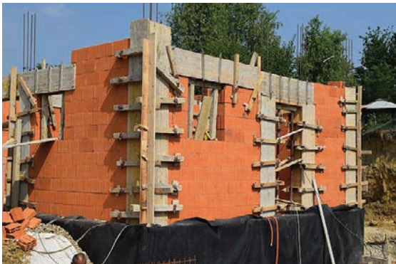
Slika 4-66 Monolitni AB nadvoj [102]
