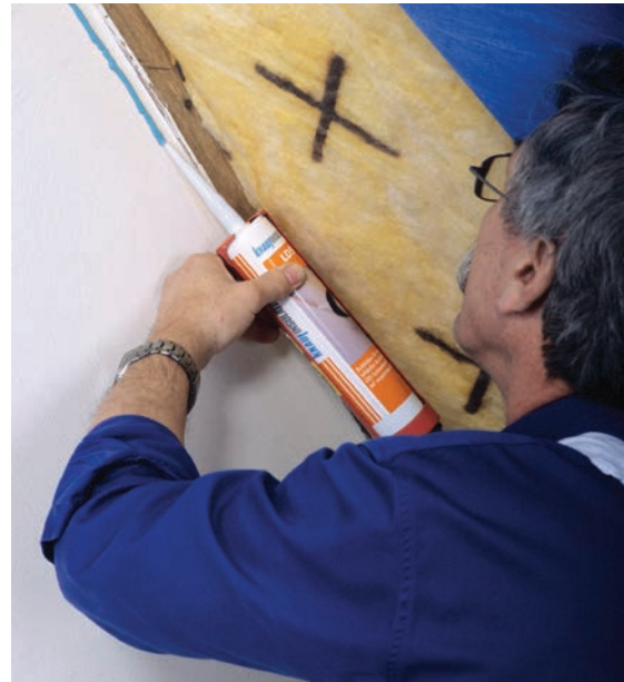
Slika 5-6 Brtvljenje parne brane specijalnim brtvjenim masama za ostale dijelove konstrukcije [31]
