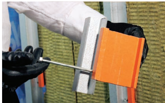
Slika 4-114 Prekid točkastih toplinskih mostova kod ventiliranih fasada [128]
