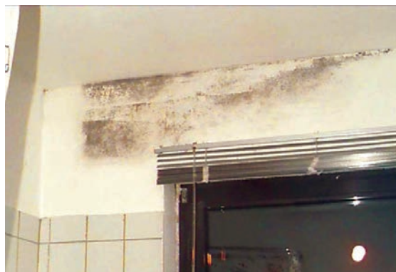
Slika 4-102 Fotografija građevinske štete uzrokovane toplinskim mostom [127]
