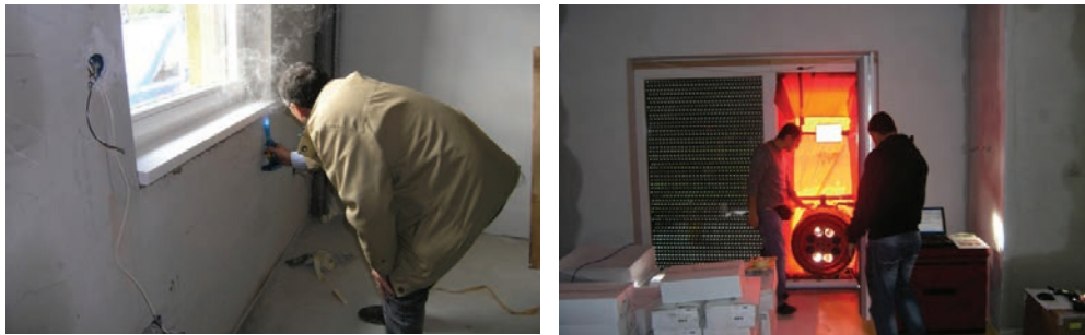
Slika 5-31 Mjerenje zrakopropusnosti u rochbau fazi [31]
