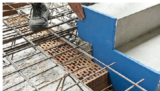
Slika 4-134 Ugradnja predgotovljenog stubišta sa zvučnim odvajanjem od zidova tijekom gradnje [130]
