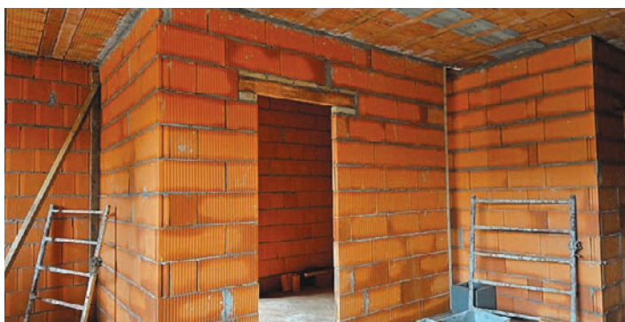
Slika 4-52 Pregradni zid od šupljih opekarskih ploča [91]
