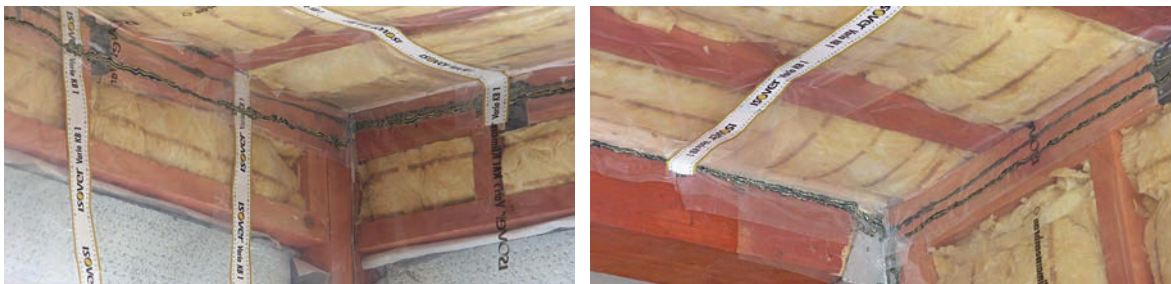
Slika 5-17 Brtvljenje lagane drvene konstrukcije [165]
