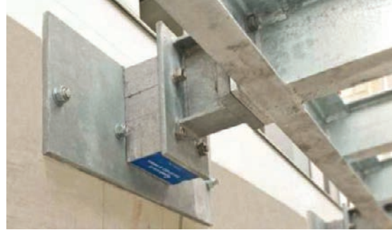
Slika 4-128 Predgotovljeni čelični balkon ugrađen na postojeći zid [130]
