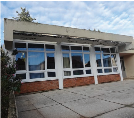
Slika 4-135 Nepomični betonski briseleji za zaštitu od sunca s južne strane zgrade
