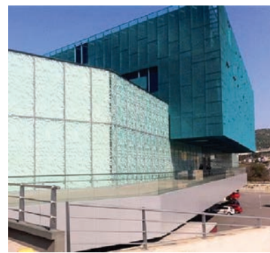
Slika 4-98 Polustrukturalna jednostruka element fasada [125]
