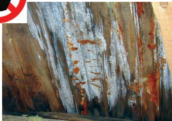
Slika 5-10 Vlaženje i truljenje materijala uslijed kondenzacije vodene pare [11]
