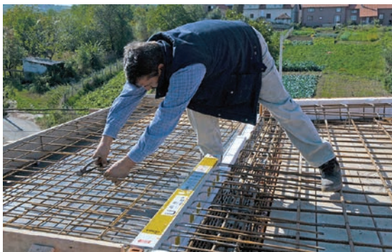
Slika 4-122 Ugradnja nosivog toplinskog-izolacijskog elementa u armaturu stropne ploče [131]
