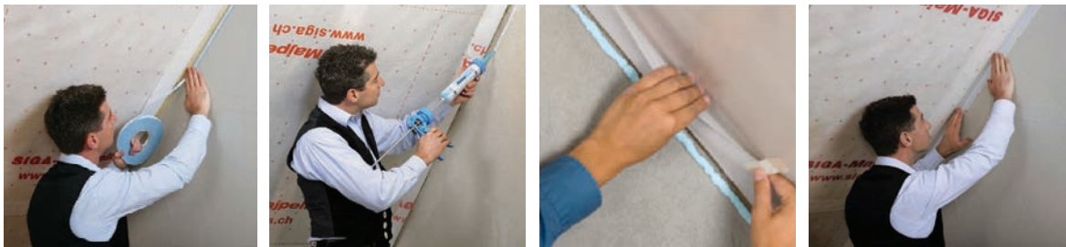
Na čistu podlogu nanijeti obostrano ljepljivu traku ili specijalnu brtvenu masu i čvrsto pritisnuti po cijeloj dužini spoja
