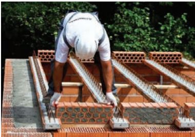
Slika 4-63 Fert strop [99]
