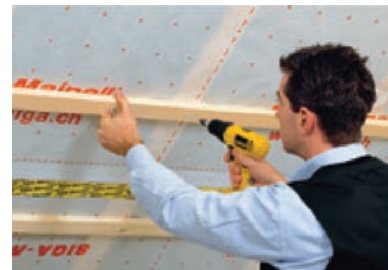
Pričvršćenje potkonstrukcije za oblogu gipskartonskim pločama
