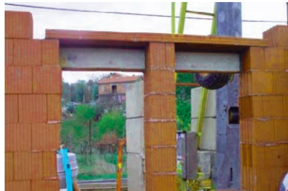
Slika 4-67 Montažni AB nadvoj [103]
