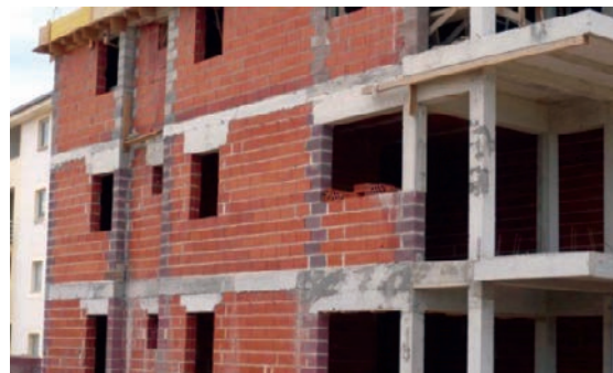
Slika 4-38 Primjer zidane konstrukcije [11]
