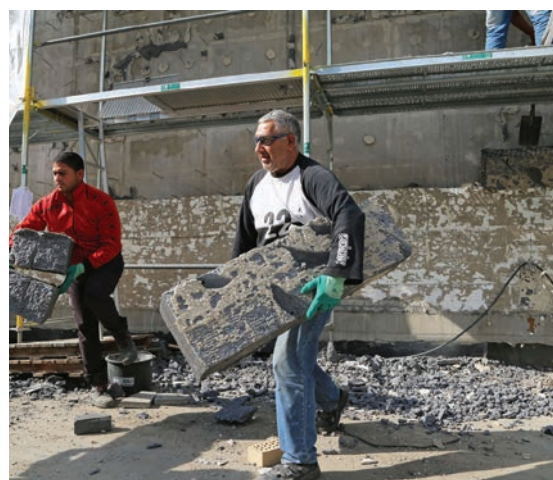
Slika 1-15 Zbrinjavanje toplinske izolacije [32]
