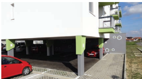
Slika 4-58 Betonski stup izoliran za sprječavanje toplinskog mosta [11]
