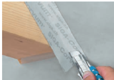
Brtvljenje oko drvenih nosača
