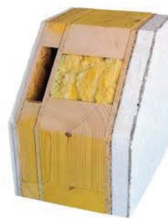
Slika 4-56 Vanjski zid – drvena konstrukcija [94]
