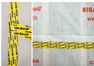
Izgled spoja nakon lijepljenja jednostrano ljepljivim trakama
