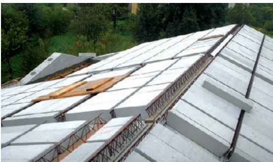
Slika 4-80 Masivni kosi krov – Bijeli strop [111]
