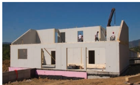
Slika 4-42 Primjer predgotovljene kuće
