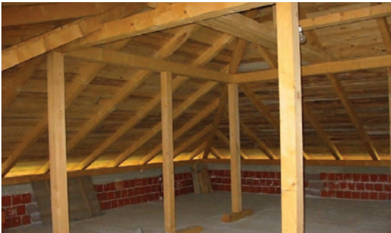
Slika 4-79 Drvena krovna konstrukcija [110]
