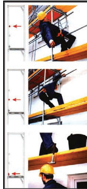
Slika 4-152 Zaštita radnika prilikom rada na velikim visinama
