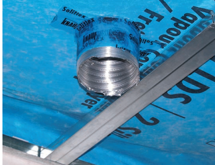
Slika 5-4 Izvedena parna brana [31]
