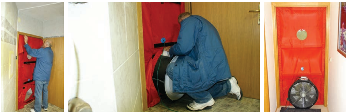
Slika 5-30 Postavljanje uređaja prilikom mjerenja zrakonepropusnosti zgrade [11]
