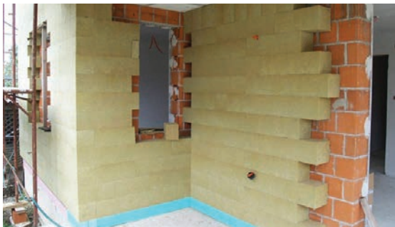
Slika 4-55 Masivni zid s toplinskom izolacijom od lamela mineralne vune [93]
