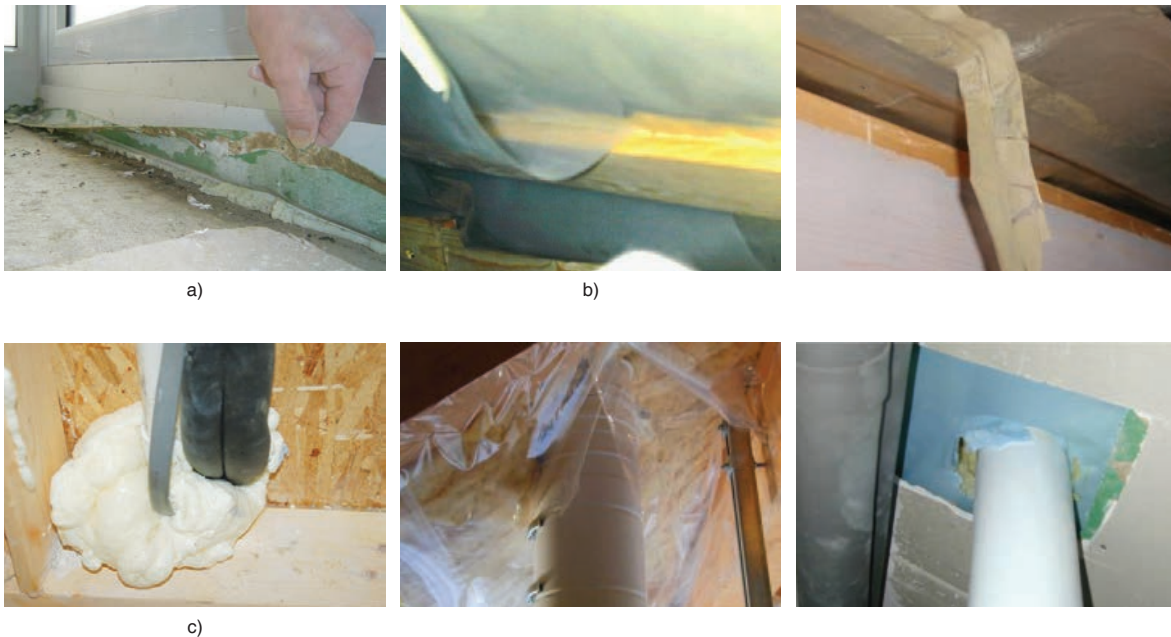
Slika 5-44 a) Neodgovarajuća priprema podloge; b) korištenje neodgovarajućih traka; c) loše brtvljenje proboja [177], [31]
