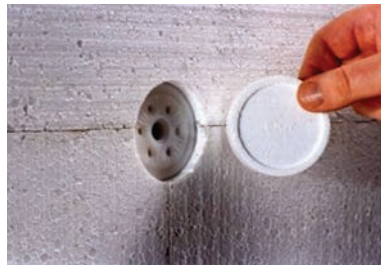
Slika 4-111 Upuštene glave spojnica
