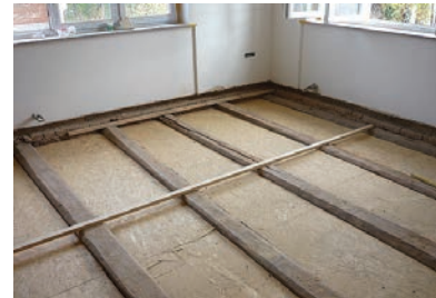
Slika 4-65 Strop od drvenih grednika [101]
