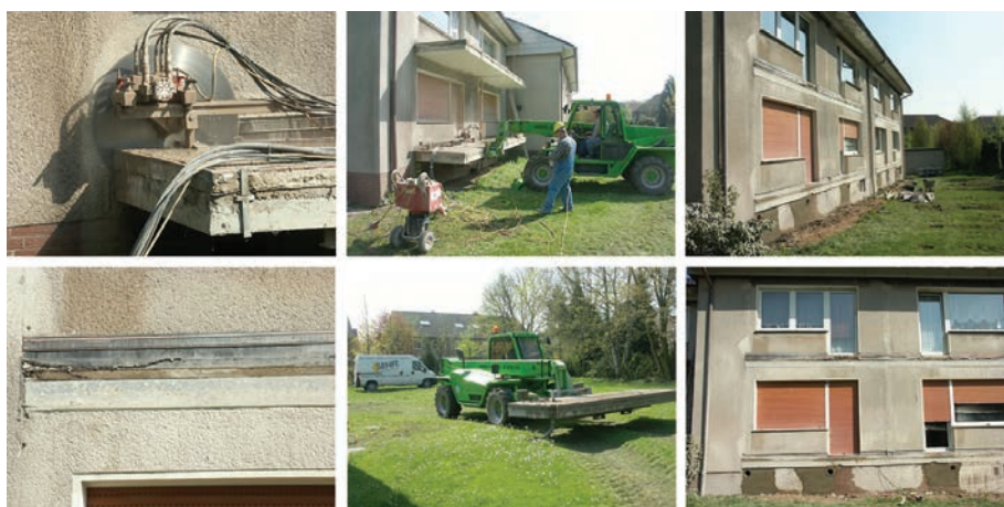
Slika 4-124 Uklanjanje AB balkona u svrhu energetske obnove
