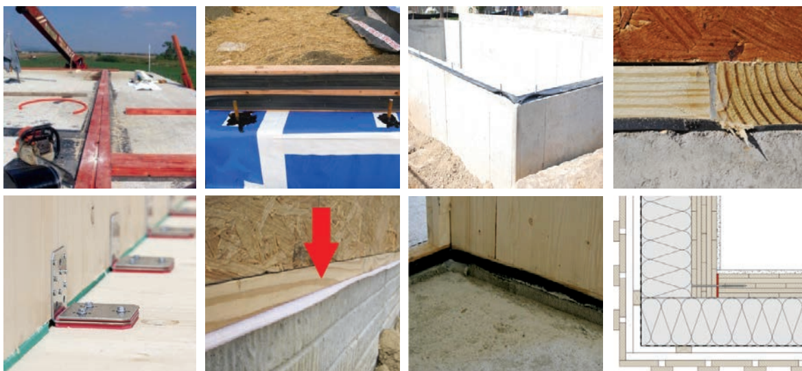
Slika 5-19 Brtljenje spojeva drvene konstrukcije [165], [167], [166], [168]
