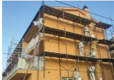
Slika 4-141 Čelična skela [143]
