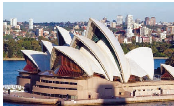
Slika 4-36 Prostorno površinski konstrukcijski sustav [83]
