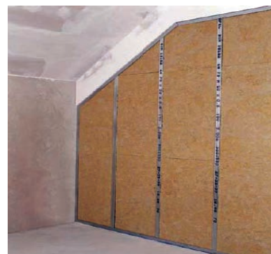
Slika 4-53 Pregradni zidovi od gipskartonskih ploča [92]
