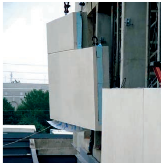
Slika 3-203 Primjer ugradnje betonskih panela s prethodno ugrađenim trakama za brtvljenje [185]
