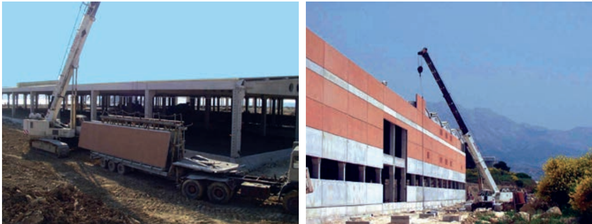
Slika 3-189 Ugradnja predgotovljenih betonskih panela korištenjem samohodne dizalice [56], [184]
