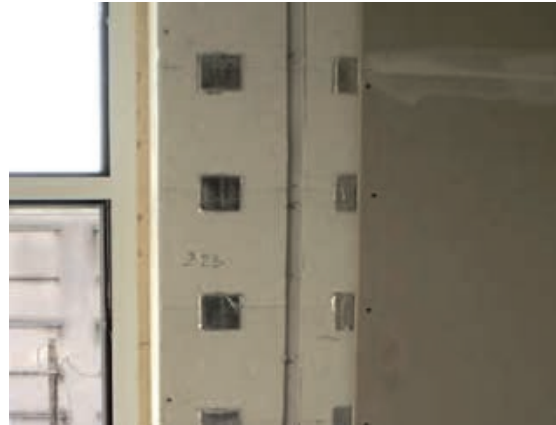
Slika 3-229 Pričvršćivanje gipskartonskih ploča [199]
