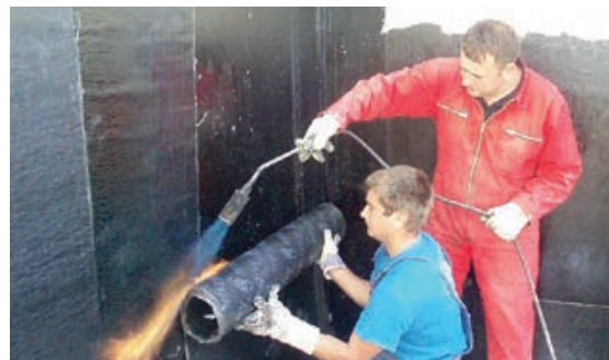
Slika 1-8 Izvedba hidroizolacije [8]
