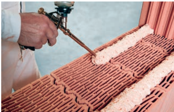
Slika 1-111 Nanošenje Porotherm dryfix extra [48]
