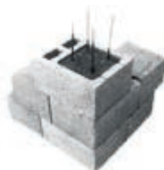
Slika 1-96 Blokovi za okomiti serklaž betonskih zidova
