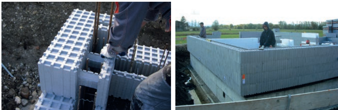
Slika 3-225 Zid ukupne debljine 43 cm građen ICF sustavom [200]
