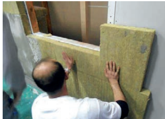
Slika 3-91 Postavljanje toplinsko-izolacijske ploče oko prozora – rezanje ploča [9]
