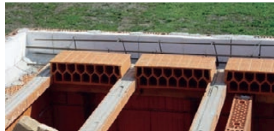
Slika 2-17 Postavljene stropne ispune na svakom kraju gredica [48]
