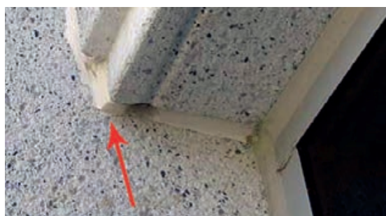
Slika 3-196 Rupa za odvođenje vlage iz predgotovljenih betonskih zidnih panela [185]
