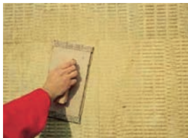
Slika 3-92 Brušenje EPS-a i mineralne vune [9], [119]
