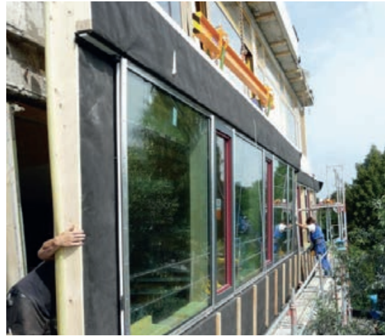
Slika 3-214 Ugradnja predgotovljenog drvenog panela s ventiliranom fasadom kao završnim slojem [195]
