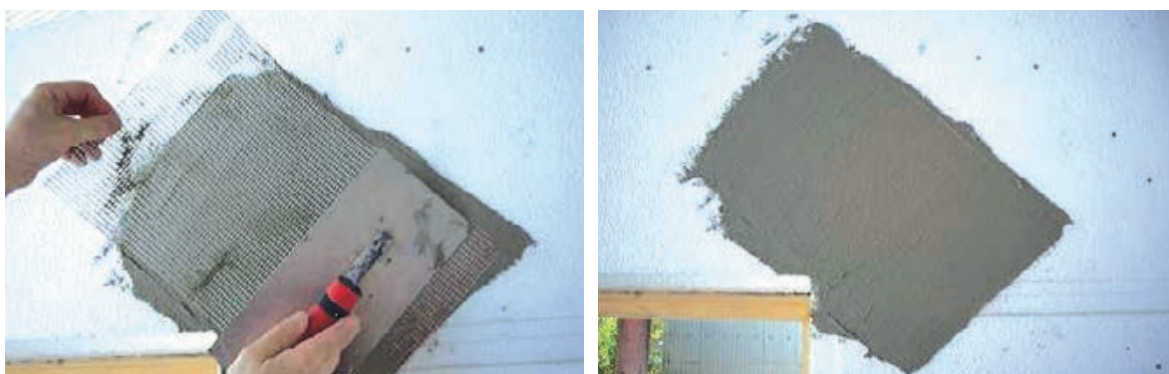
Slika 3 -110 Dijagonalno armiranje uglova prozora [9]
