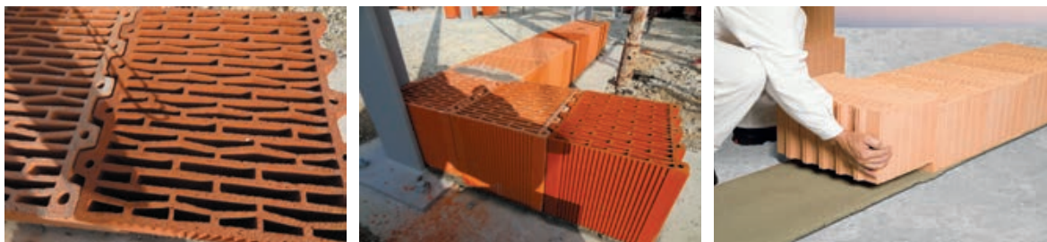
Slika 1-109 Izvedba prve ležajnice mortom i zidanje prvog reda zida [56]
