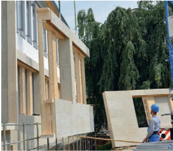
Slika 3-213 Ugradnja predgotovljenog fasadnog elementa na postojeću zgradu [194]
