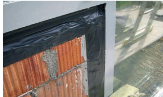
Slika 3-174 Primjer brtvljenja folijom [179]
