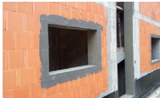
Slika 3-176 Žbukanje zidarskih otvora [180]
