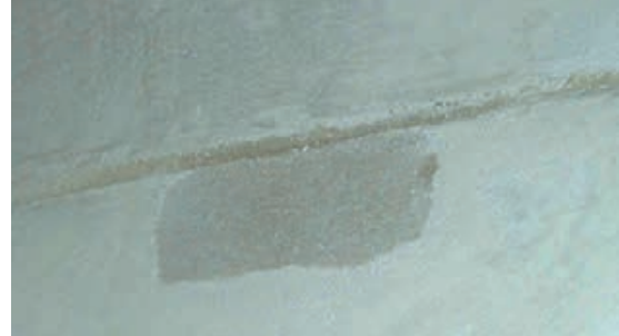
Slika 3-193 Završna obrada panela nakon dovršene ugradnje, mjesto kuke [184]
