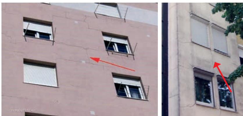
Slika 3-152 Neodgovarajuće ugrađen ETICS sustav
