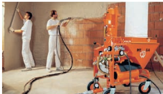
Slika 1-2 Unutarnje žbukanje [2]
