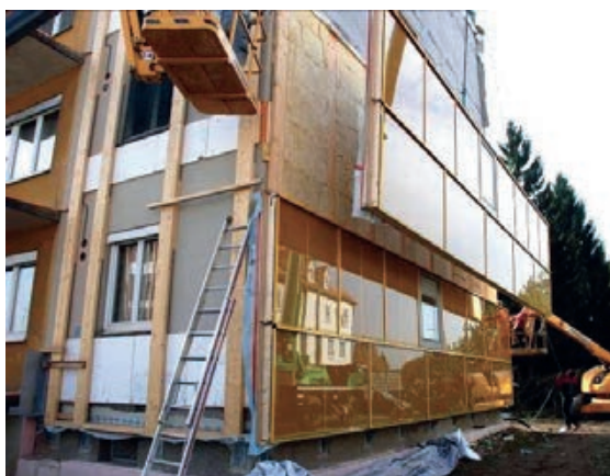
Slika 3-220 Ugradnja predgotovljenih panela [196]
