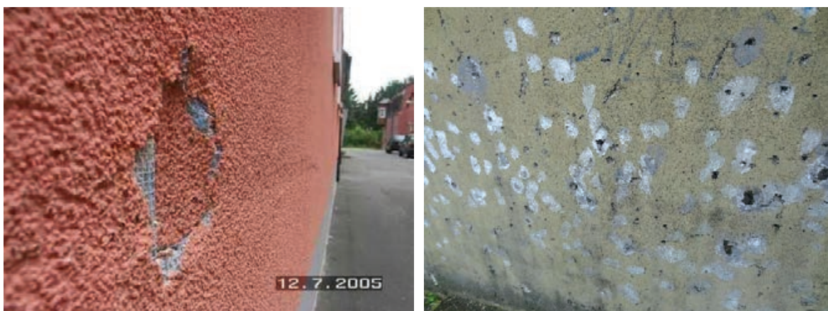
Slika 3-163 Posljedica difuzije vodene pare zbog loše ugradnje ploča EPS-a u ETICS sustav [168]
