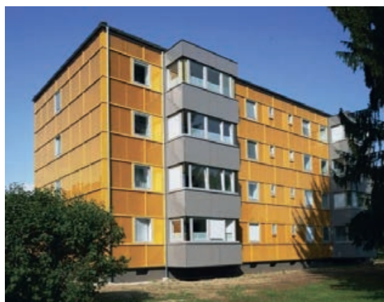
Slika 3-221 Pogled na završenu zgradu „Dieselweg Graz“ nakon obnove [196]
