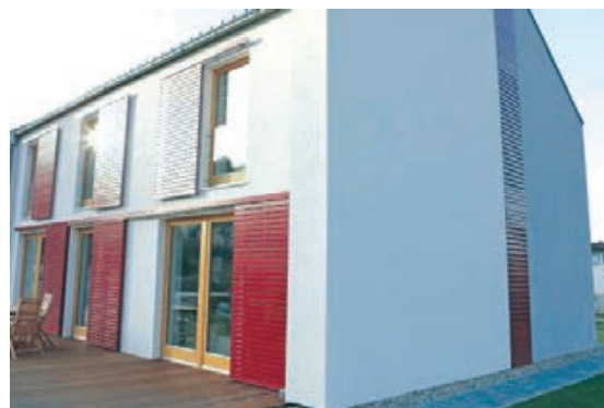
Slika 3-79 Podnožje u ravni s pročeljem i istim završnim slojem [9]
