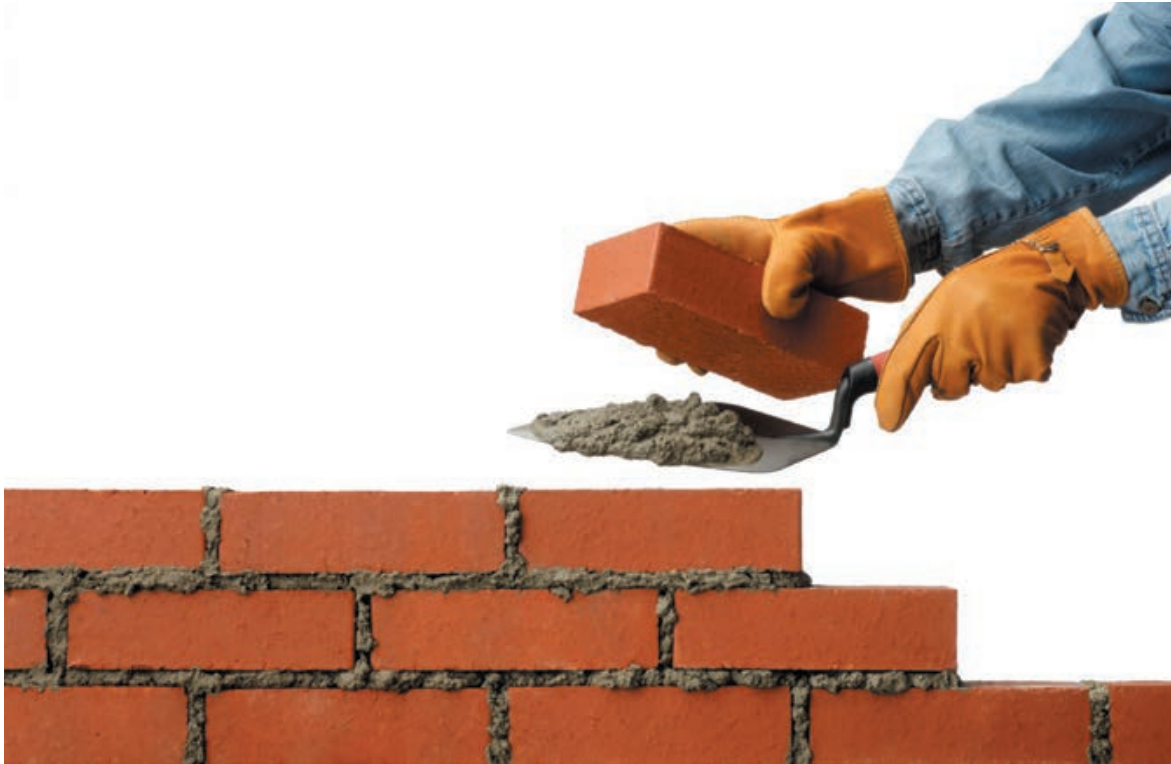
Slika 1-82 Prikaz zidanja mortom [71]
