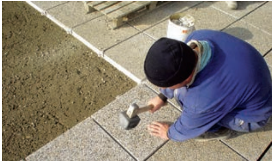
Slika 1-5 Izvedba vanjskih staza [5]
