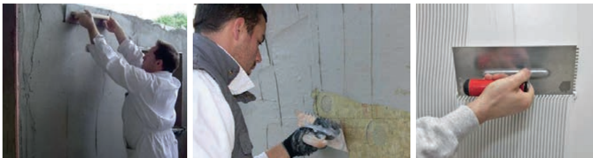
Slika 3-107 Nanošenje morta za armaturni sloj [9], [122]
