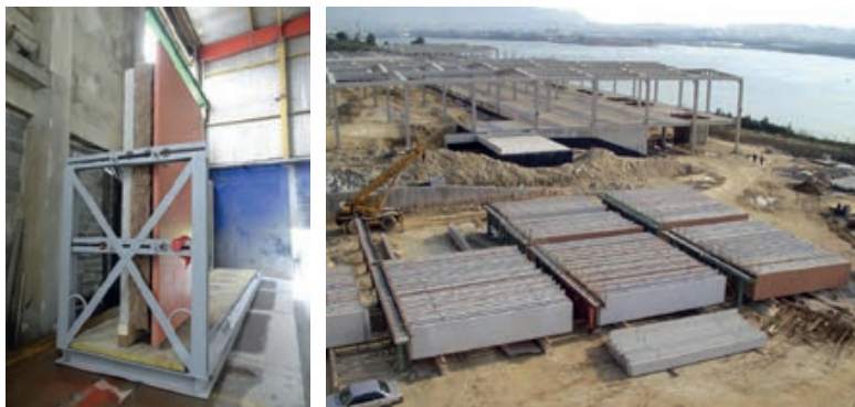
Slika 3-188 Skladištenje predgotovljenih betonskih elemenata u šoškama [56]
