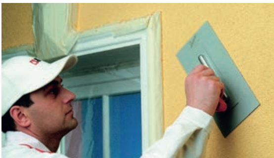
Slika 1-3 Fasadno žbukanje [3]
