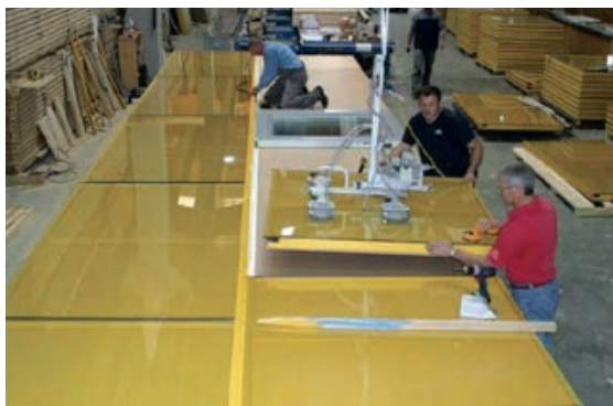
Slika 3-217 Ugradnja GAP solarnih elemenata na drveni okvir u radionici [196]
