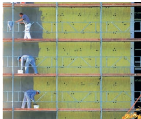
Slika 3-88 Postavljanje toplinsko-izolacijske ploče i lamele [9]
