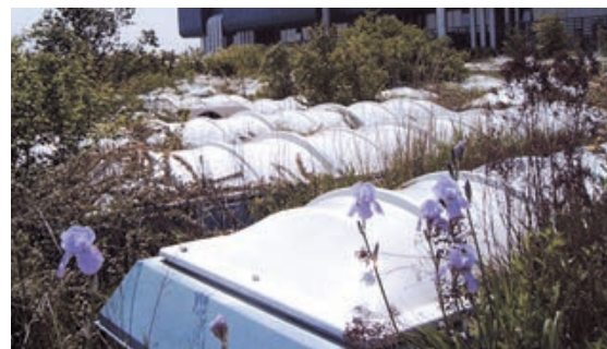
Slika 3-244 Primjer krova na kojem su zbog neodržavanja urasle biljke [207]
