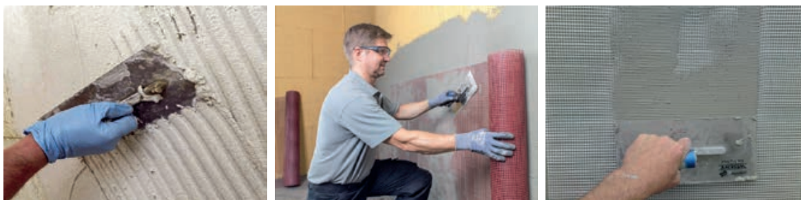
Slika 3-67 Nanošenje temeljnog polimer-cementnog sloja na mineralnu vunu (lijevo); utiskivanje staklene mrežice (desno) [9]
