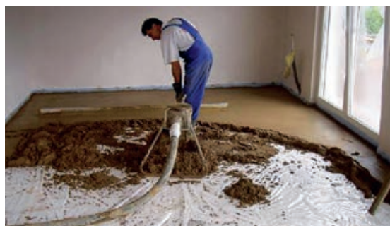
Slika 1-4 Izvedba podnih podloga [4]
