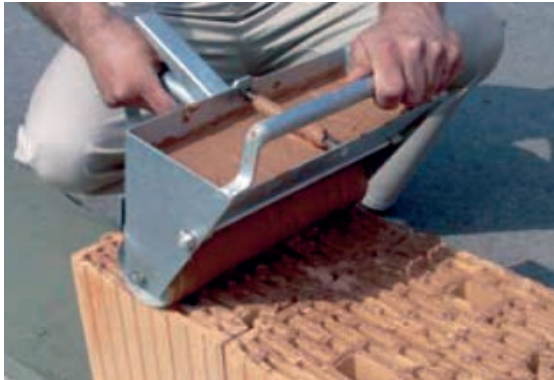
Slika 2-6 Nanošenje morta posebnim valjkom za zidanje [48]
