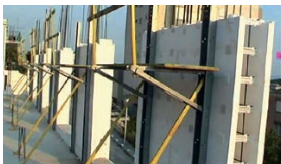
Slika 3-226 Podupiranje oplata ICF sustava [199]
