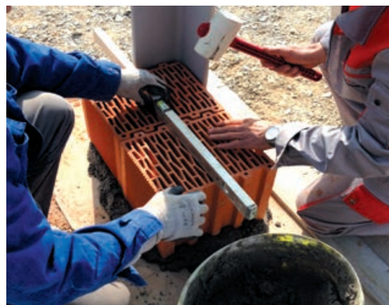
Slika 1-108 Izvedba prve ležajnice mortom i zidanje prvog reda zida [56]
