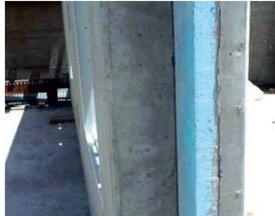
Slika 3-186 Presjek predgotovljenog zidnog panela tipa s EPS-om kao toplinskom izolacijom [56]
