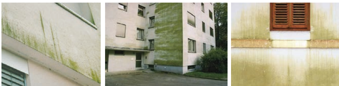
Slika 3-165 Pojava algi na završnom sloju ETICS sustava s vremenom, pogotovo na rubu gdje nema okapnice; dolazi do odvajanja žbuke zbog kiše koja stalno kaplje.
