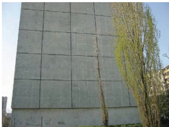
Slika 3-163 Posljedica difuzije vodene pare zbog loše ugradnje ploča EPS-a u ETICS sustav [168]
