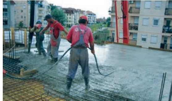
Slika 1-6 Betoniranje [6]
