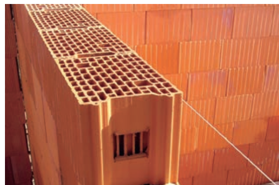
Slika 1-113 Postavljeni blok ne smije se više micati [48]
