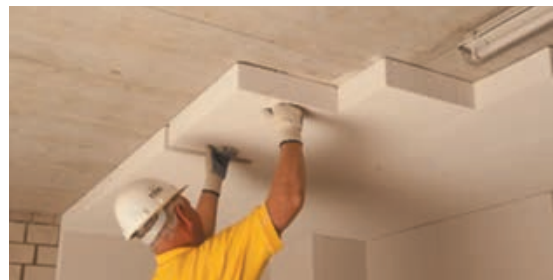
Slika 3-57 TI podrumskog stropa [107]
