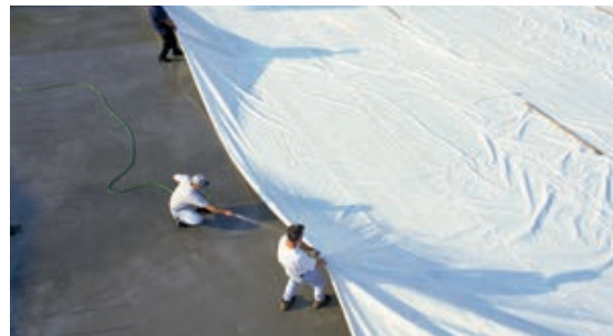
Slika 1-79 Prekrivanje plastičnom folijom [68]
