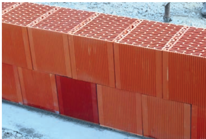
Slika 1-114 Zazidani drugi sloj zida [56]
