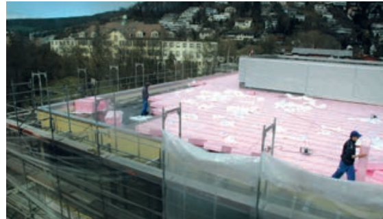
Slika 3-241 Postavljanje hidroizolacije na ravan krov [205]
