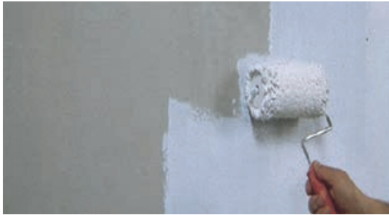
Slika 3-68 Nanošenje predpremaza [9]
