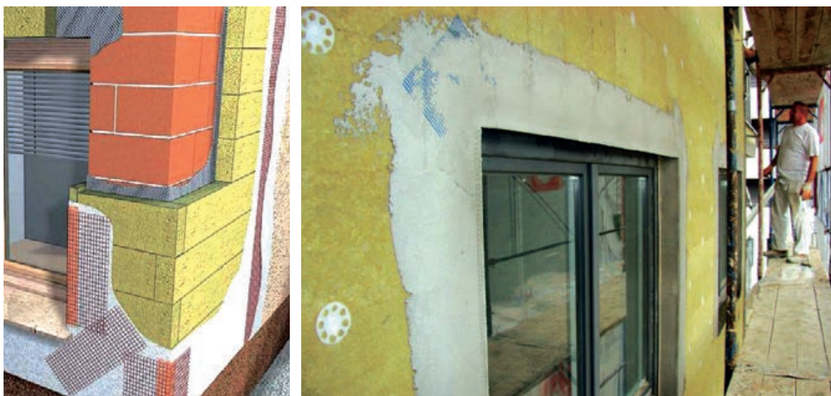
Slika 3-115 Izvedba ruba i kuta pomoću kutnog profila [9], [131]
