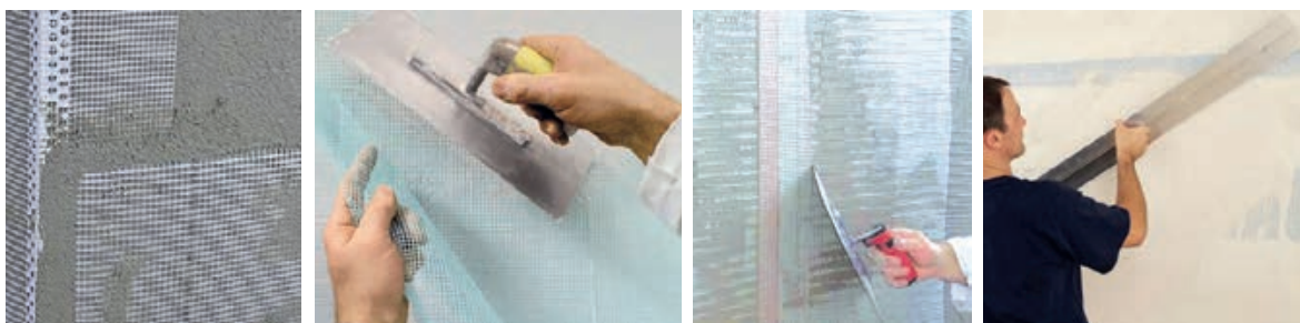
Slika 3-108 Umetanje staklene mrežice u prvi sloj morta [123], [124], [9]
