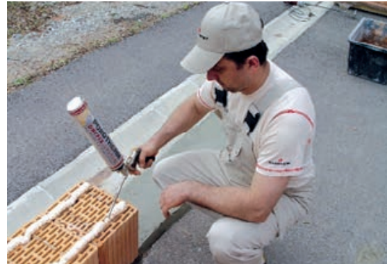
Slika 2-7 Nanošenje poliuretanskog ljepila [48]
