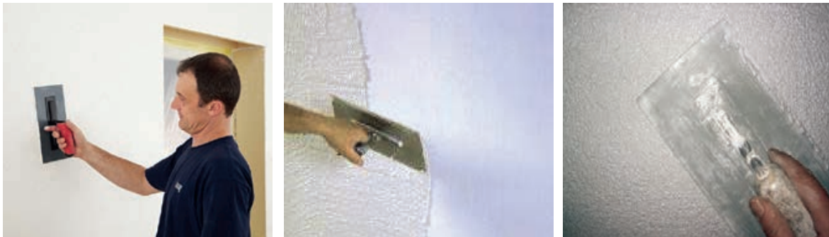
Slika 3-135 Nanošenje završno-dekorativne žbuke [9]
