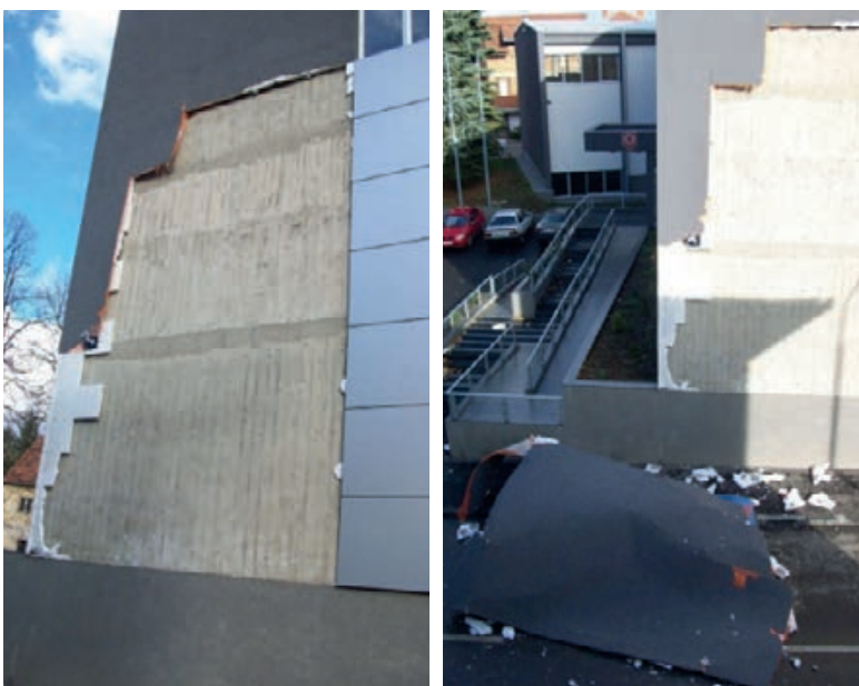
Slika 3-146 Neodgovarajuće ugrađen ETICS sustav, Poljoprivredni fakultet Vlasenica, BiH, studeni 2012. [9]
