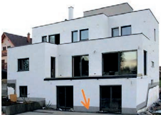
Slika 3-78 Podnožje u ravni s pročeljem i odvojenim / različitim završnim slojem [9]
