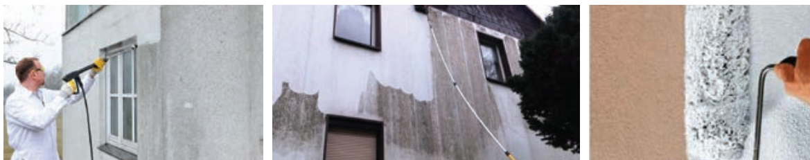
Slika 3-167 Sanacija pojave algi i gljivica [171], [172]
