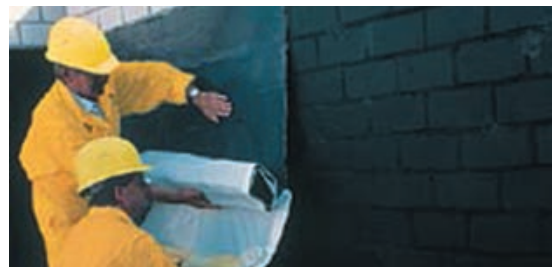
Slika 1-103 Postava hidroizolacije [76]
