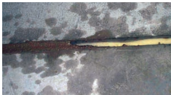
Slika 3-195 Baza (podloga) u reški prije brtvljenja [184]
