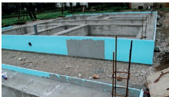
Slika 3-46 HI i TI trakastih temelja [104]
