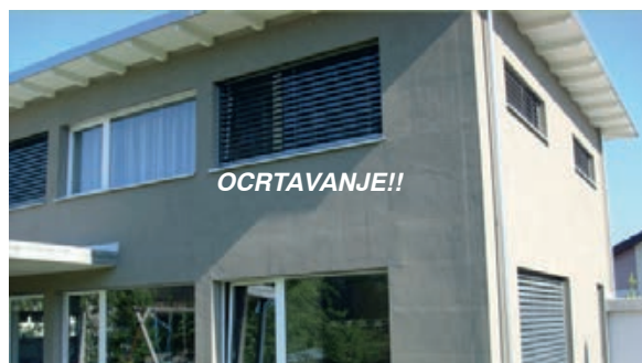
Slika 3-82 Deformacije kod toplinsko-izolacijskih materijala, shematski i primjer lošeg izvođenja [9], [115]
