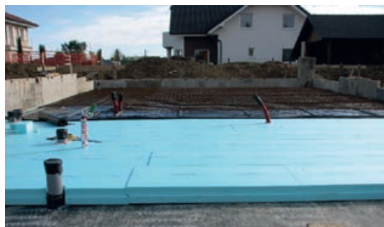
Slika 3-48 TI temeljne ploče [104]
