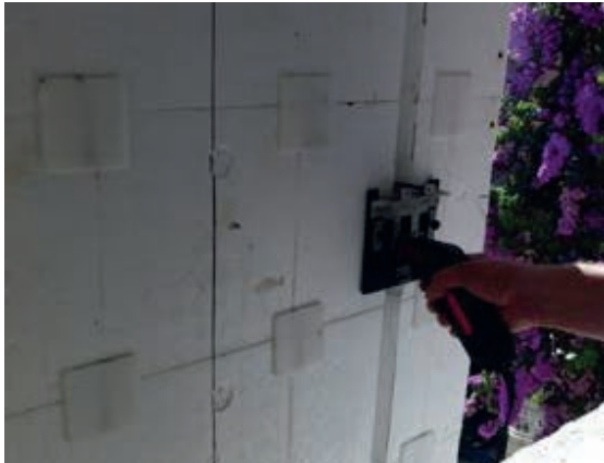
Slika 3-228 Usijecanje kanala za instalacije [199]
