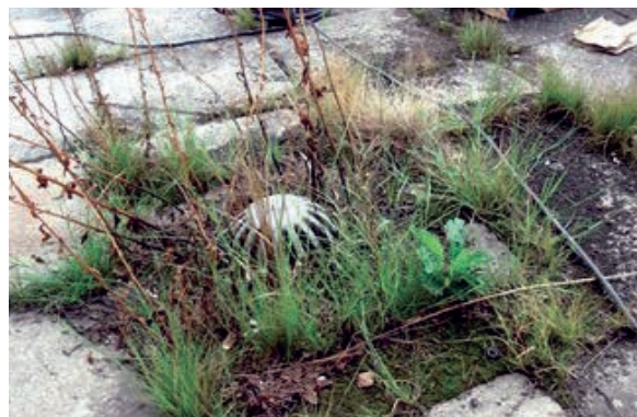
Slika 3-245 Otpad na krovu i lišćem začepljeni slivnik [207]
