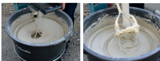
Slika 3-62 Priprema polimer-cementnog ljepila [109]
