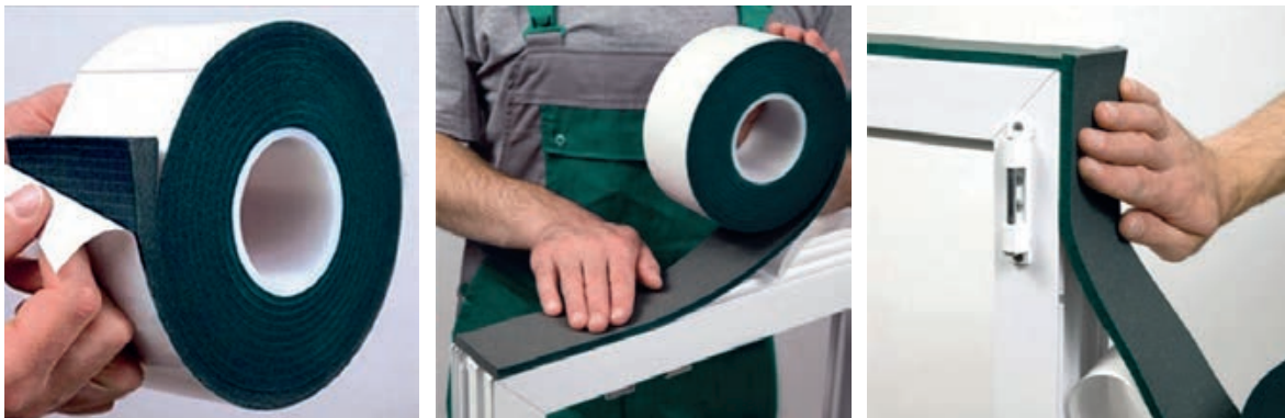
Slika 3-175 Brtvljenje pomoću brtvenih traka [178]
